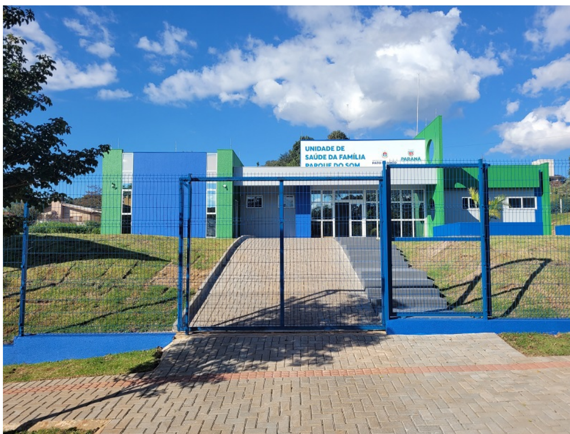
Foto 2: Fachada da Obra. Cercamento. Acesso, grama.
