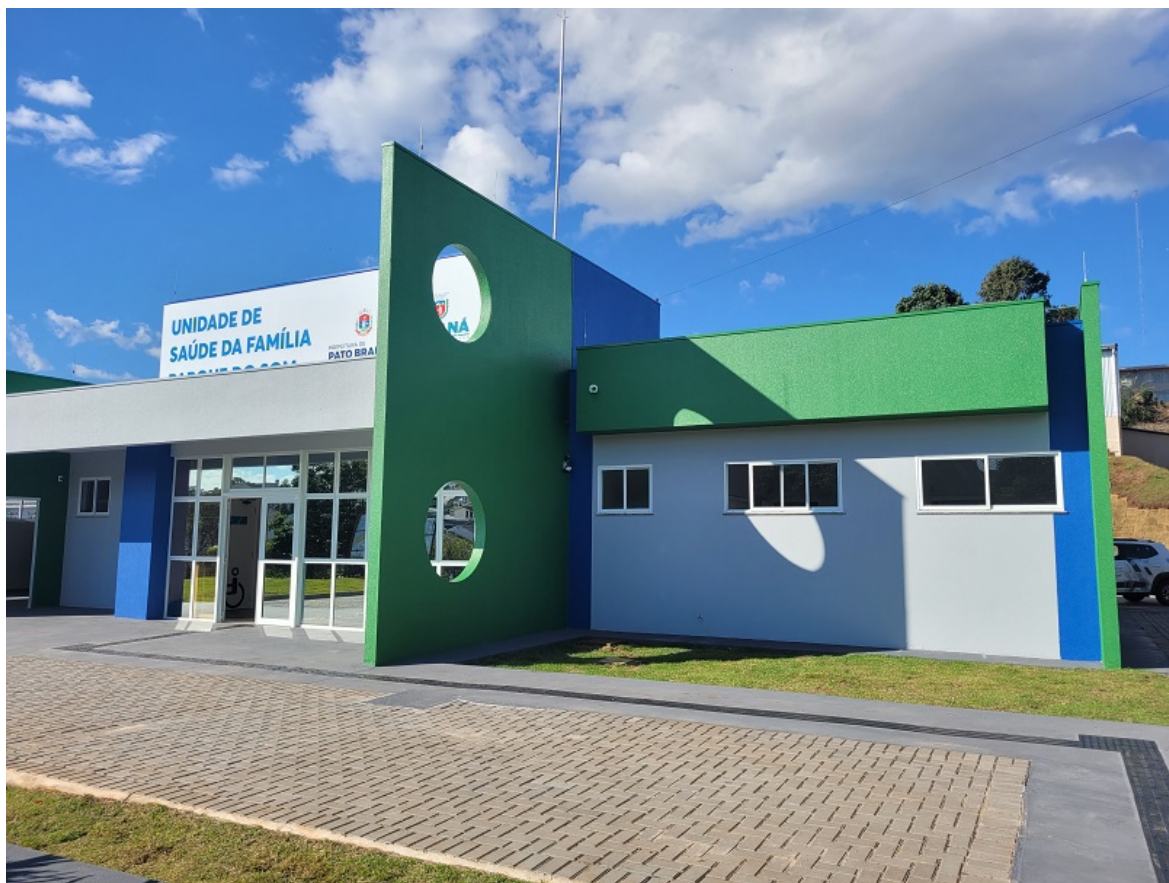
Foto 1: Fachada da Obra (execução da pintura externa, paver e calçada)
