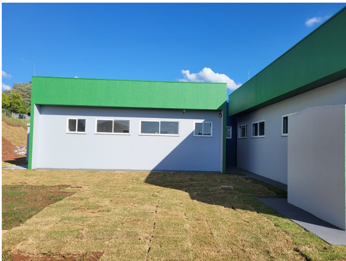
Foto 8: Lateral da Obra (área externa).
