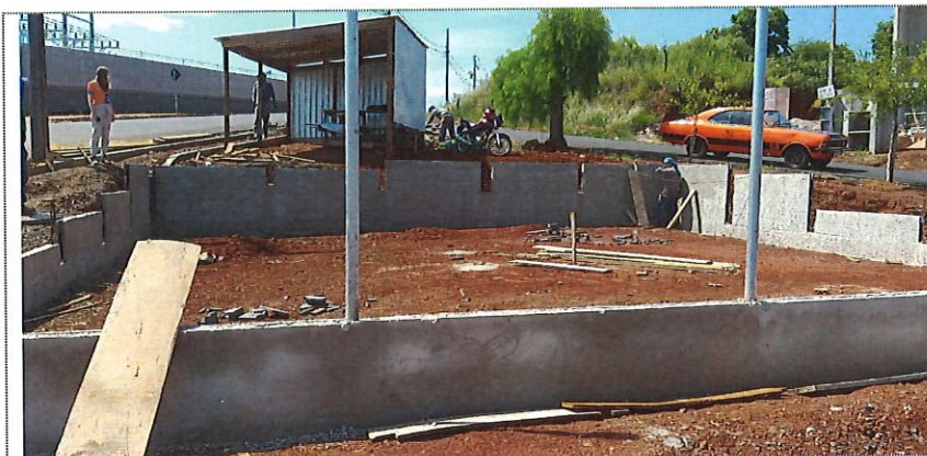
Alvenaria de vedação do playground
