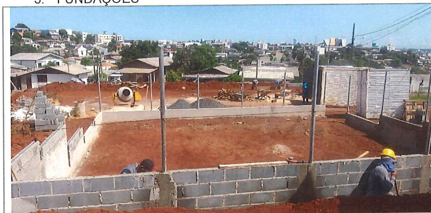
Estaca broca e camada drenante playground
