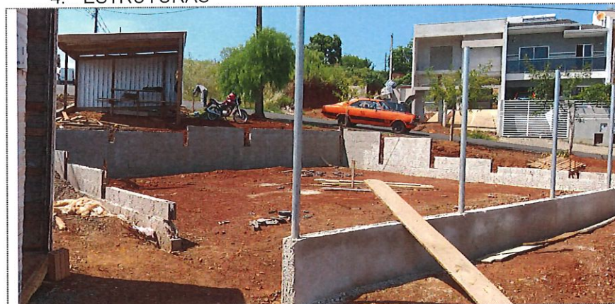
Execução de viga baldrame no entorno do playground
