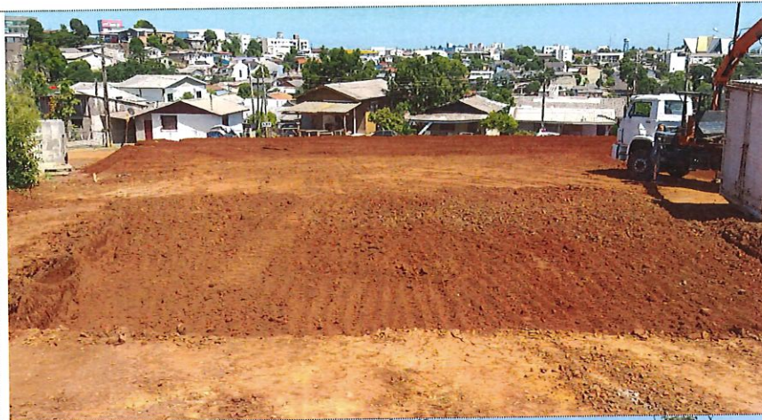
Limpeza do terreno
