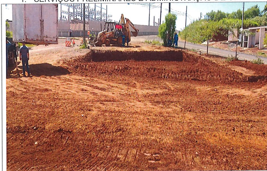
Limpeza do terreno
