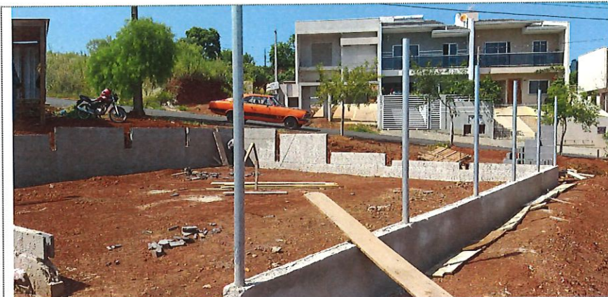
Escavação e reaterro vala playground
