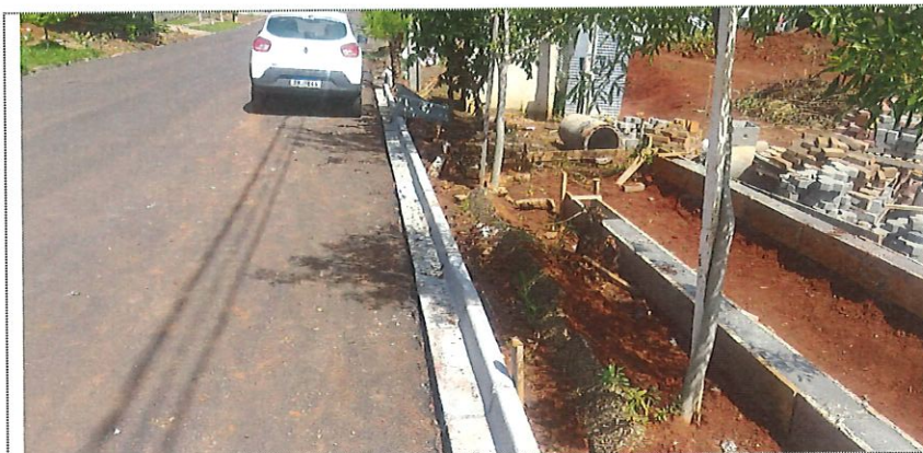
Retirada de meio fio danificado
