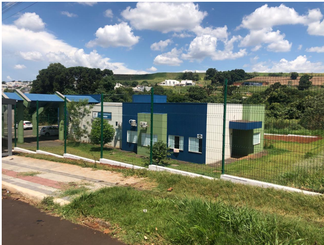
Foto 1: Cercamento frente da unidade.
