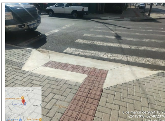
9 - PAVIMENTAÇÃO EM CBUQ / PAVER
