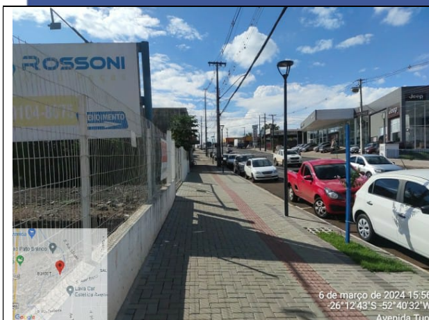
29 - PAVIMENTAÇÃO EM CBUQ / PAVER
