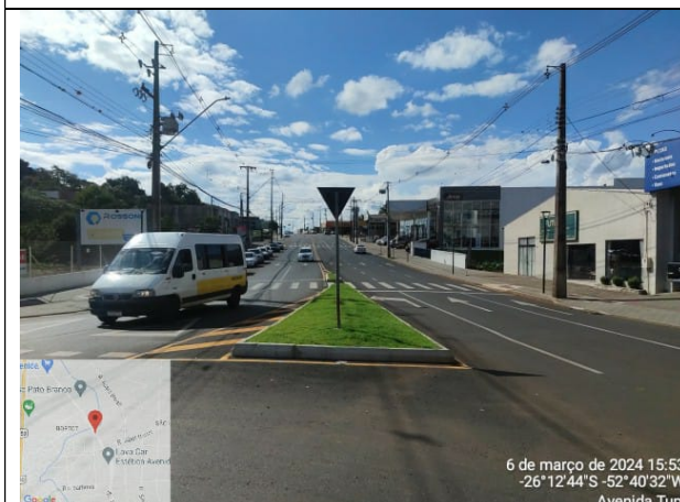
31 - PAVIMENTAÇÃO EM CBUQ / PAVER
