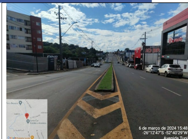
24 - PAVIMENTAÇÃO EM CBUQ / PAVER
