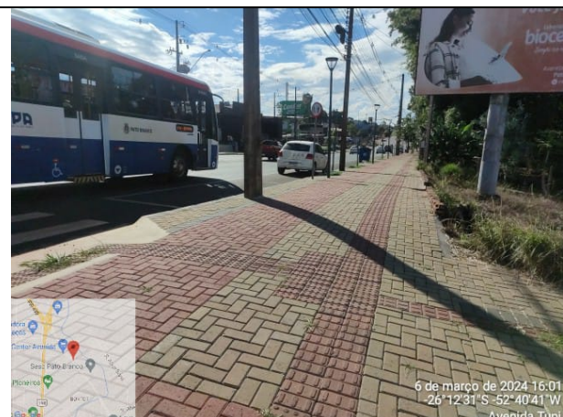
32 - PAVIMENTAÇÃO EM CBUQ / PAVER
