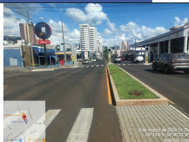
12 - PAVIMENTAÇÃO EM CBUQ / PAVER
