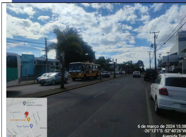
23 - PAVIMENTAÇÃO EM CBUQ / PAVER
