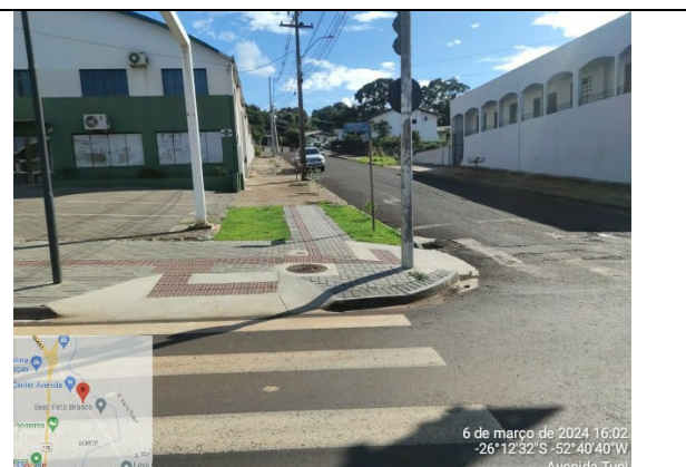
34 - PAVIMENTAÇÃO EM CBUQ / PAVER
