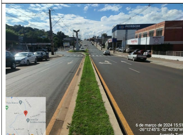
25 - PAVIMENTAÇÃO EM CBUQ / PAVER
