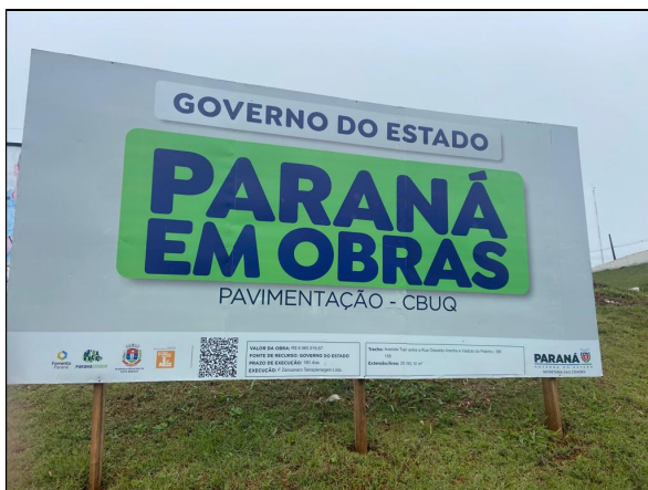
1 - PLACA DA OBRA ATUALIZADA
