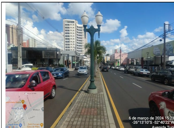
5 - PAVIMENTAÇÃO EM CBUQ / PAVER
