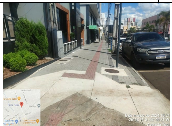
4 - PAVIMENTAÇÃO EM CBUQ / PAVER
