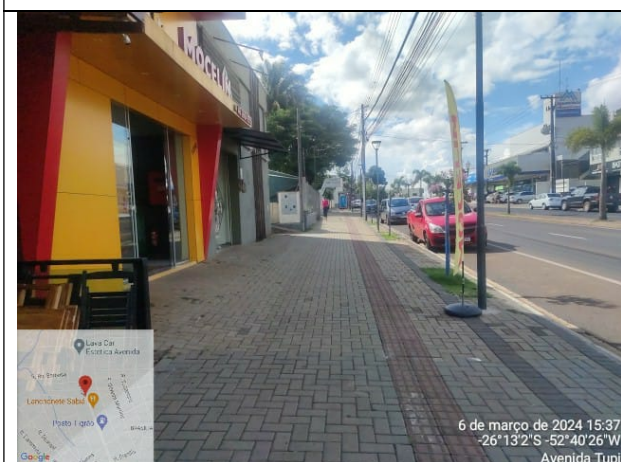
20 - PAVIMENTAÇÃO EM CBUQ / PAVER
