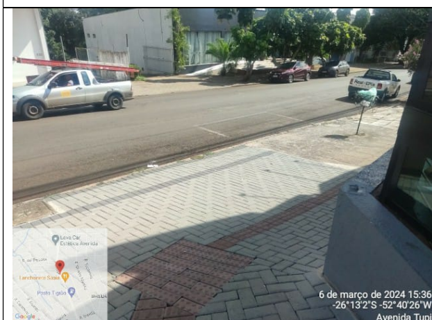
19 - PAVIMENTAÇÃO EM CBUQ / PAVER
