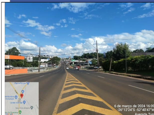
35 - PAVIMENTAÇÃO EM CBUQ / PAVER
