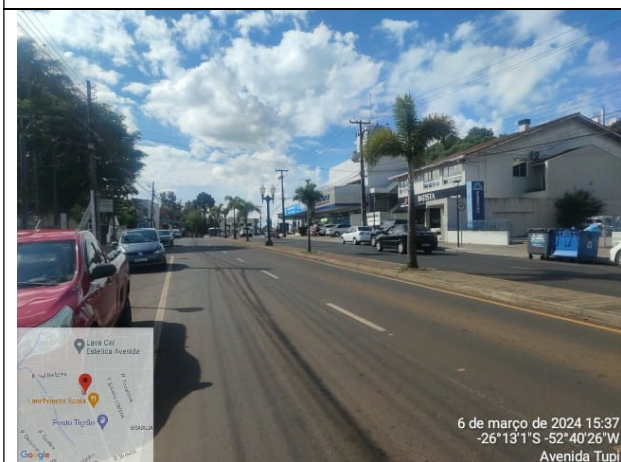
22 - PAVIMENTAÇÃO EM CBUQ / PAVER
