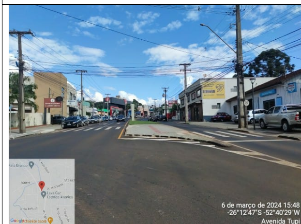
21 - PAVIMENTAÇÃO EM CBUQ / PAVER
