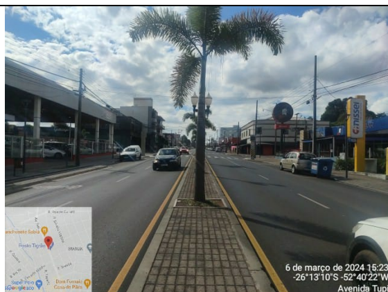
3 - PAVIMENTAÇÃO EM CBUQ / PAVER
