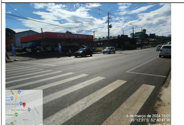
33 - PAVIMENTAÇÃO EM CBUQ / PAVER
