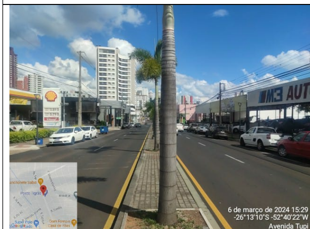
15 - PAVIMENTAÇÃO EM CBUQ / PAVER
