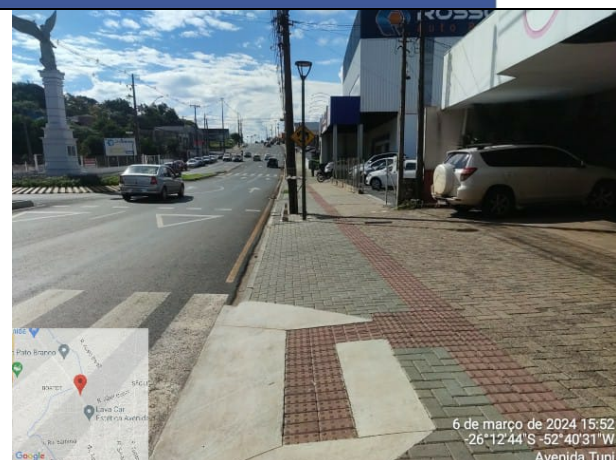
30 - PAVIMENTAÇÃO EM CBUQ / PAVER
