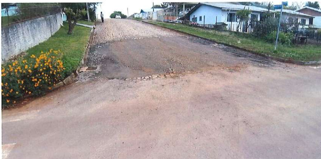
Foto 13: Rua do Príncipe – reforço de base
