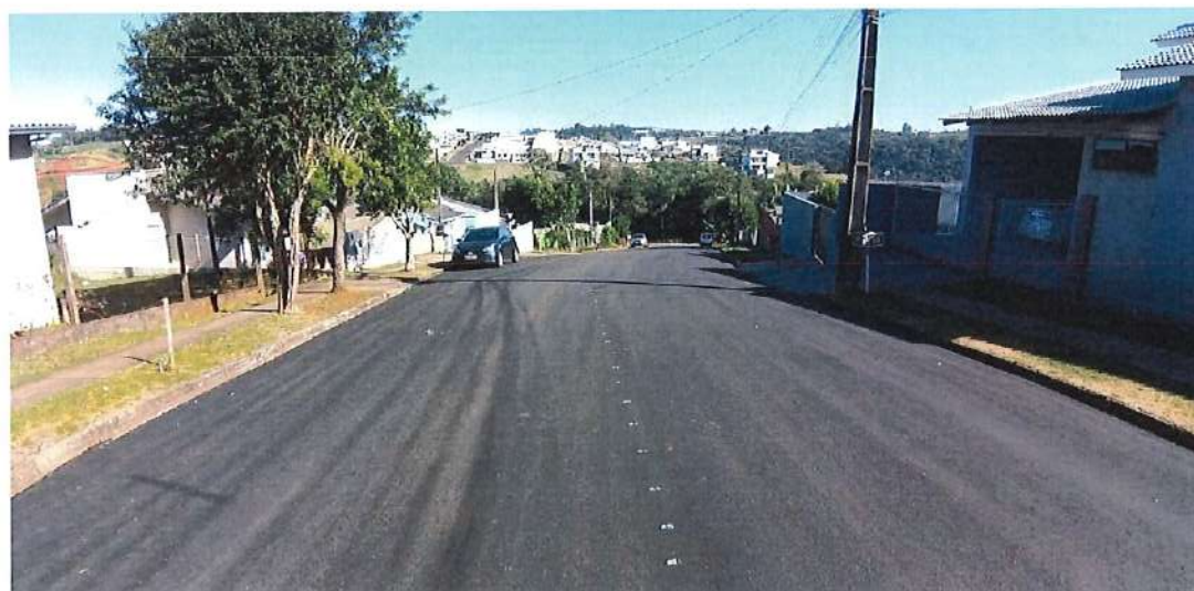
Foto 39: Rua Tuiuti - pavimentação
