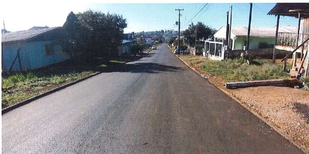
Foto 18: Rua do Príncipe – pavimentação
