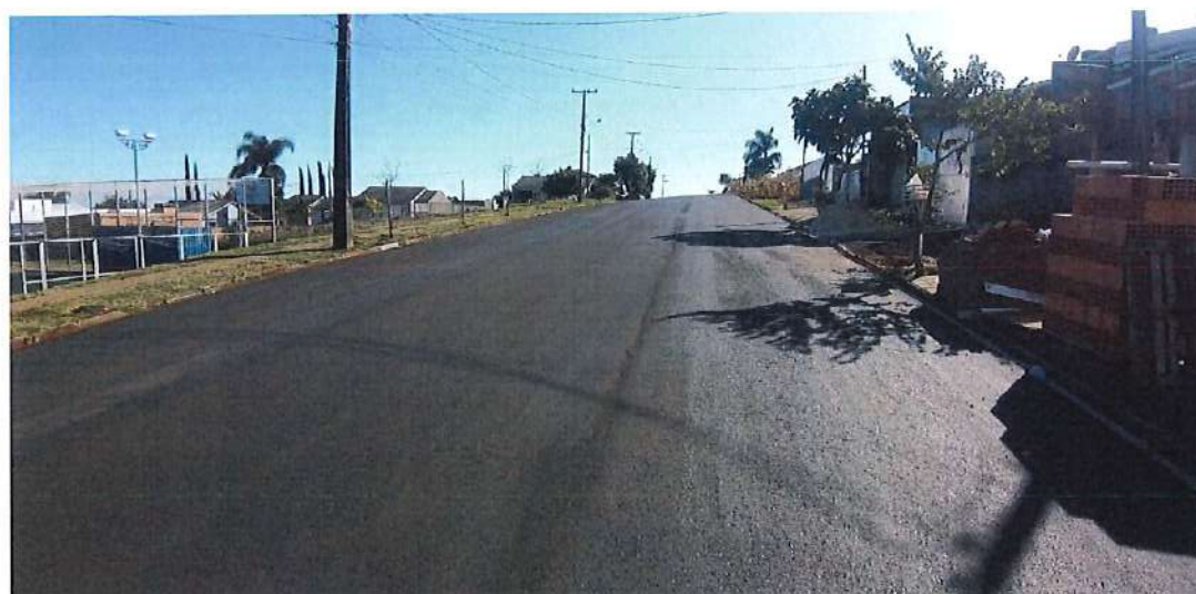
Foto 45: Rua Melci Dal Molin – pavimentação
