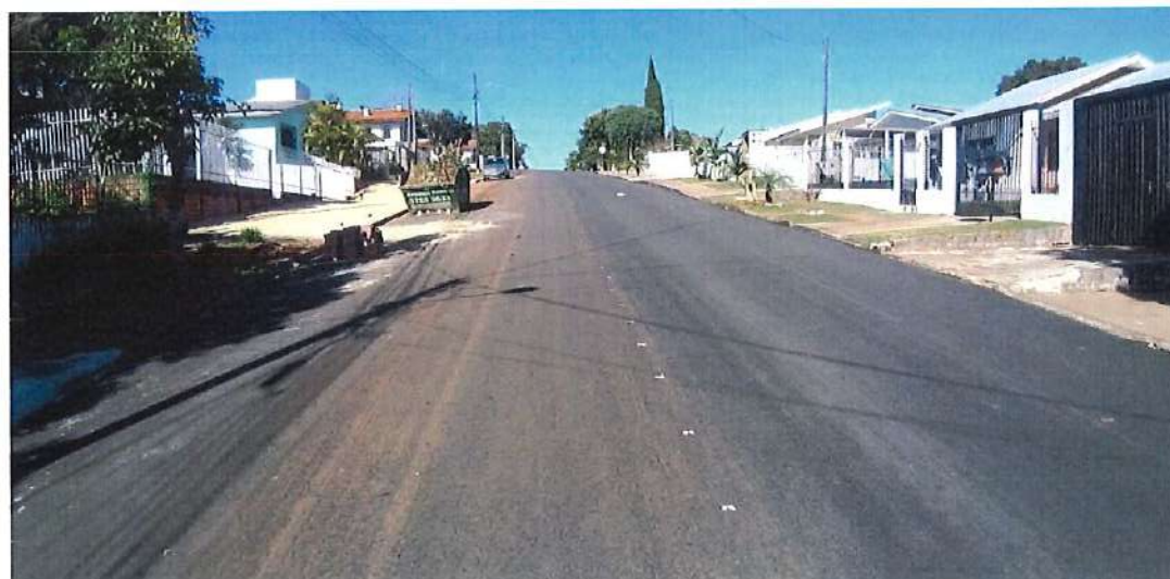
Foto 30: Rua Vieira da Costa – pavimentação
