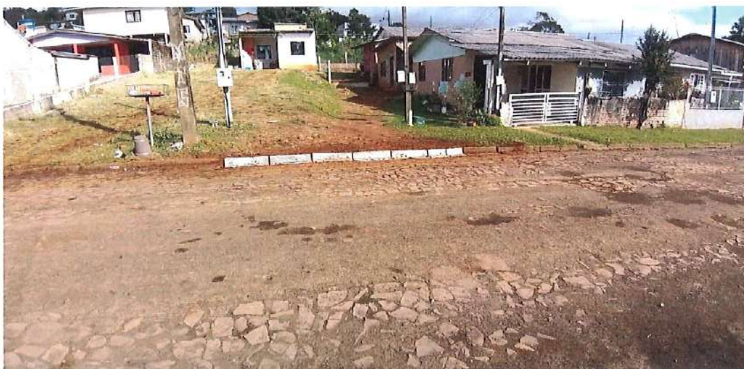
Foto 09: Rua Papa João XXIII – reforço de base e meio fio
