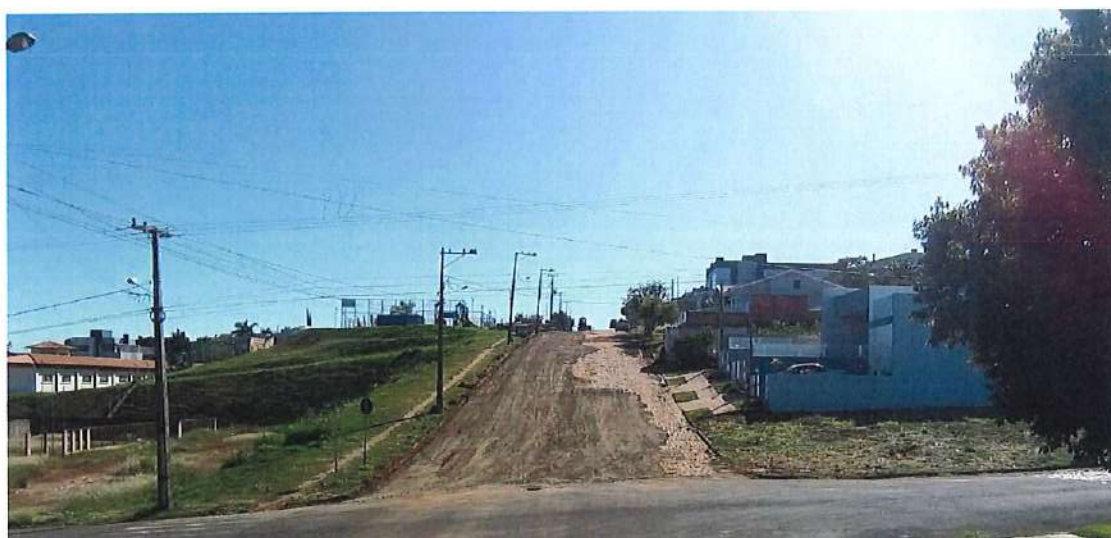
Foto 42: Rua Melci Dal Molin – reforço de base
