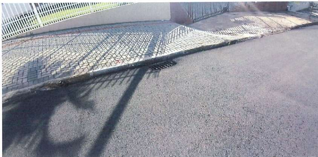
Foto 52: Rua Pedro José da Silvia (Trecho 01) – drenagem
