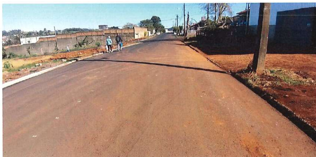
Foto 36: Rua Tuiuti - pavimentação e meio fio
