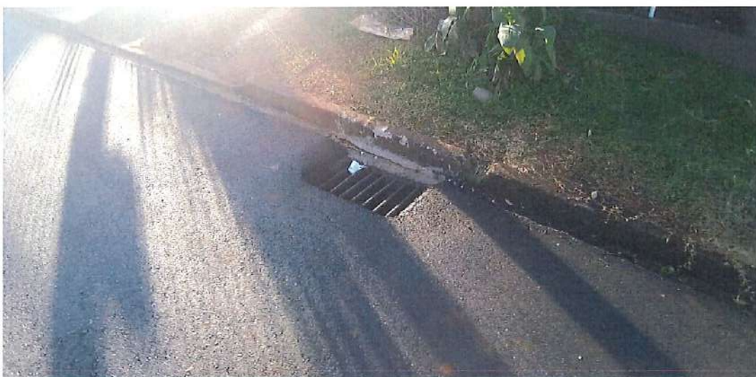
Foto 65: Rua 14 de Dezembro – drenagem
