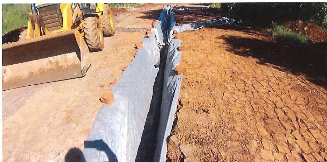
Foto 26: Rua Vieira da Costa – execução de dreno
