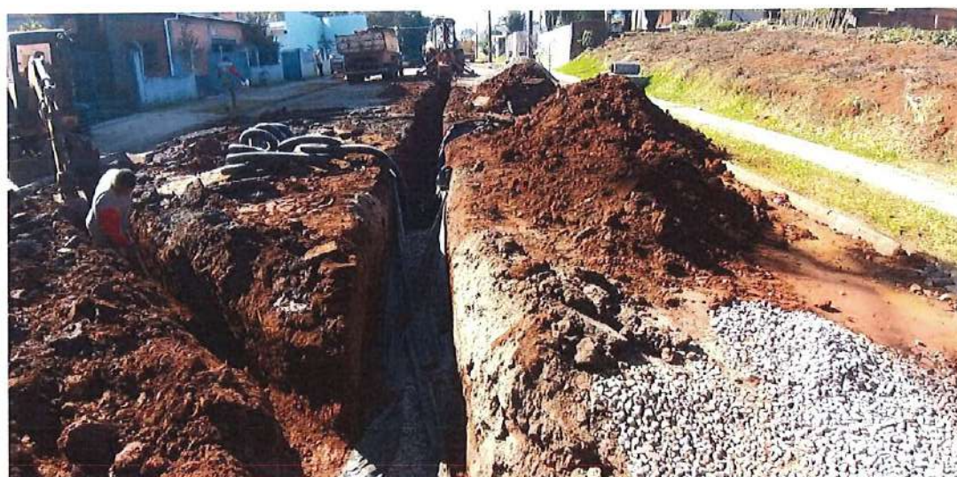
Foto 53: Rua José Fraron – execução de dreno
