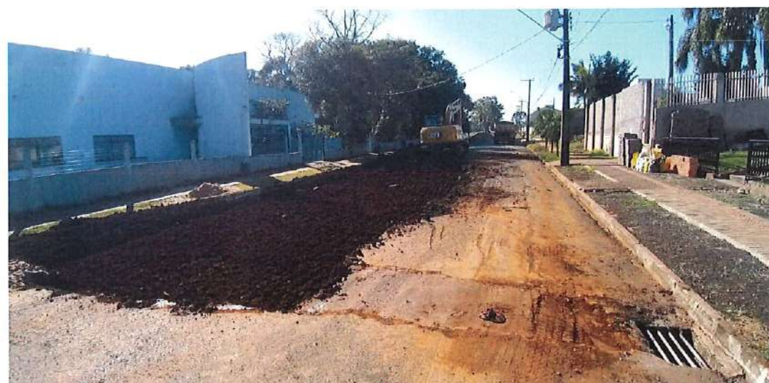
Foto 54: Rua José Fraron – reforço de base e drenagem
