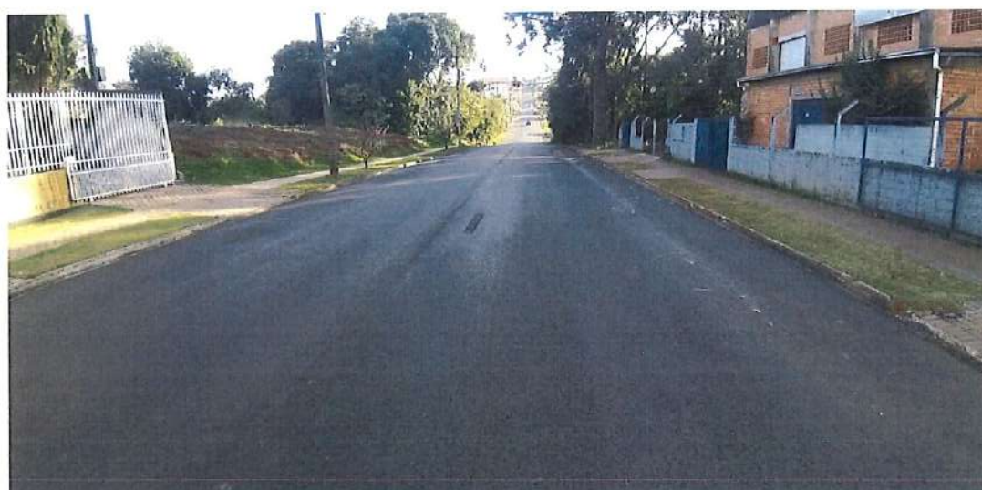
Foto 56: Rua José Fraron – pavimentação
