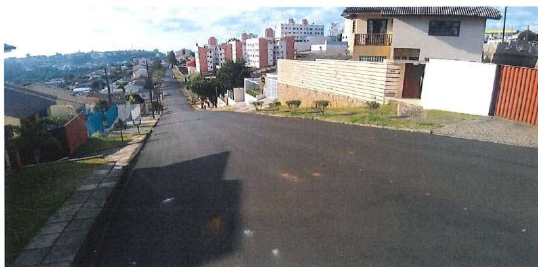
Foto 51: Rua Pedro José da Silva (Trecho 01) – pavimentação
