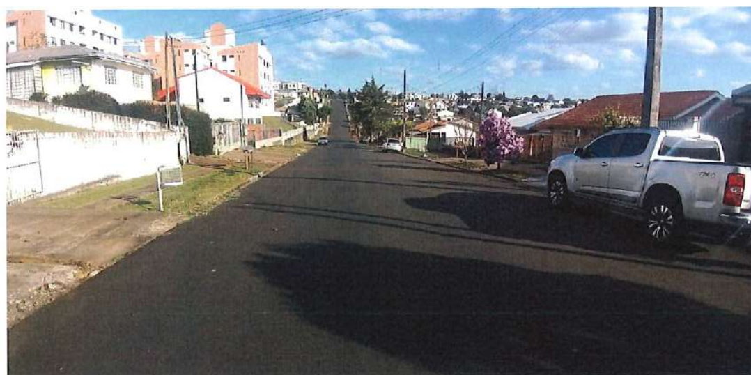
Foto 48: Rua Pedro José da Silva (Trecho 01) – pavimentação
