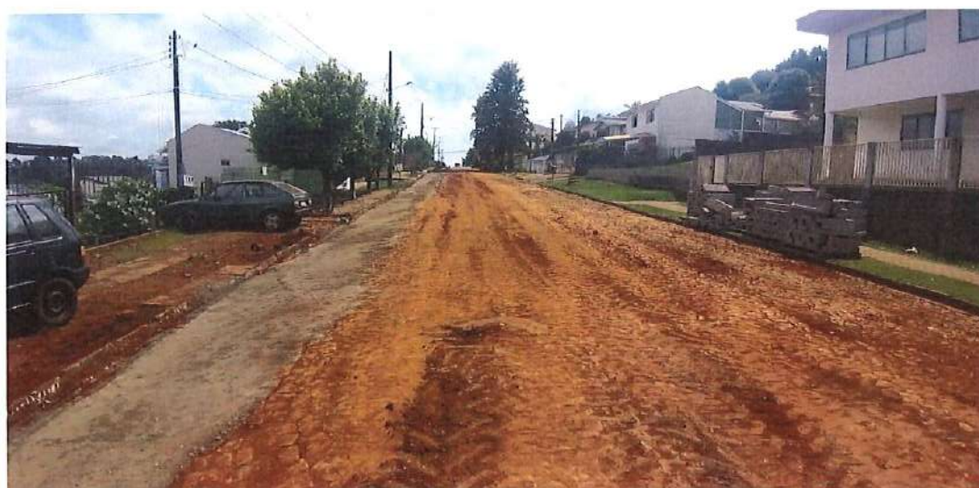
Foto 47: Rua Pedro José da Silva (Trecho 01) – reforço de base e drenagem
