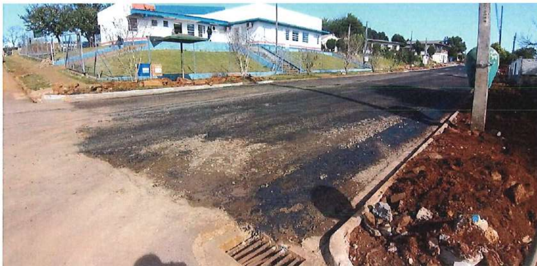
Foto 61: Rua 14 de Dezembro – reforço de base
