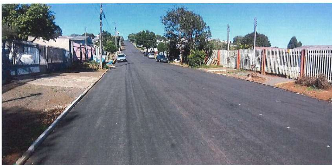
Foto 32: Rua Vieira da Costa – pavimentação e meio fio
