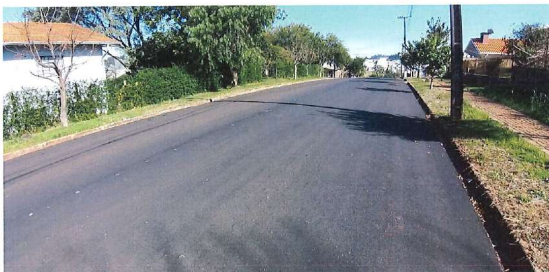
Foto 38: Rua Tuiuti - pavimentação
