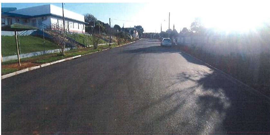
Foto 62: Rua 14 de Dezembro – pavimentação
