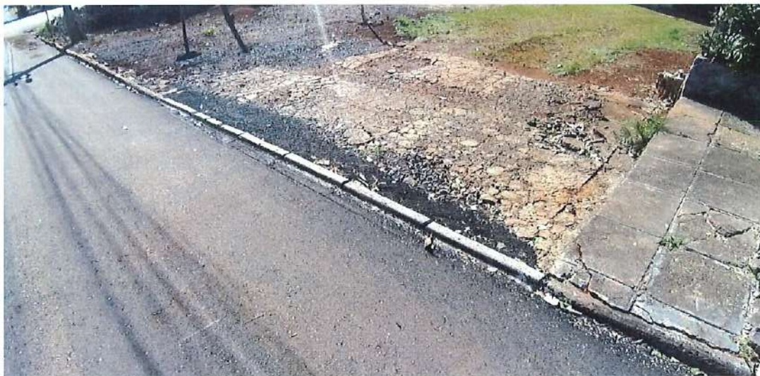
Foto 31: Rua Vieira da Costa – meio fio
