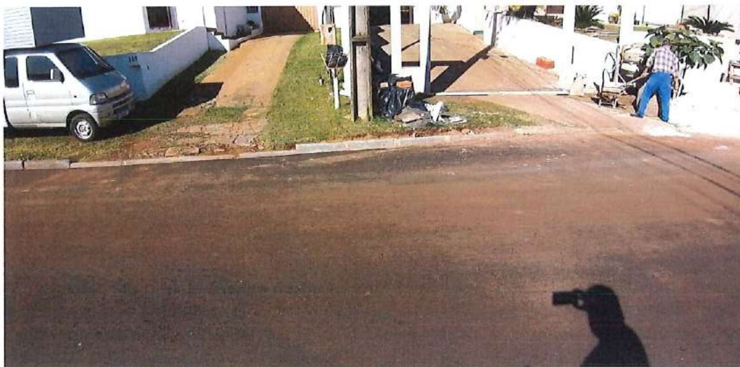
Foto 22: Rua Aldoino Dalmolin - meio fio
