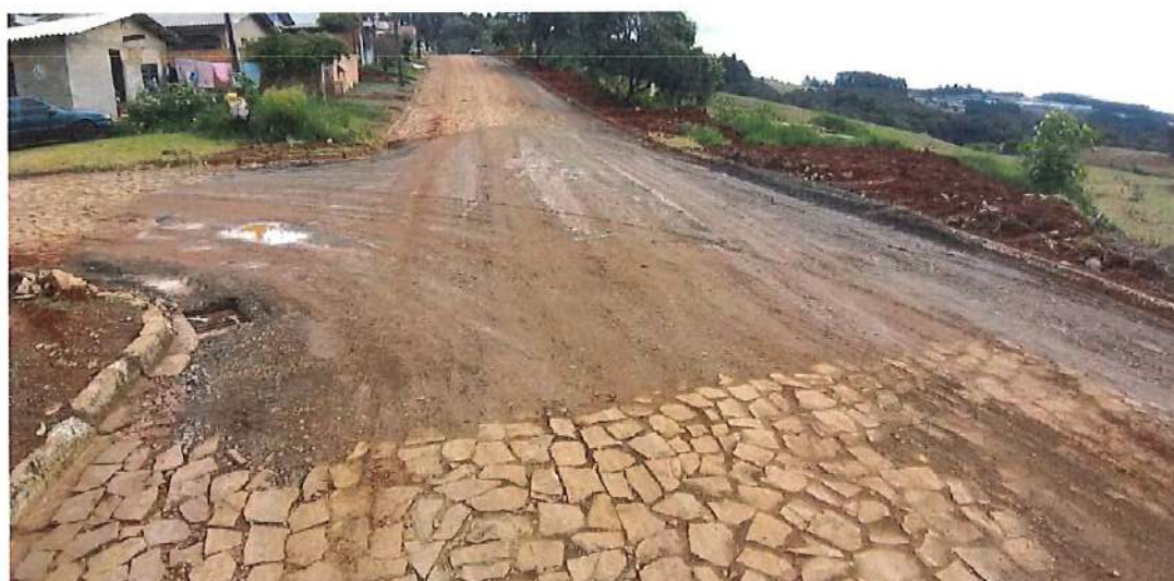
Foto 12: Rua do Príncipe – reforço de base
