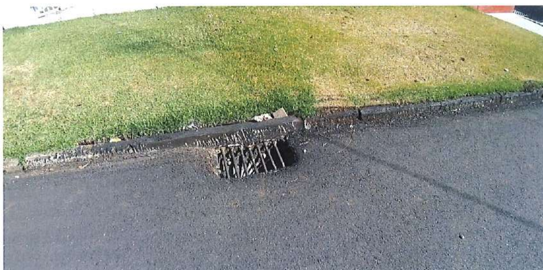
Foto 33: Rua Vieira da Costa – drenagem
