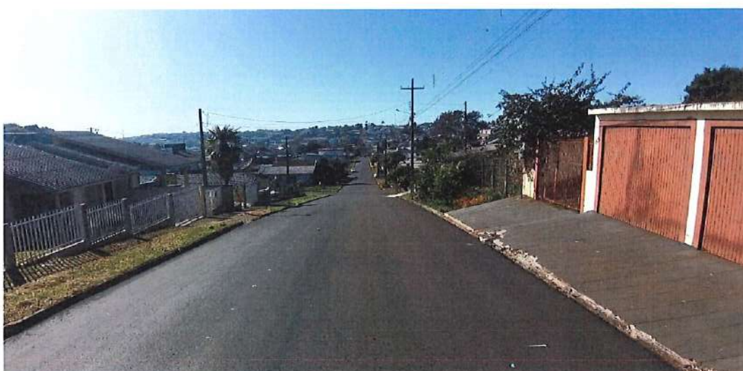
Foto 17: Rua do Príncipe – pavimentação
