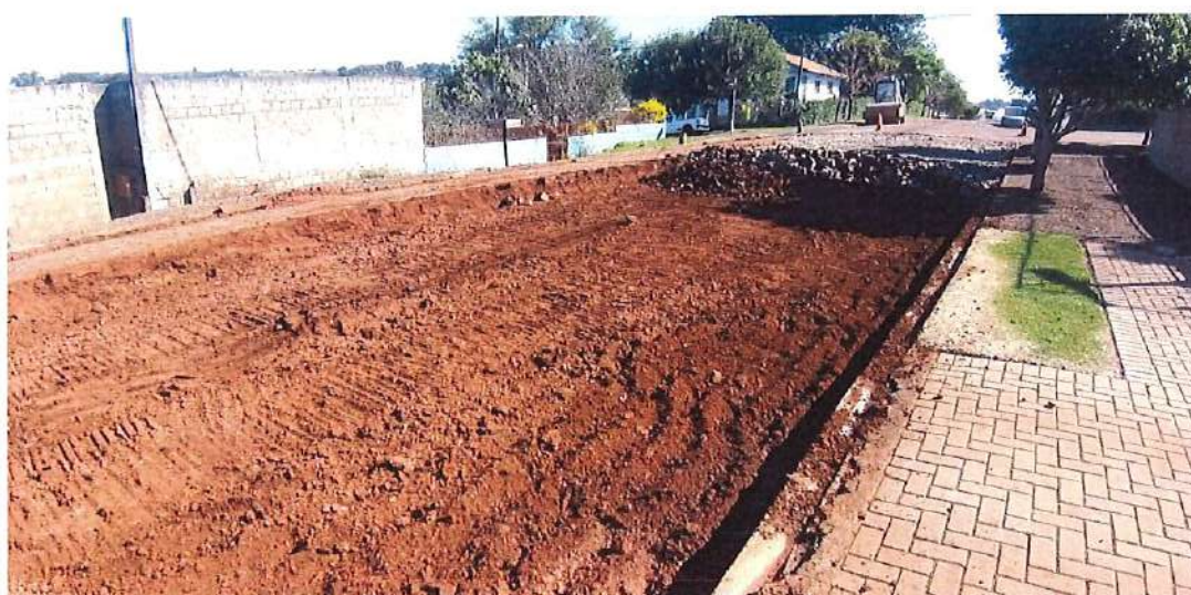
Foto 35: Rua Tuiuti - reforço de base
