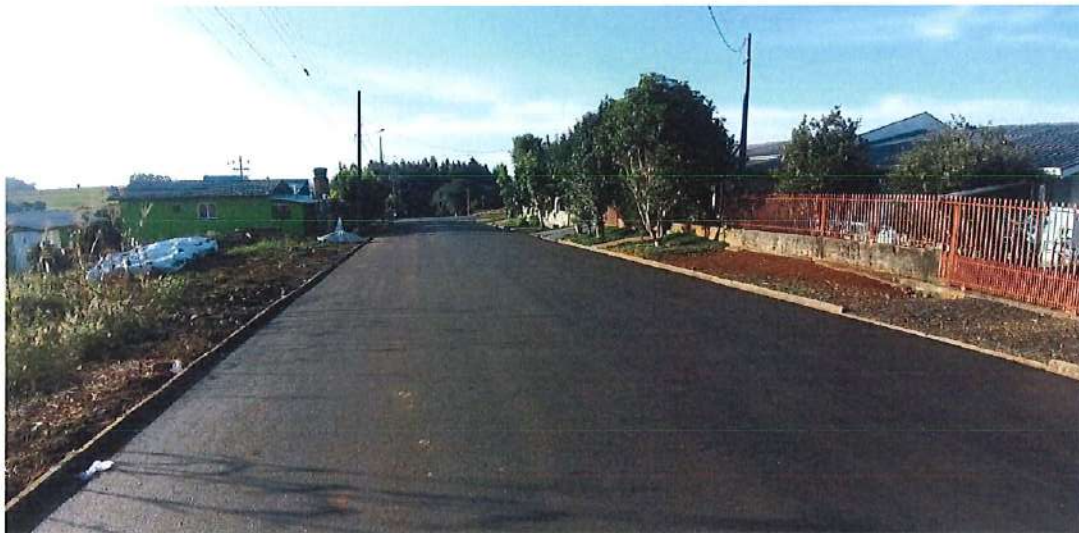
Foto 70: Rua Theóphilo Petrycoski – pavimentação
