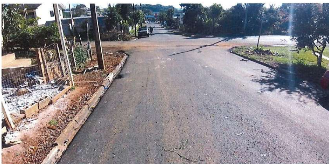
Foto 05: Rua da República - pavimentação
