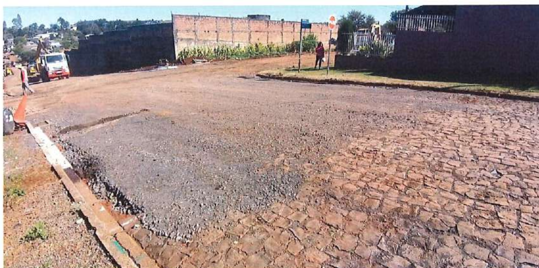
Foto 23: Rua Vieira da Costa – reforço de base
