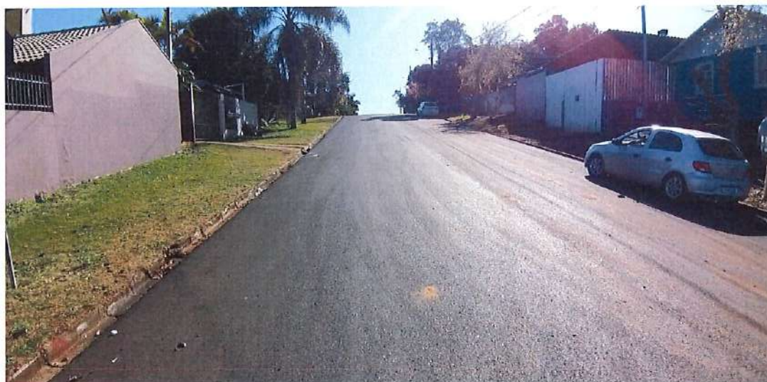
Foto 29: Rua Vieira da Costa – pavimentação
