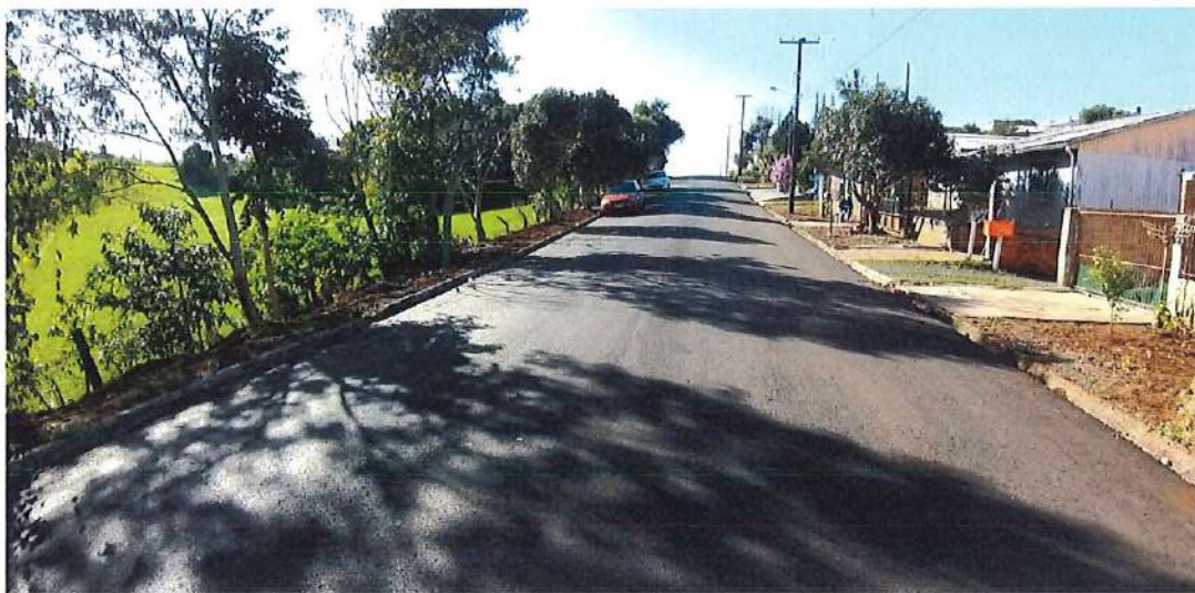
Foto 16: Rua do Príncipe – pavimentação
