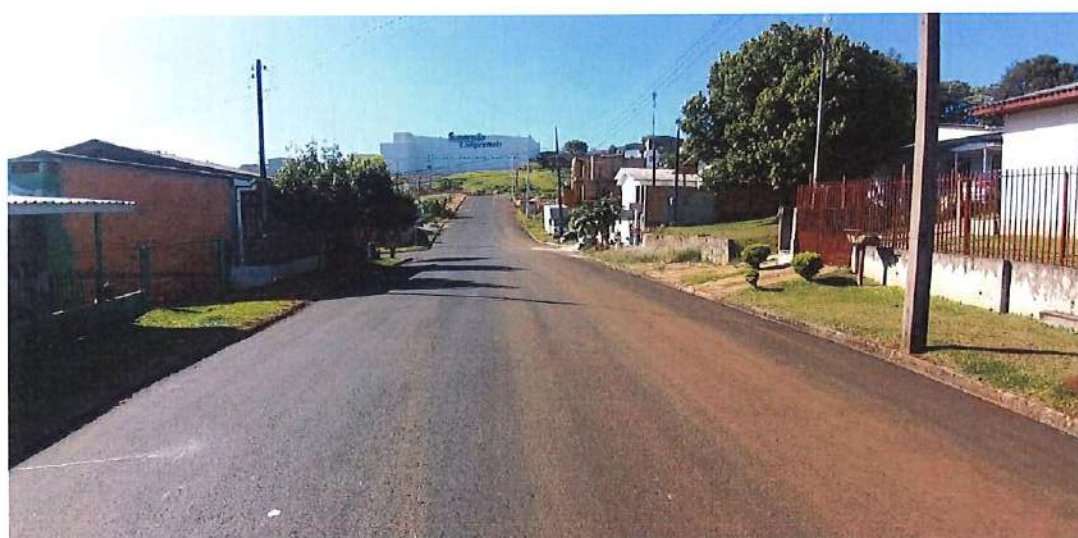
Foto 20: Rua Aldoino Dalmolin - pavimentação
