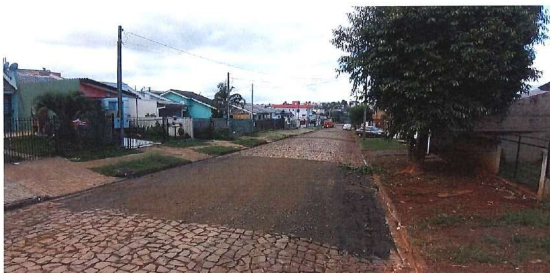
Foto 14: Rua do Príncipe – reforço de base
