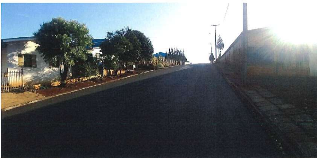
Foto 66: Rua 14 de Dezembro – pavimentação
