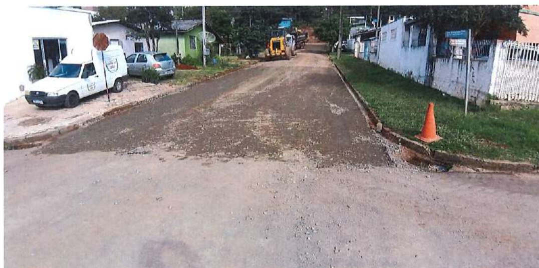
Foto 03: Rua da República - reforço de base
