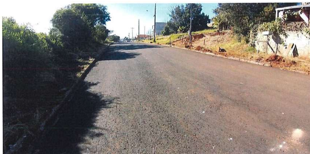
Foto 15: Rua do Príncipe – pavimentação
