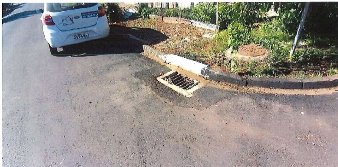
Foto 19: Rua do Príncipe – drenagem
