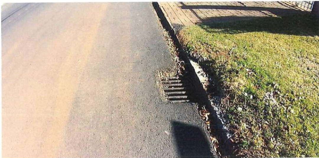
Foto 37: Rua Tuiuti - drenagem
