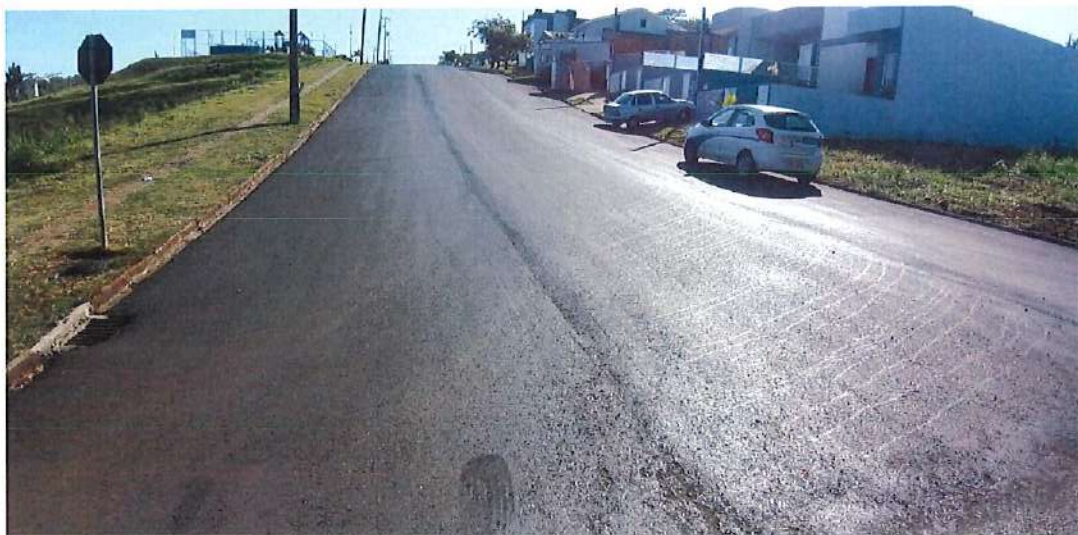
Foto 43: Rua Melci Dal Molin – pavimentação e drenagem
