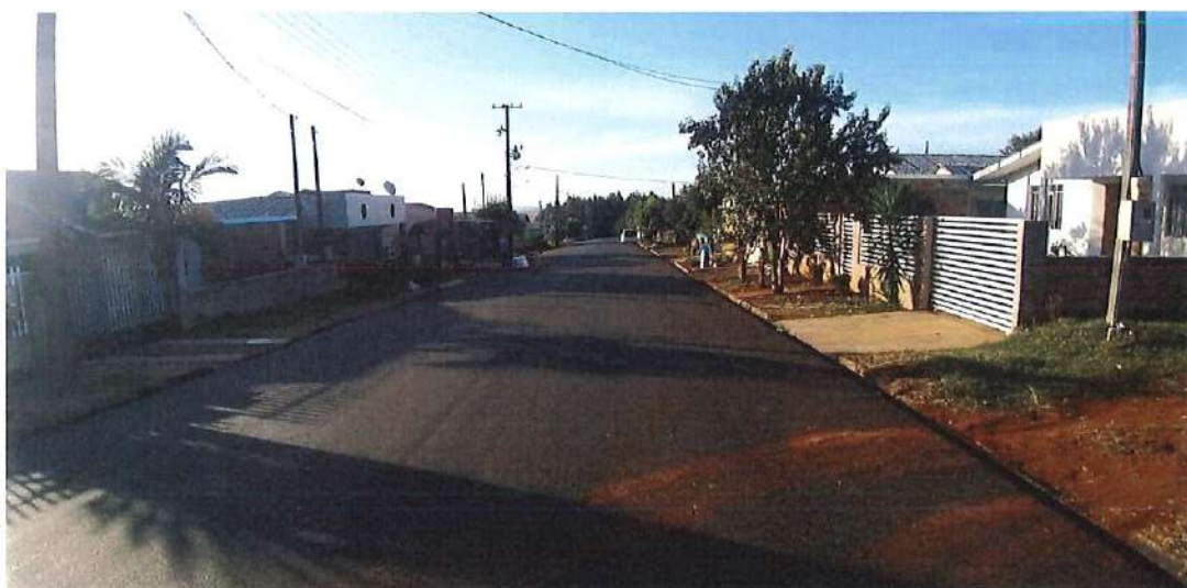
Foto 69: Rua Theóphilo Petrycoski – pavimentação
