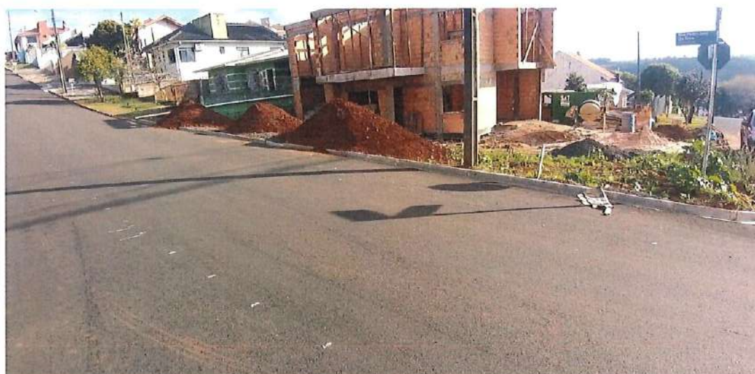
Foto 50: Rua Pedro José da Silva (Trecho 01) – meio fio
