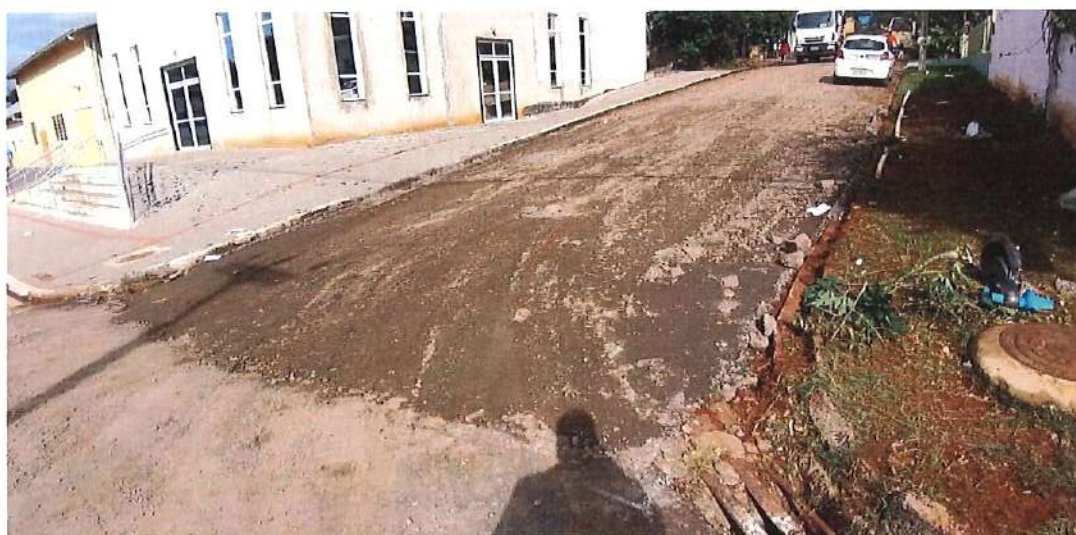
Foto 02: Rua da República - reforço de base
