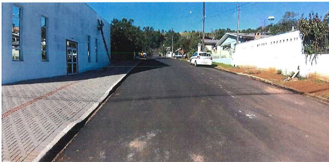
Foto 04: Rua da República - pavimentação
