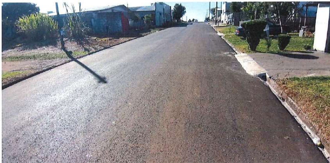
Foto 10: Rua Papa João XXIII – pavimentação
