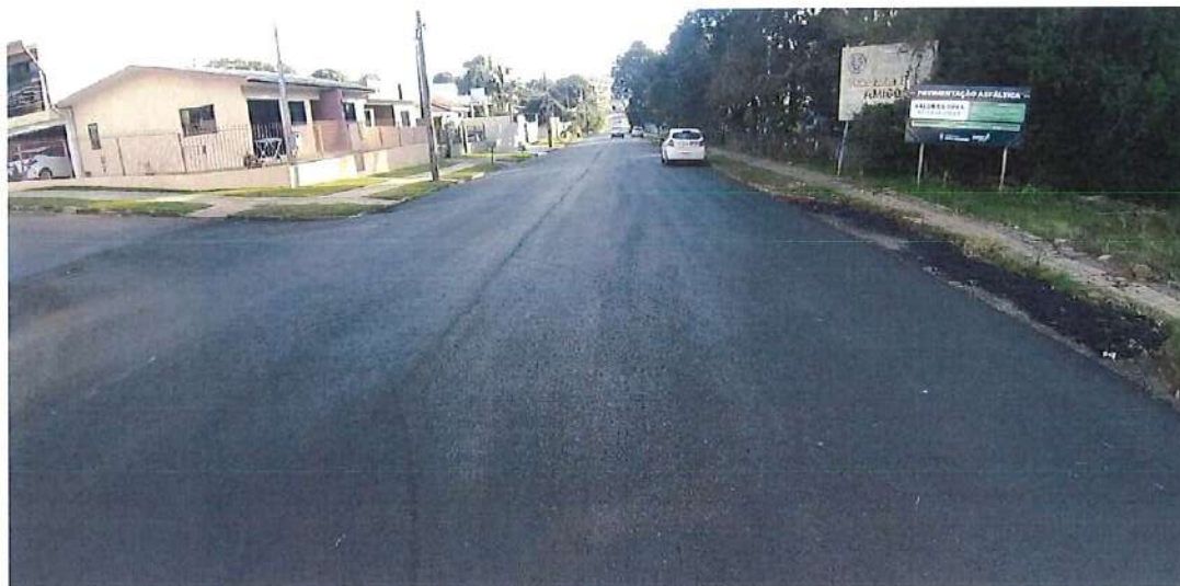
Foto 55: Rua José Fraron – pavimentação
