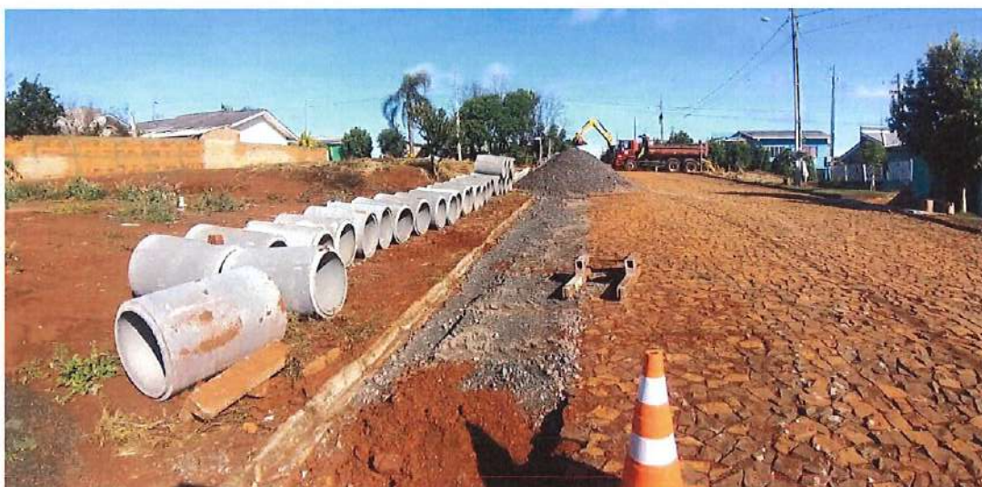
Foto 68: Rua Theóphilo Petrycoski – drenagem e reforço de base
