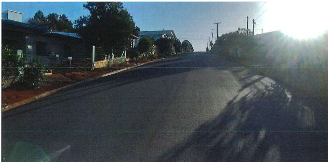
Foto 64: Rua 14 de Dezembro – pavimentação
