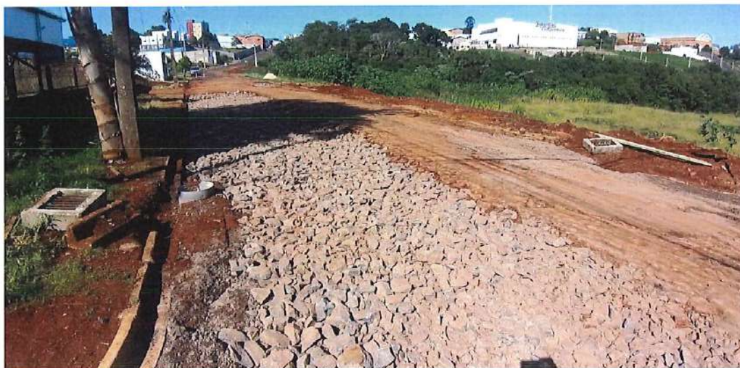
Foto 34: Rua Tuiuti - reforço de base
