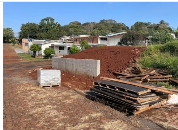
F2- MURO DE CONTEÇÃO
