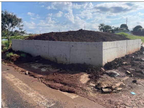
F1-MURO DE CONTEÇÃO
