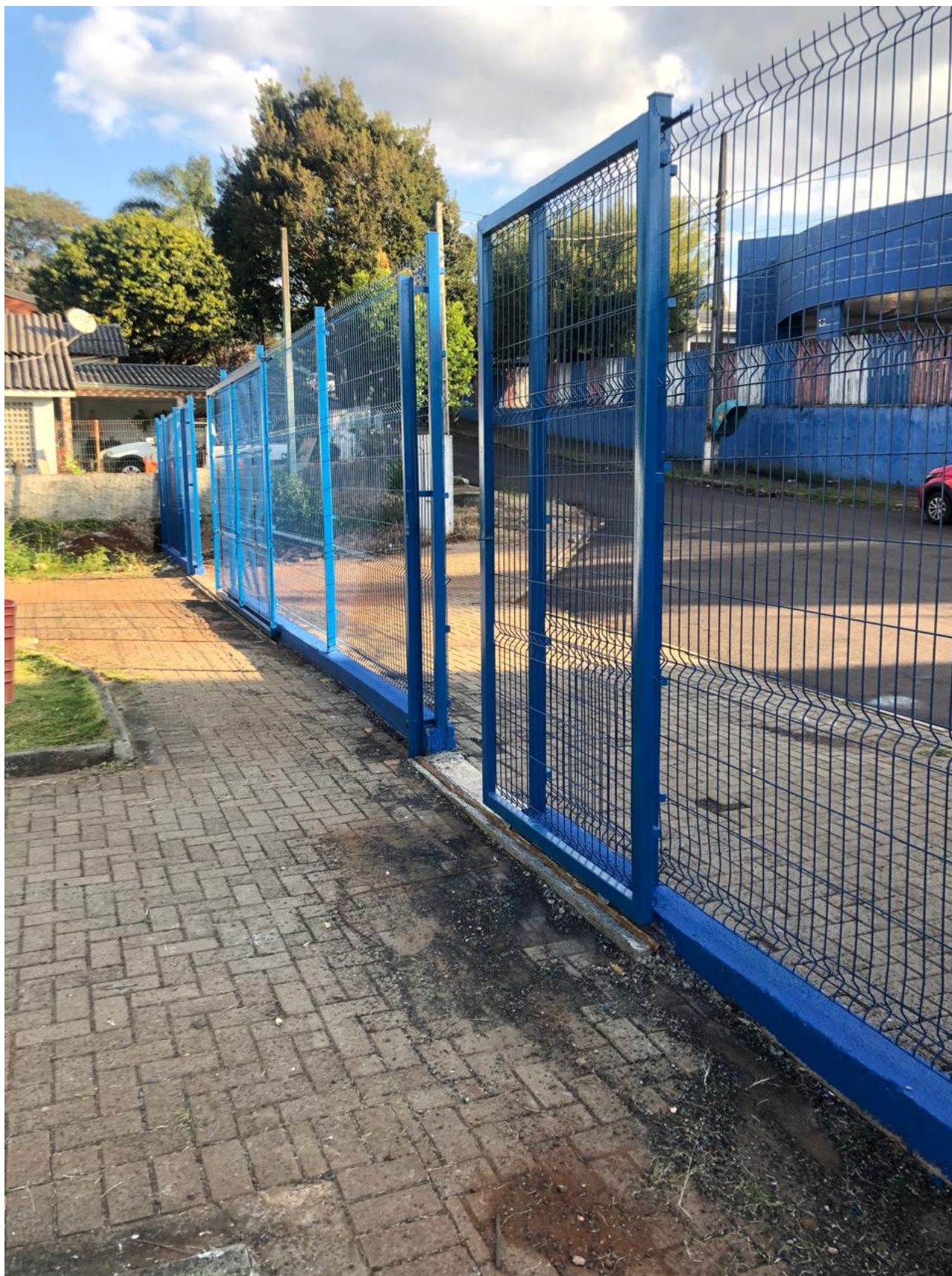
Foto 3: Cercamento – Grades e portões.
