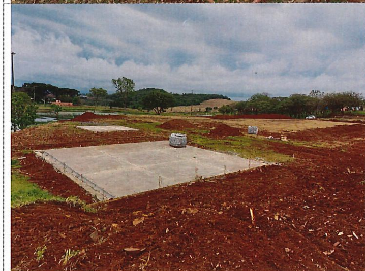
Execução de viga baldrame no entorno do playground
