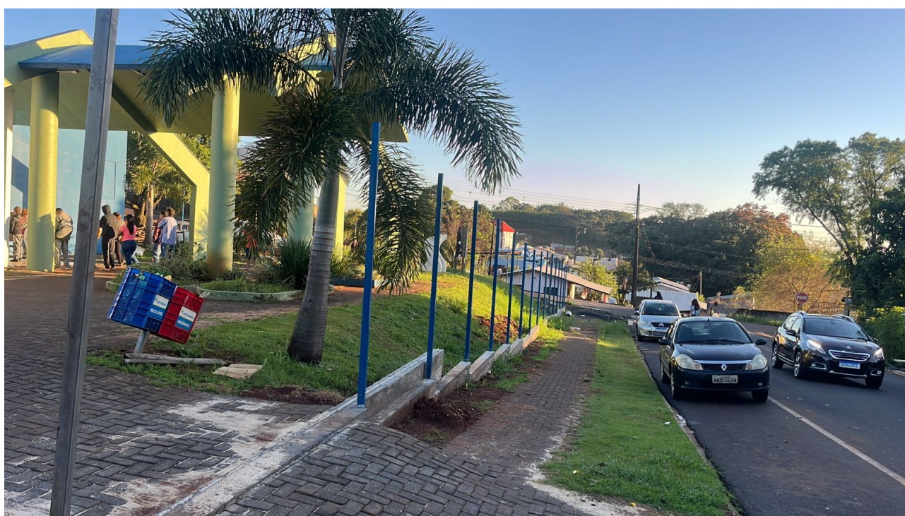
Foto 4: Viga baldrame do cercamento.
