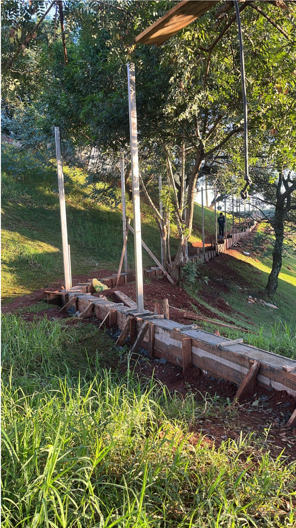
Foto 2: Concretagem de Vigas Baldrames.
