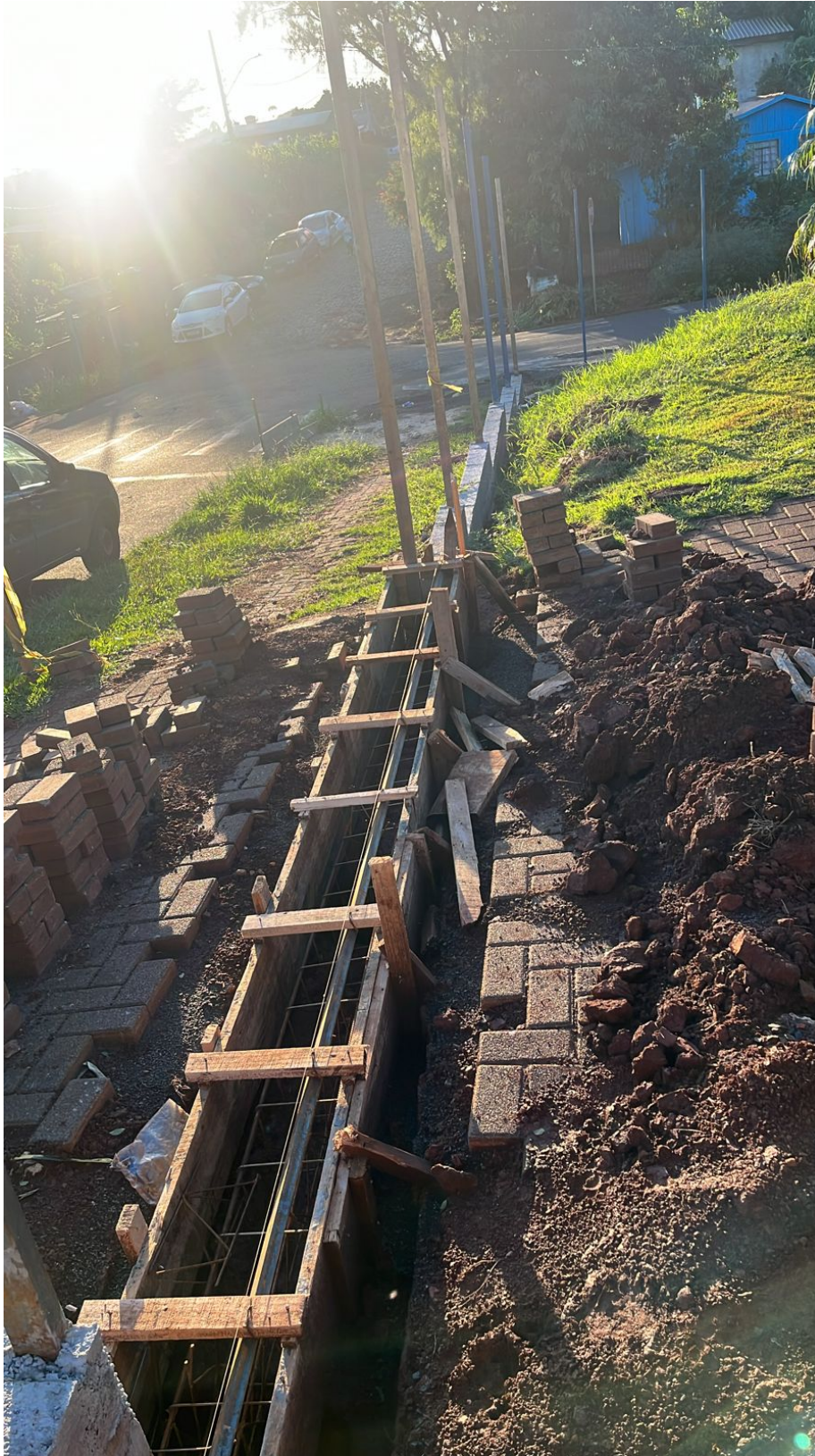
Foto 1: Vigas de cercamento.
