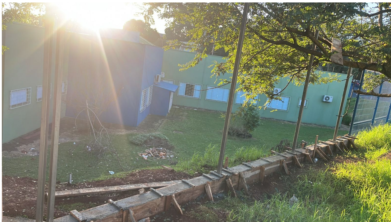
Foto 3: Concretagem de Vigas Baldrames.
