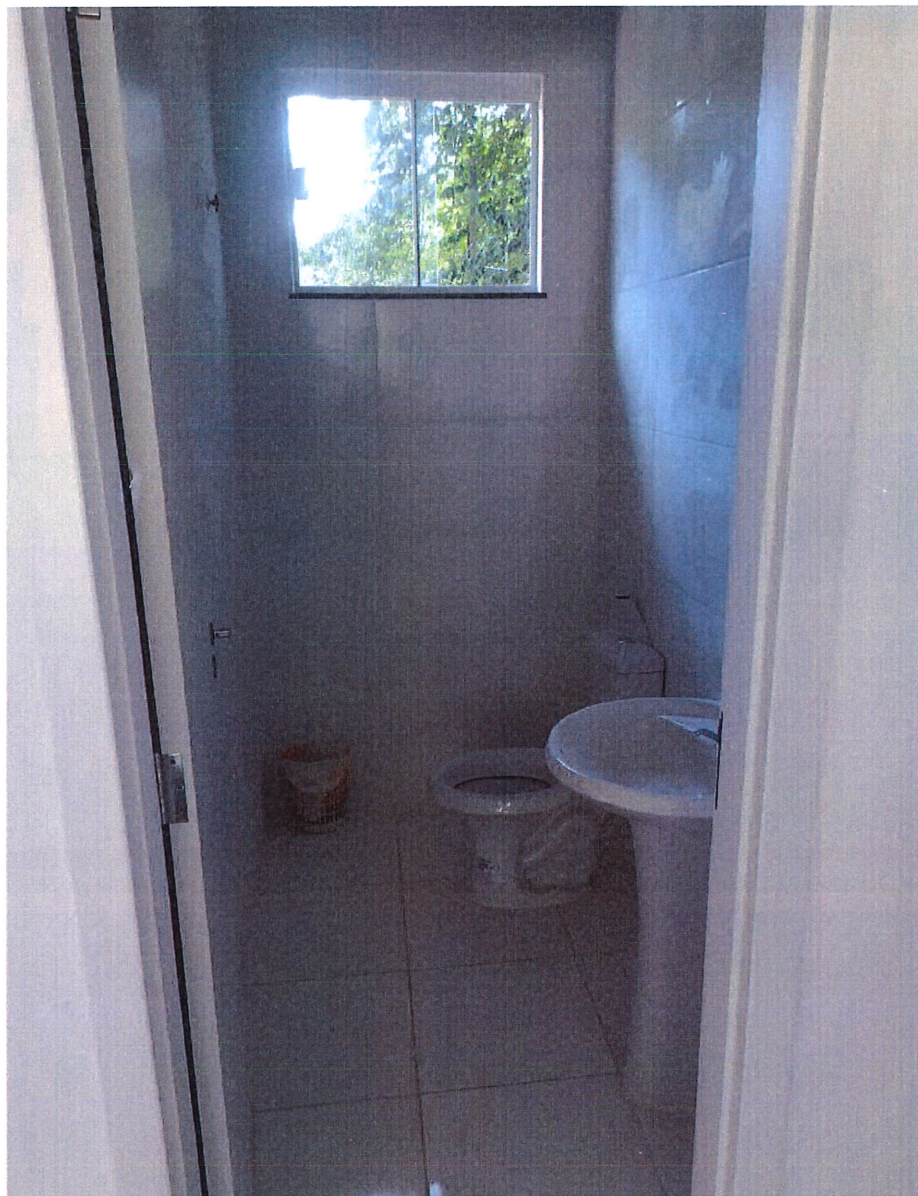
Foto 1: Bacia e vaso sanitário com caixa acoplada.
