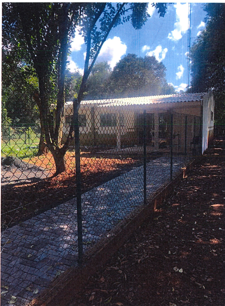
Foto 4: Cercamento com perfis de aço galvanizado.
