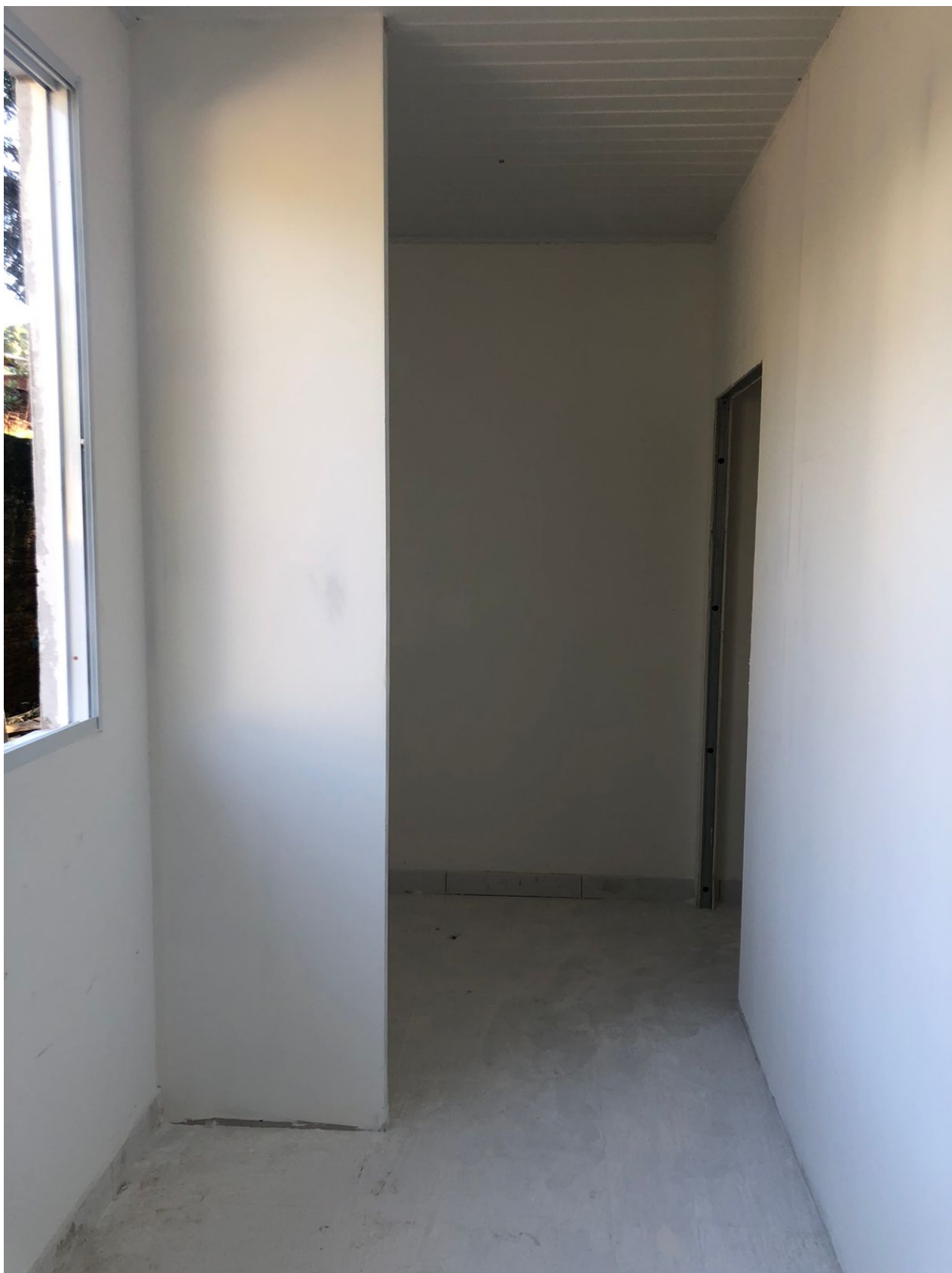
Foto 1: Pintura interna de paredes.
