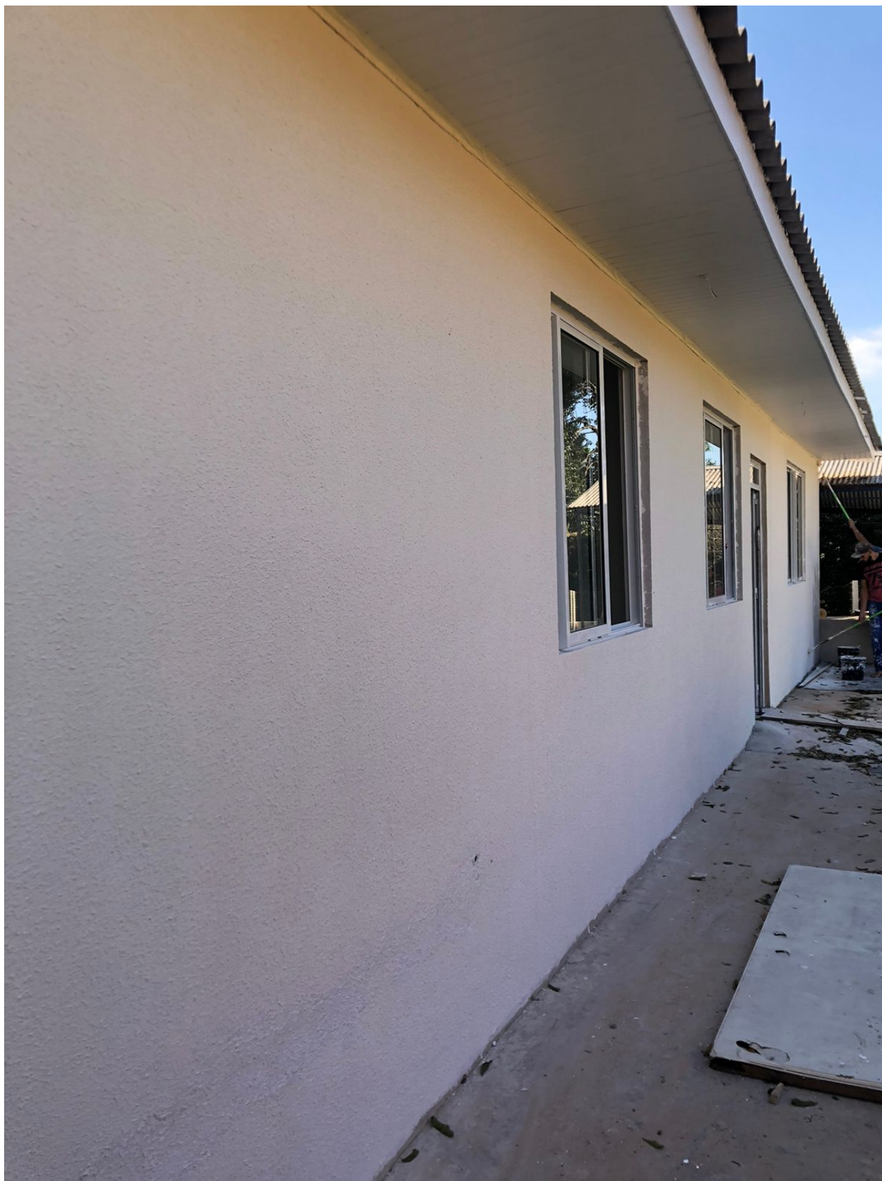
Foto 4: Pintura externa/ beiral/ esquadrias.
