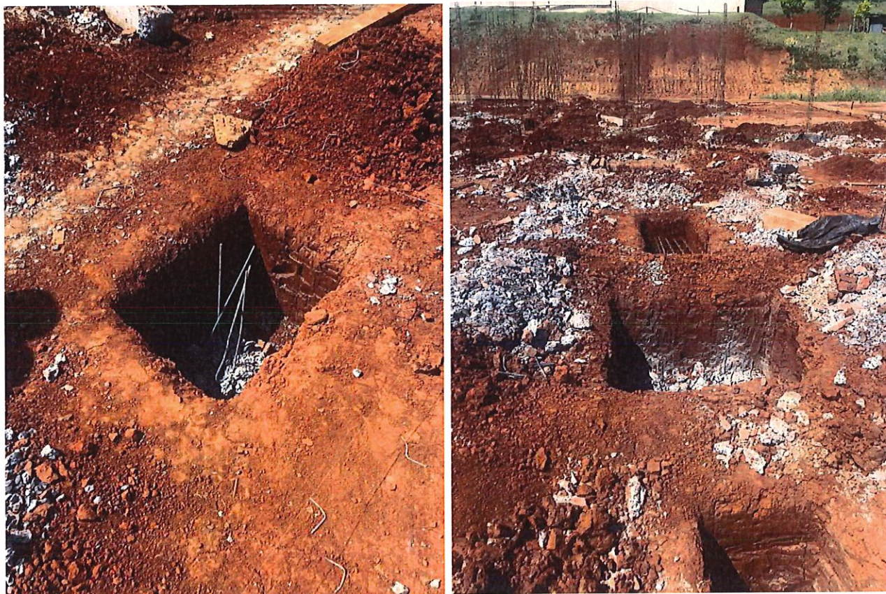
Foto 5: Abertura dos blocos de fundação e arrasamento de estacas.
