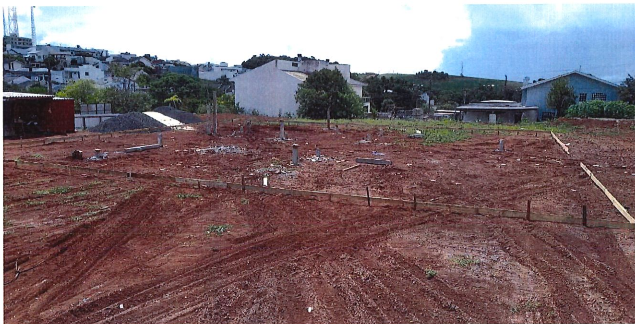
Foto 3: Locação da obra e Estaqueamento.
