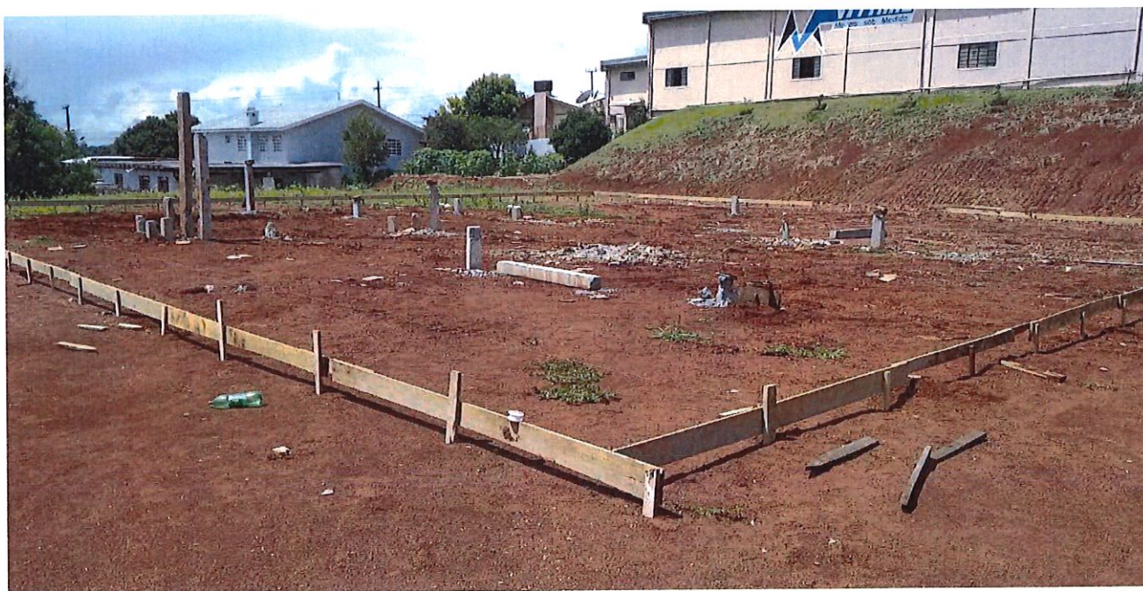
Foto 2: Locação da obra e Estaqueamento.
