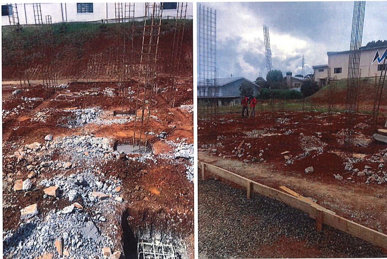
Foto 6: Concretagem dos blocos e armaduras dos pilares.
