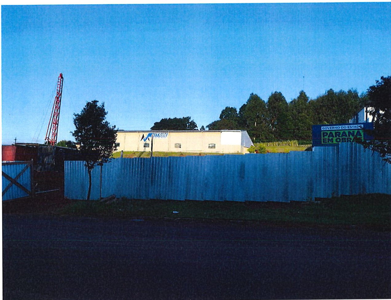
Foto 1: Placa da Obra e Tapume.
