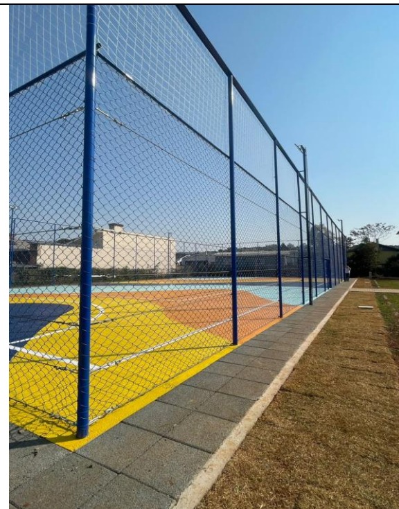
11. Quadra poliesportiva, cercamento e grama.
