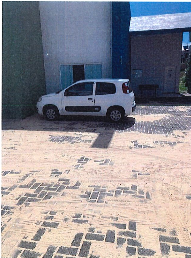
Foto 8: Nivelamento do estacionamento existente
