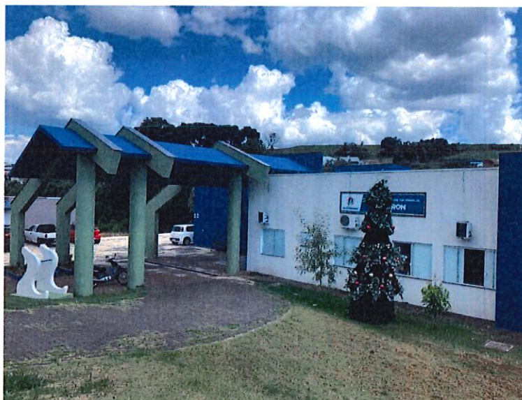
Foto 1: Pintura externa da unidade
