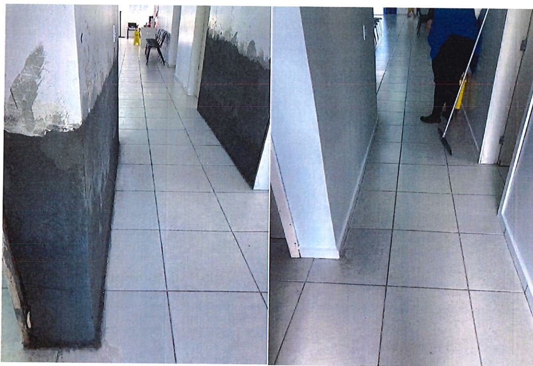
Foto 5: Conserto do revestimento das paredes danificada pela infiltração
