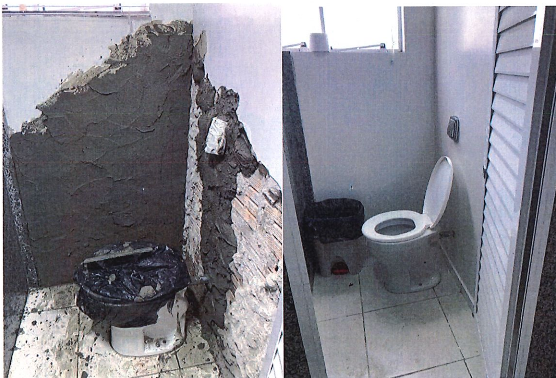
Foto 4: Conserto do encanamento vaso sanitário do banheiro
