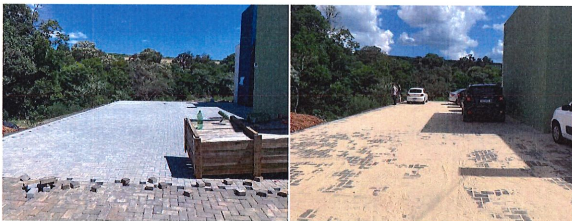
Foto 2: Ampliação do estacionamento na lateral da unidade
