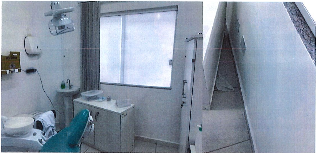
Foto 7: Conserto do revestimento das paredes danificada pela infiltração no consultório odontológico
