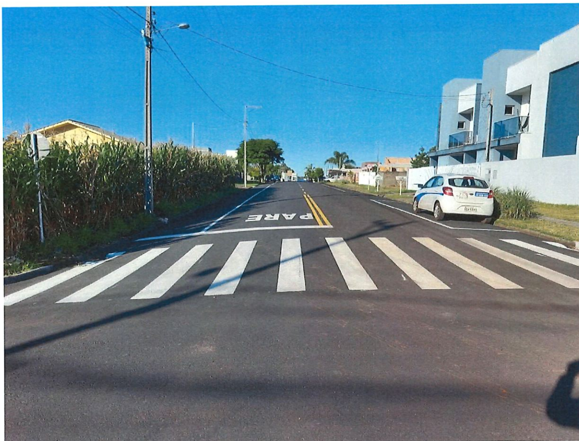
Foto 19: Rua Angela Parzianello.
