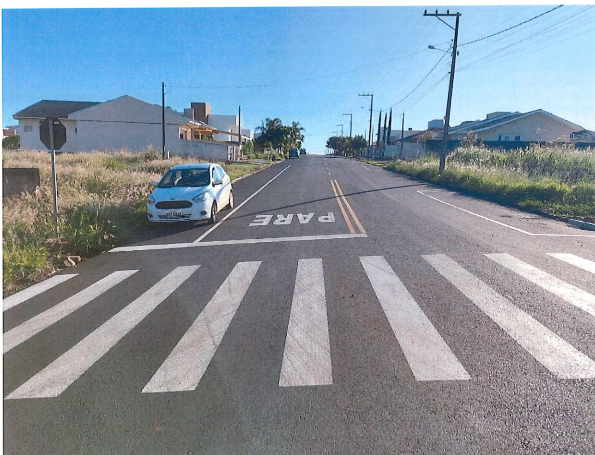
Foto 20: Rua Angela Parzianello.
