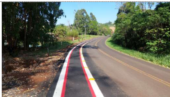
Fotografia 08. Ciclovia pavimentada com sinalização horizontal.
