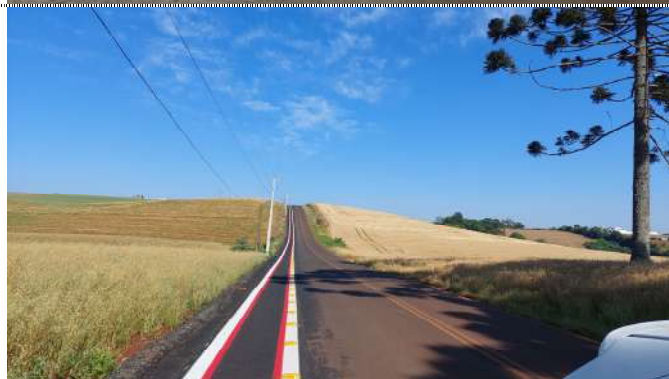
Fotografia 02. Ciclovia pavimentada com sinalização horizontal.
