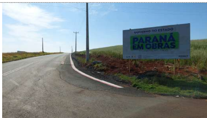
Fotografia 01. Placa de Obra.
