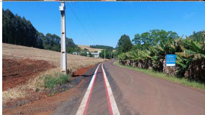
Fotografia 11. Ciclovia pavimentada com sinalização horizontal.
