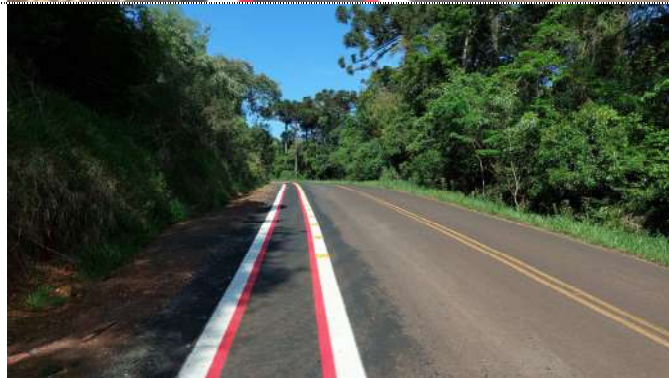
Fotografia 09. Ciclovia pavimentada com sinalização horizontal.
