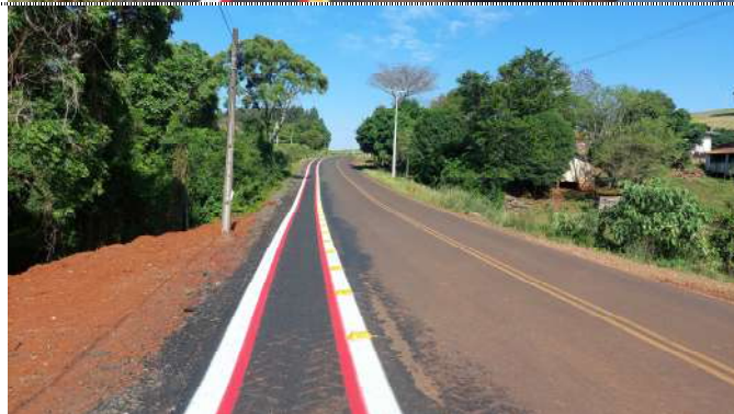
Fotografia 03. Ciclovia pavimentada com sinalização horizontal.
