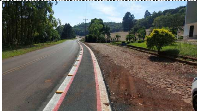
Fotografia 10. Ciclovia pavimentada com sinalização horizontal.
