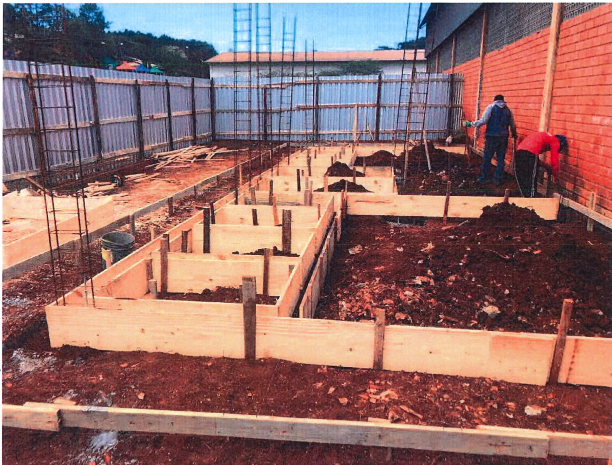
Foto 3: Locação e Estrutura de concreto (Fundação e Vigas Baldrame)
