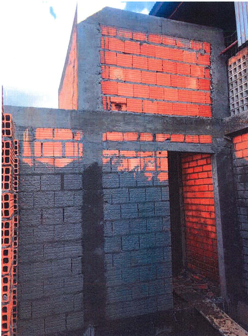
Foto 4: Estrutura de concreto (Pilares e vigas de cobertura).
