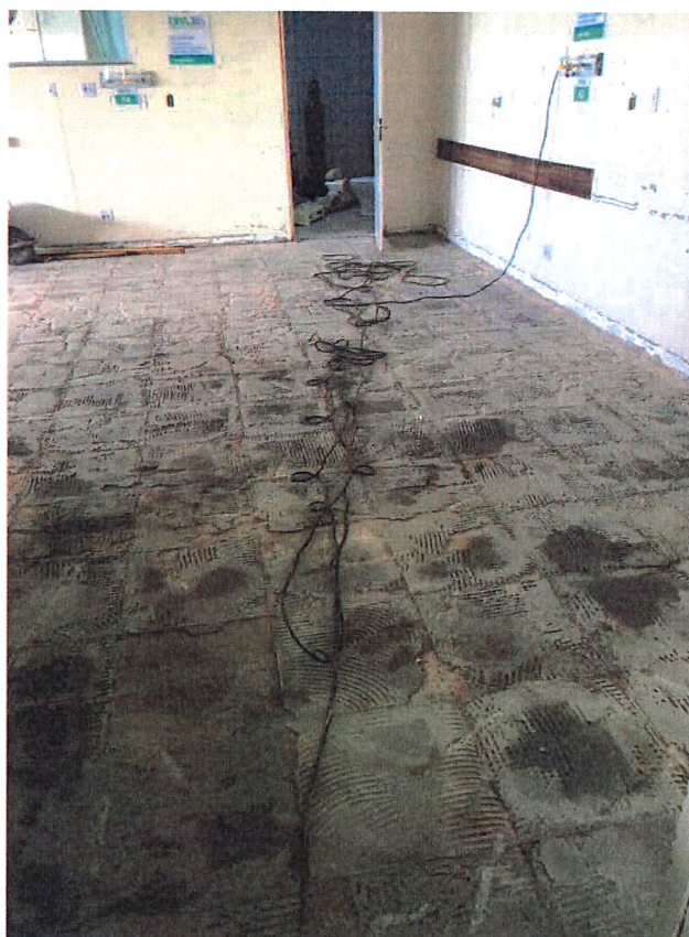
Foto 2: Remoção de Revestimento Cerâmico
