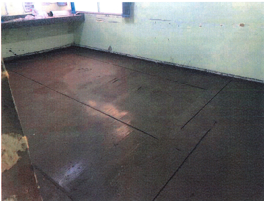
Foto 3: Regularização de Contrapiso com argamassa
