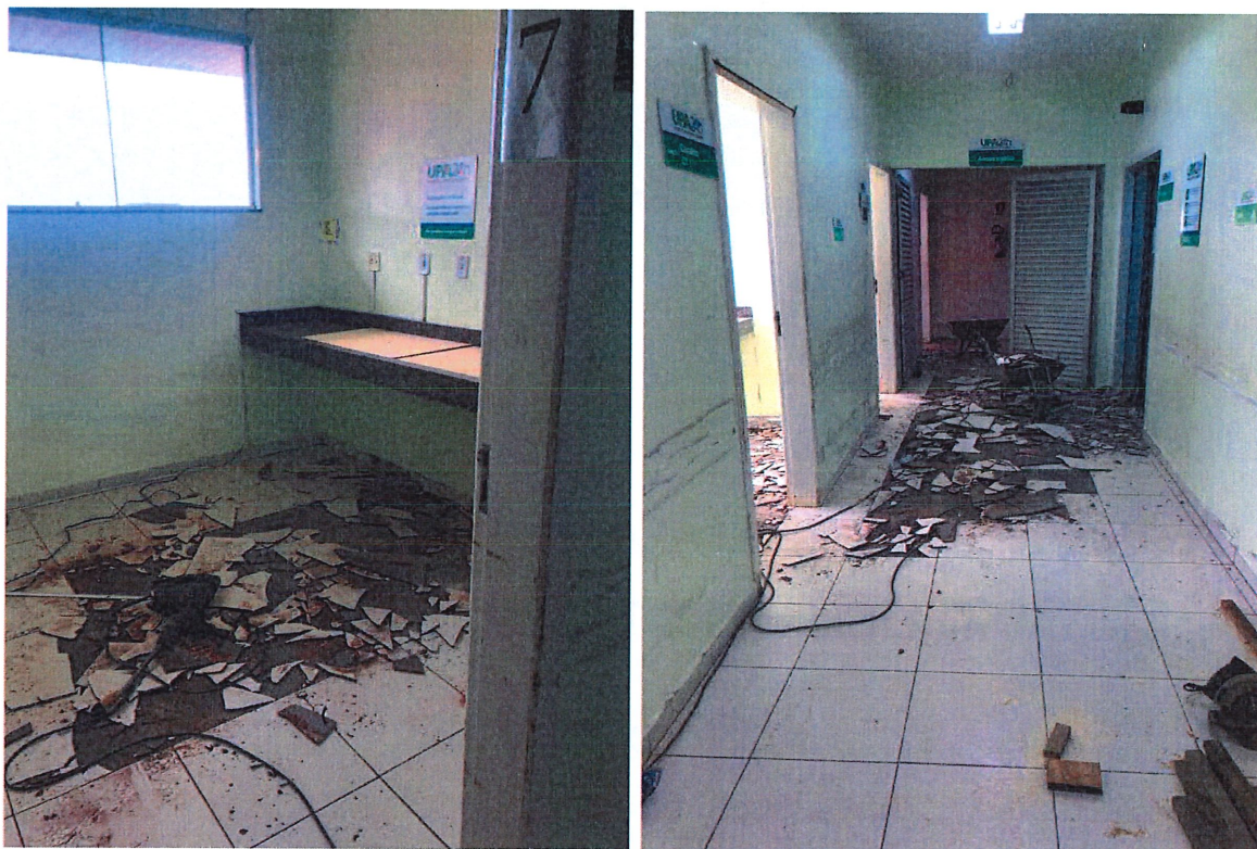
Foto 1: Demolição de Revestimento Cerâmico
