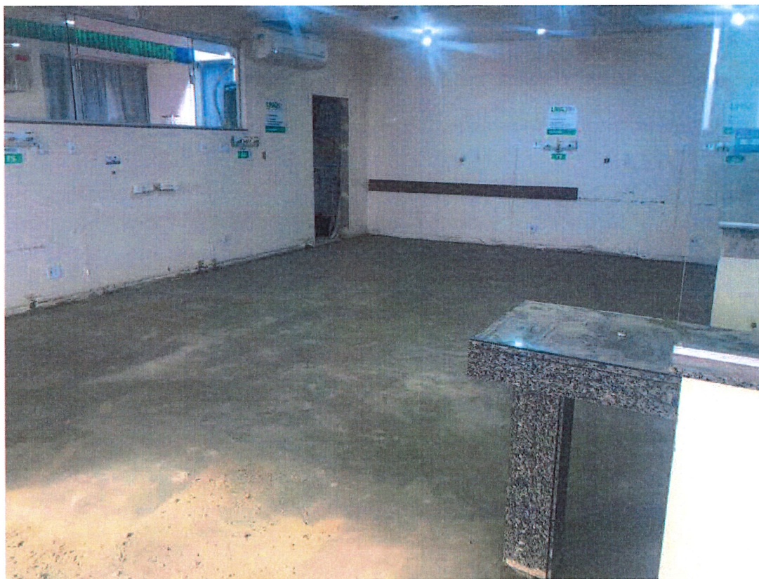
Foto 4: Regularização de Contrapiso com argamassa
