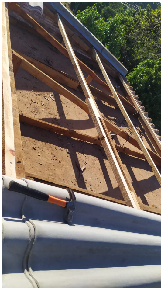
Foto 2: Remoção de cobertura e troca do telhamento.
