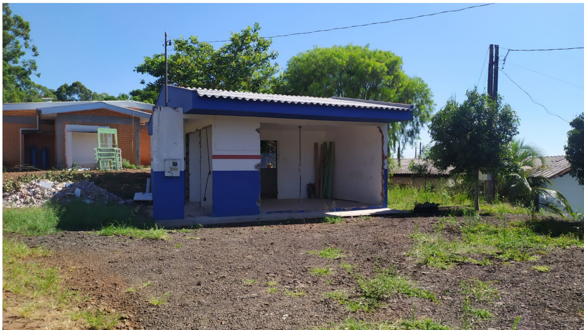
Foto 1: Remoção de Aberturas e Paredes.
