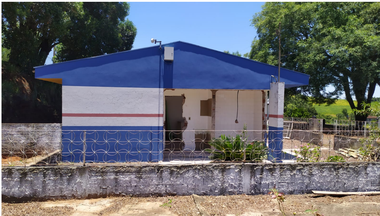
Foto 1: Remoção de Aberturas e Paredes.
