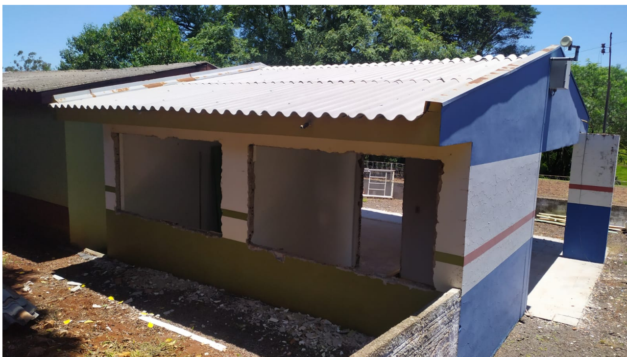
Foto 2: Remoção de Aberturas e Paredes. Trocas do telhamento.
