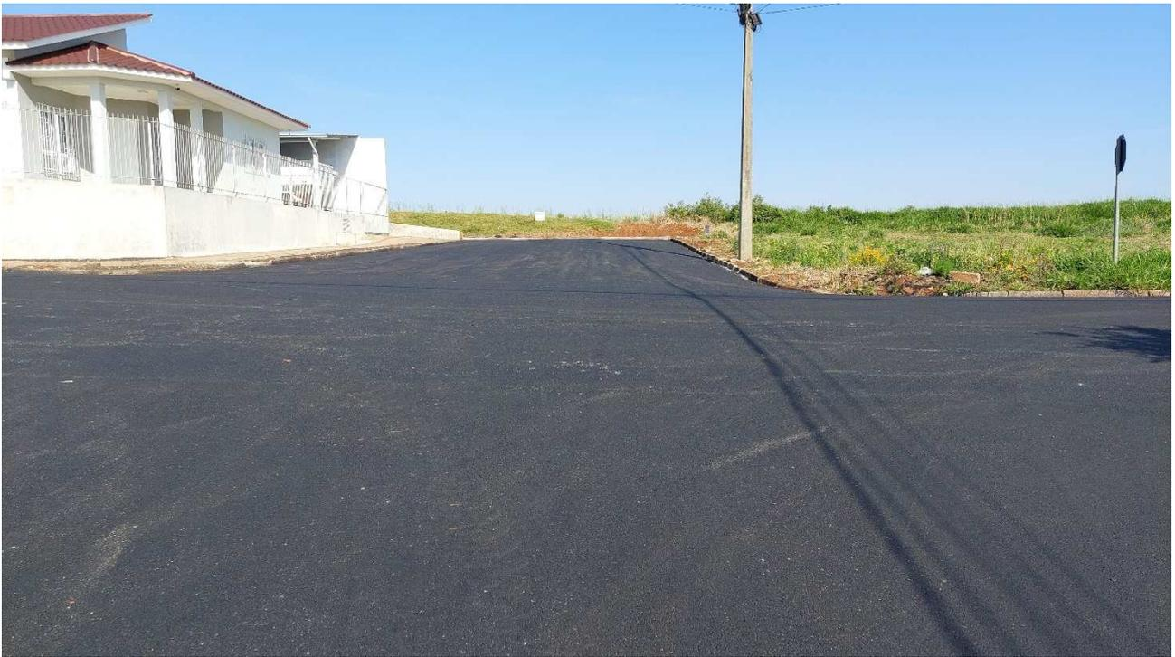
**Fotografia 15: Rua Áurea Zandoná Trecho 1 – Execução da Pavimentação com CBUQ.**
