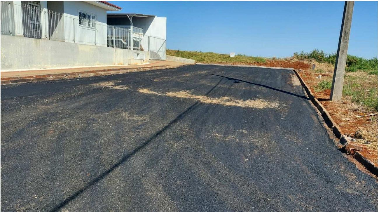
**Fotografia 09: Rua Áurea Zandoná Trecho 1 – Execução de Reperfilagem com CBUQ.**
