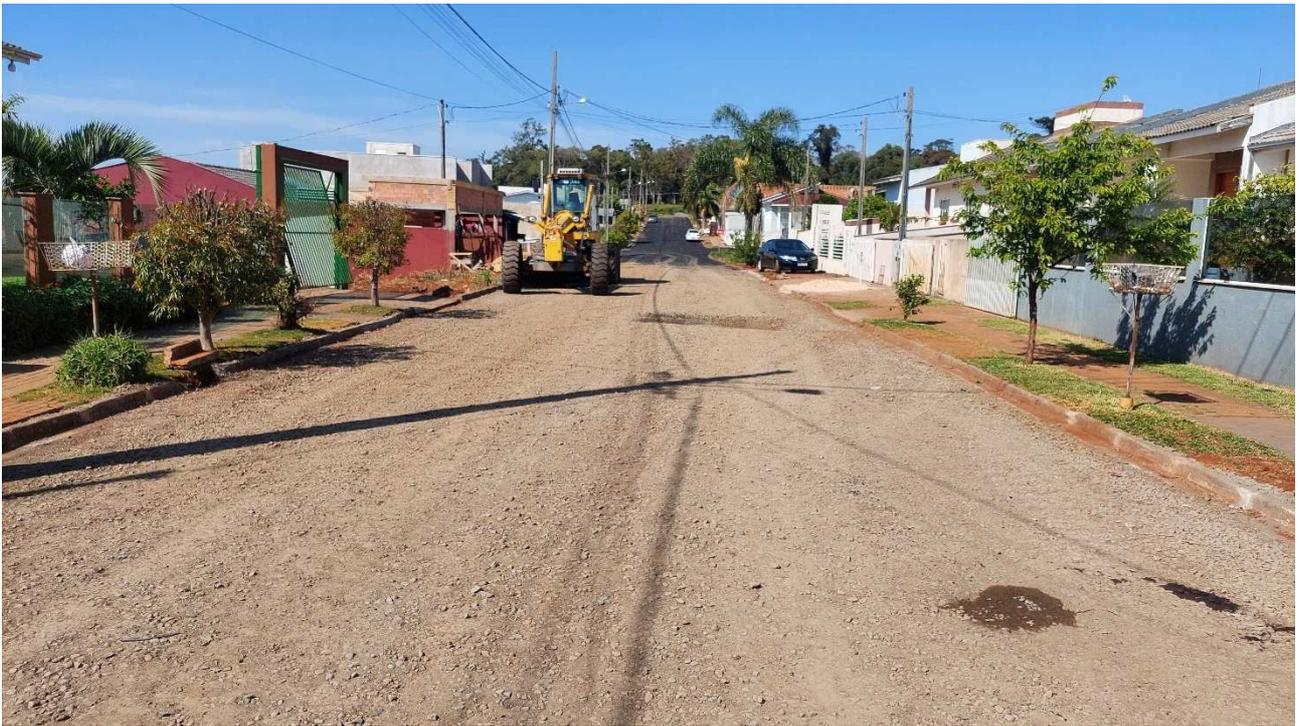
**Fotografia 03: Rua Abraão Ribeiro - Execução de Base com BGS e Imprimação.**
