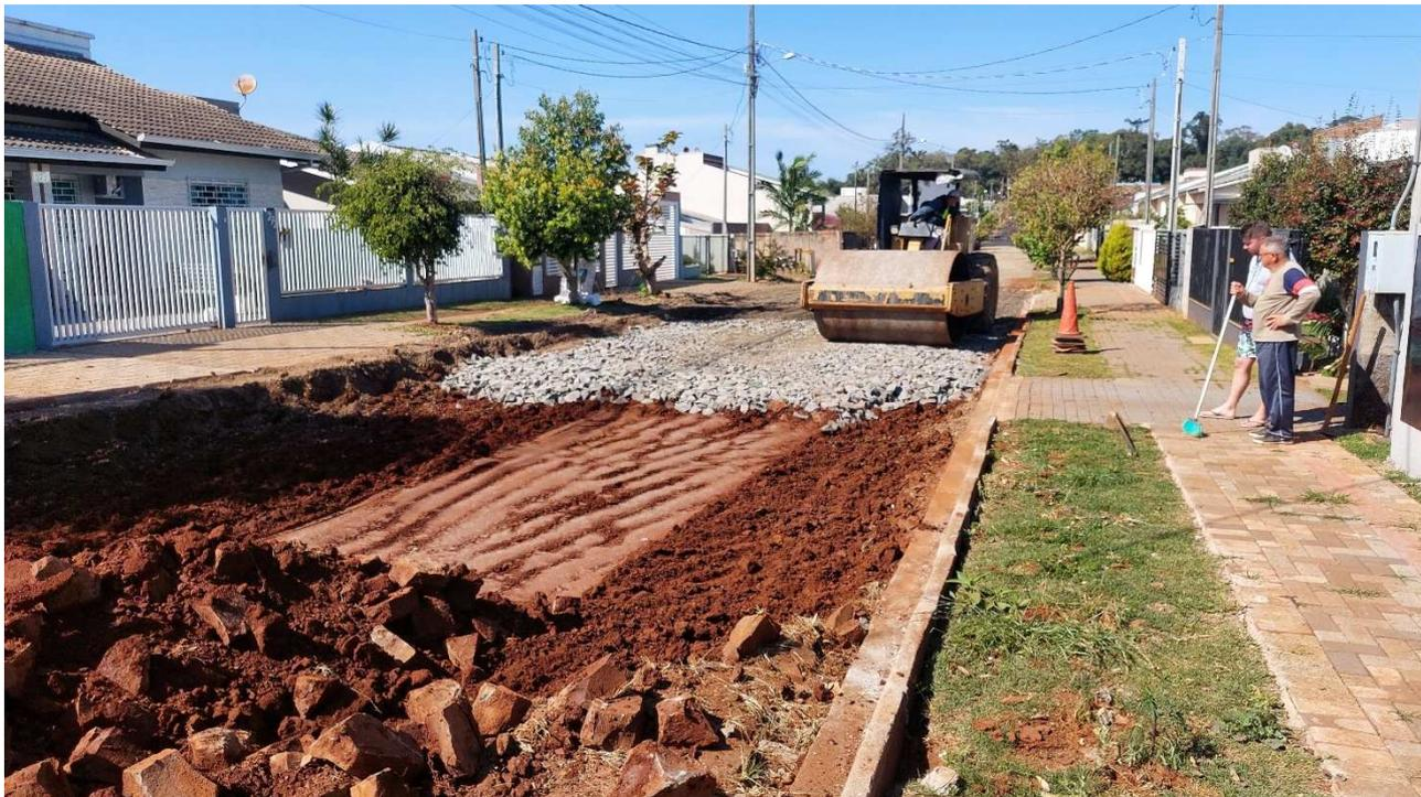
**Fotografia 01: Rua Abraão Ribeiro – Escavação, Regularização e Compactação e Execução de Sub-base com macadame.**
