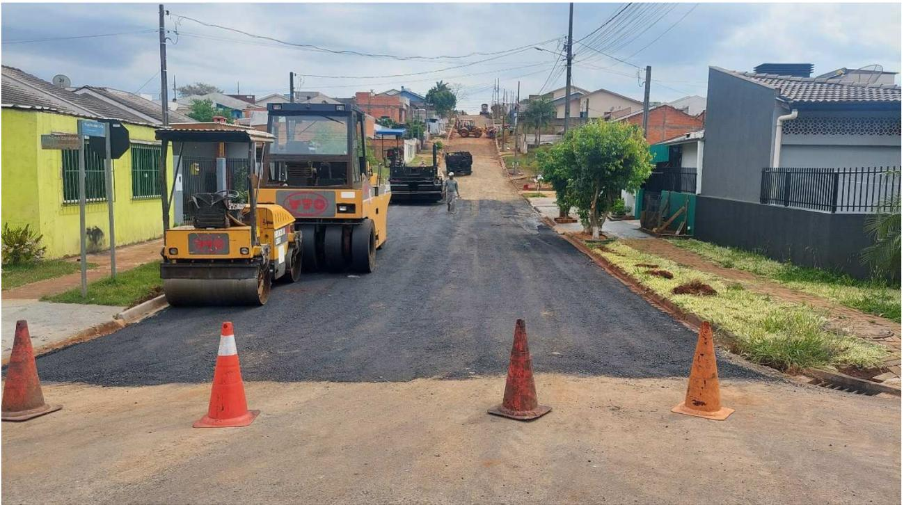
**Fotografia 30: Fotografia 28: Rua Nelson Colla – Execução da Reperfilagem em CBUQ.**
