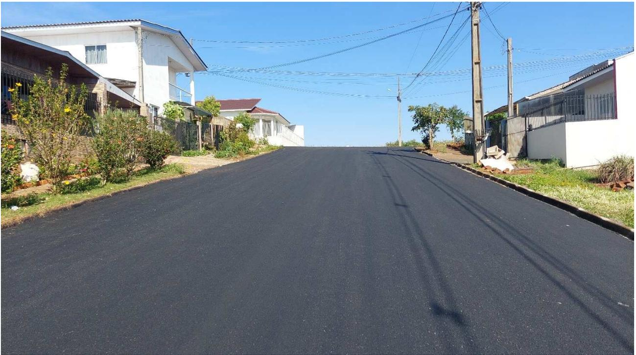
**Fotografia 13: Rua Áurea Zandoná Trecho 1 – Execução da Pavimentação com CBUQ.**
