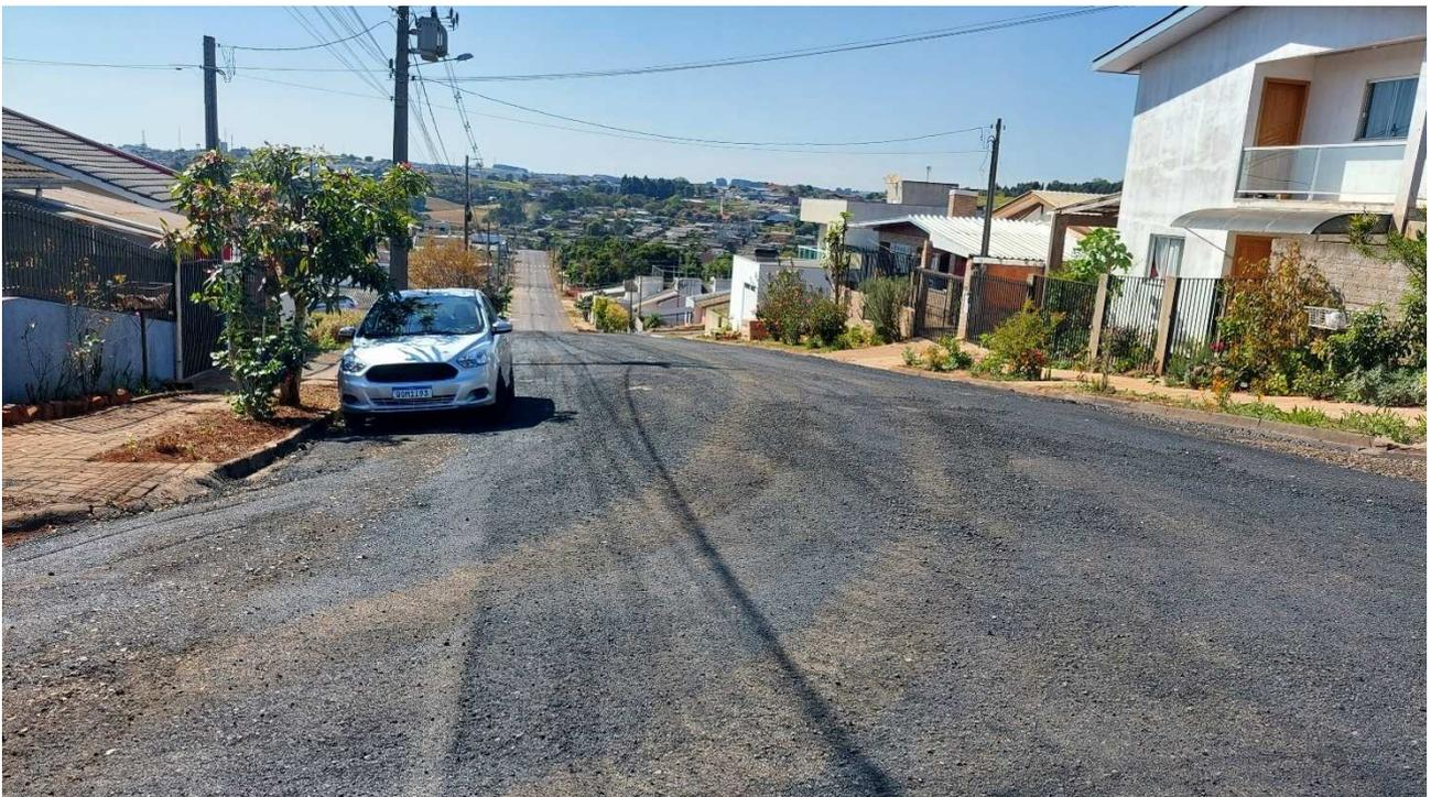
**Fotografia 10: Rua Áurea Zandoná Trecho 1 – Execução de Reperfilagem com CBUQ.**
