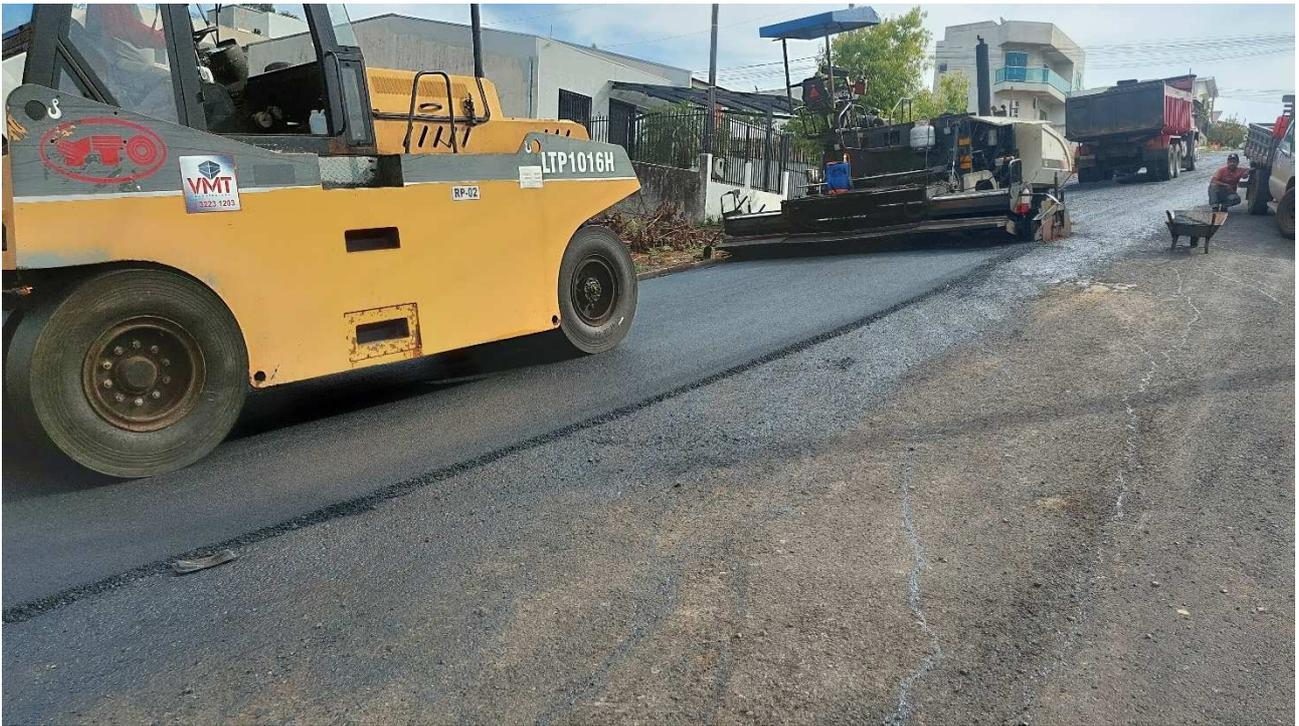
**Fotografia 11: Rua Áurea Zandoná Trecho 1 – Execução da Pavimentação com CBUQ.**
