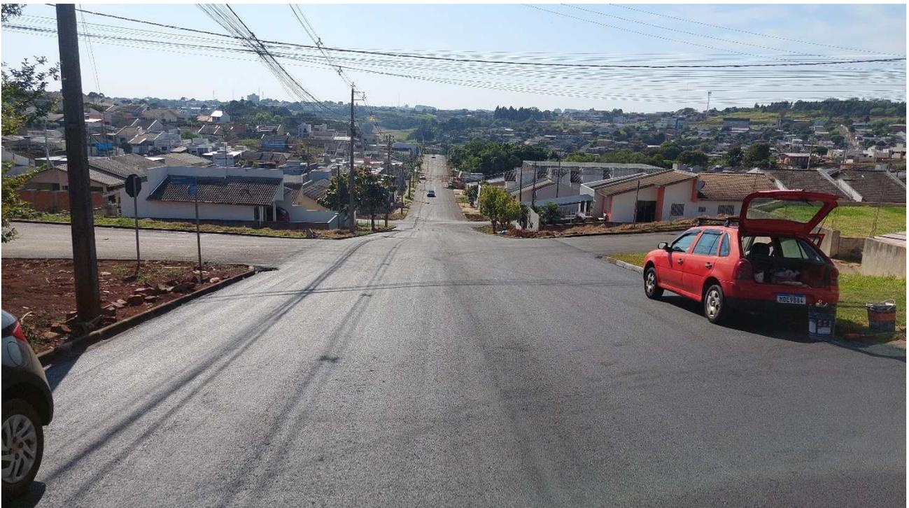
**Fotografia 14: Rua Áurea Zandoná Trecho 1 – Execução da Pavimentação com CBUQ.**
