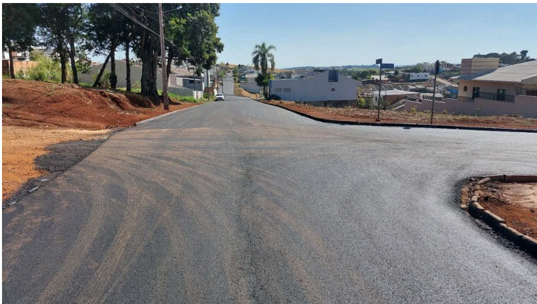
Fotografia 17: Pavimentação Rua Beija Flor.
