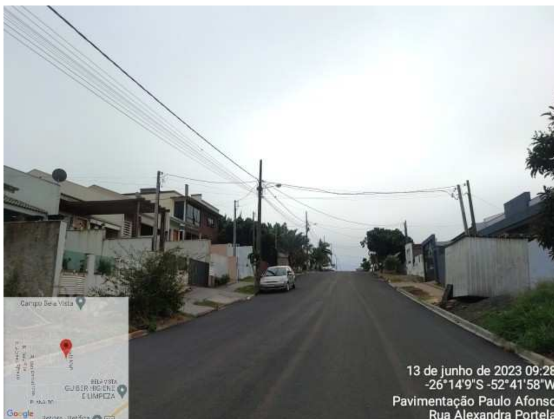
Fotografia 02: Rua Alexandre Portela
