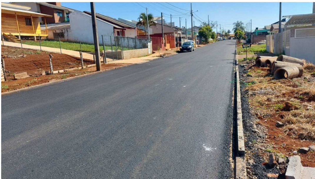
Fotografia 18: Pavimentação Rua Beija Flor.
