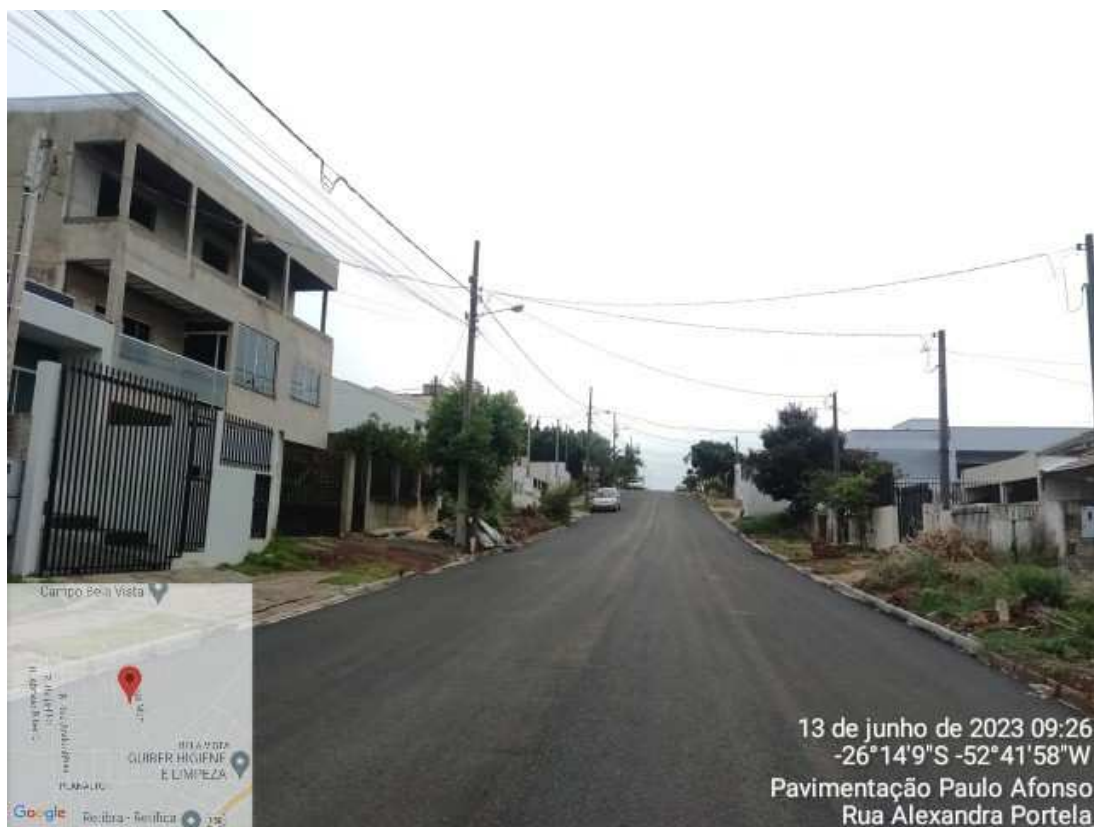
Fotografia 03: Rua Alexandre Portela
