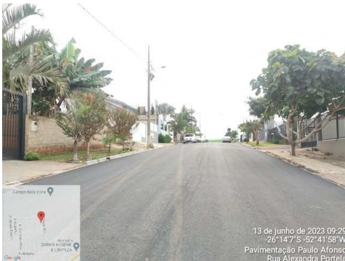
Fotografia 01: Rua Alexandre Portela
