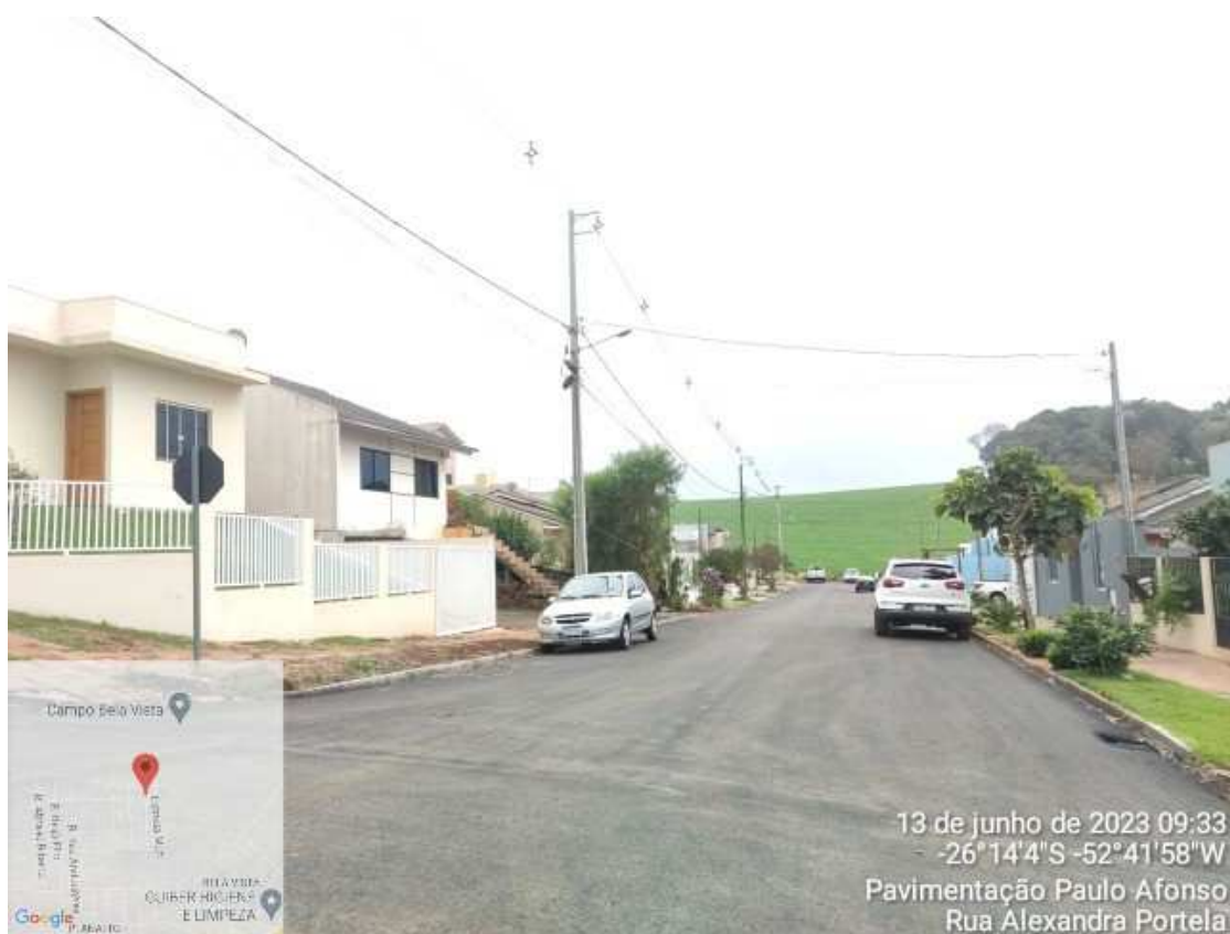
Fotografia 04: Rua Alexandre Portela
