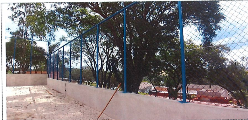
Alambrado parcial quadra de vôlei
