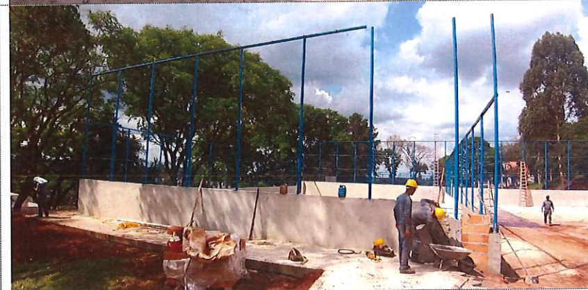
Alambrado parcial quadra de vôlei
