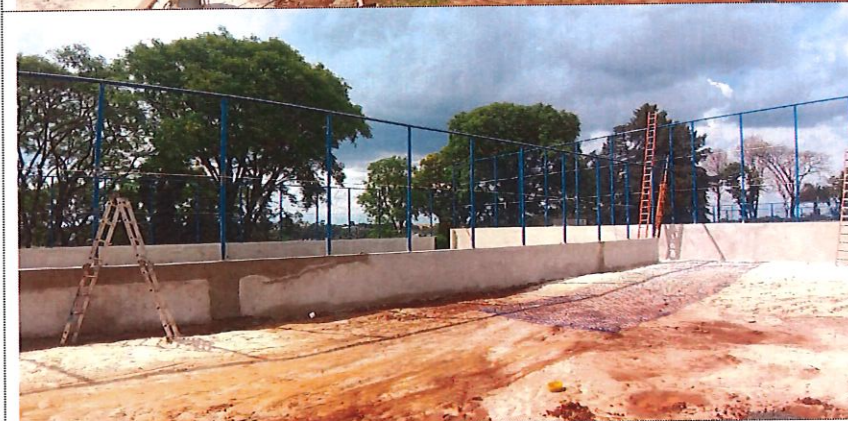
Escavação e reaterro para estrutura
