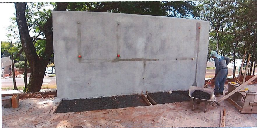
Alvenaria da parede hidráulica
