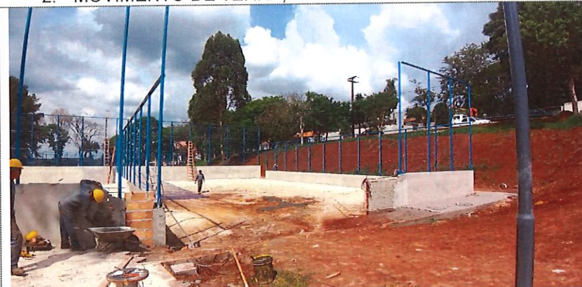
Escavação e reaterro para estrutura
