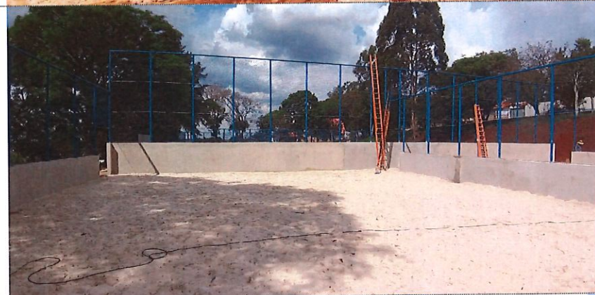
Alambrado parcial quadra de vôlei
