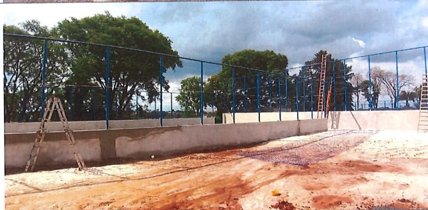
Alvenaria parede central quadra de vôlei e alambrado parcial
