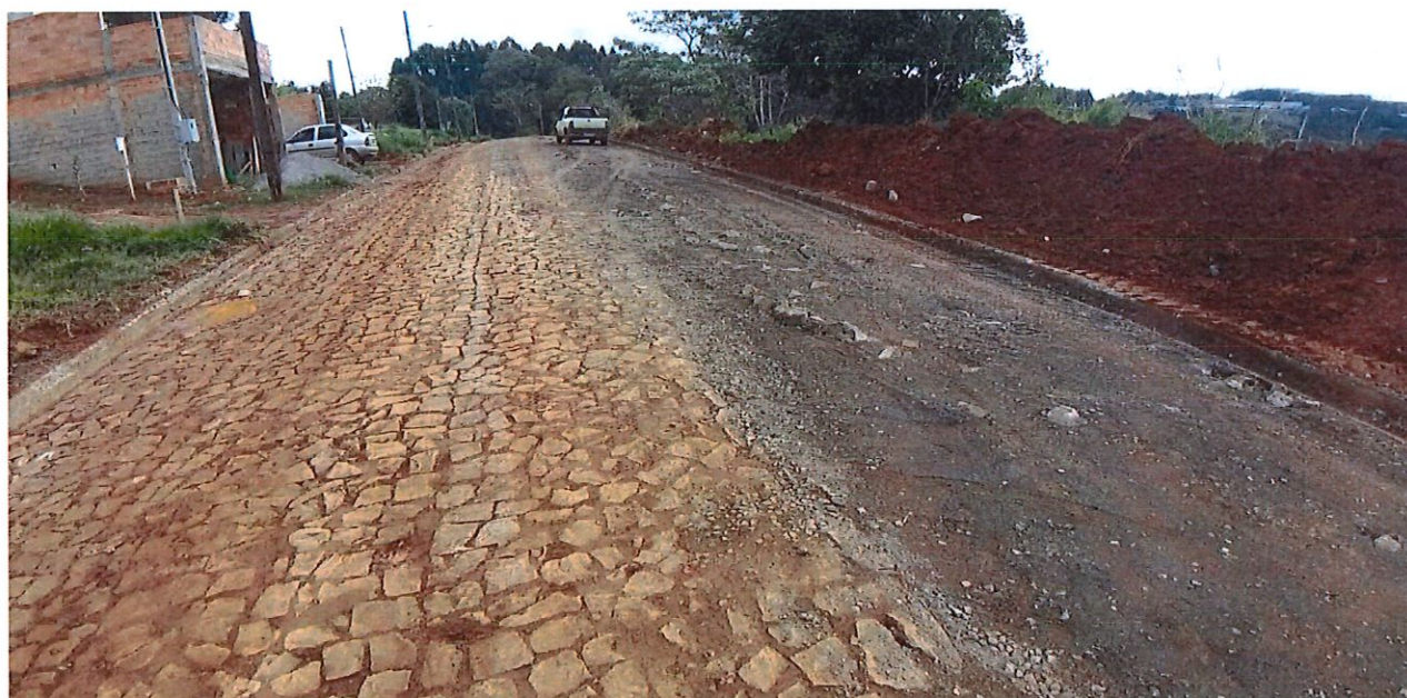
Foto 02: reforço de base Rua do Príncipe
