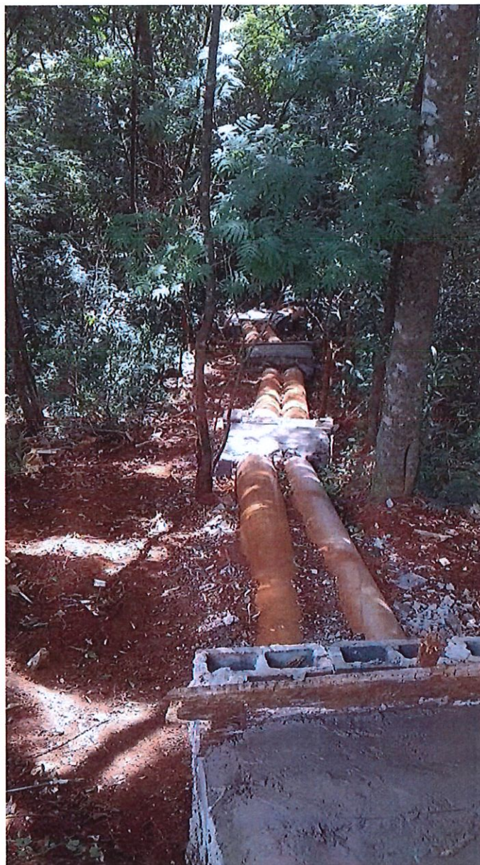
Foto 04: Drenagem Rua Tuiuti
