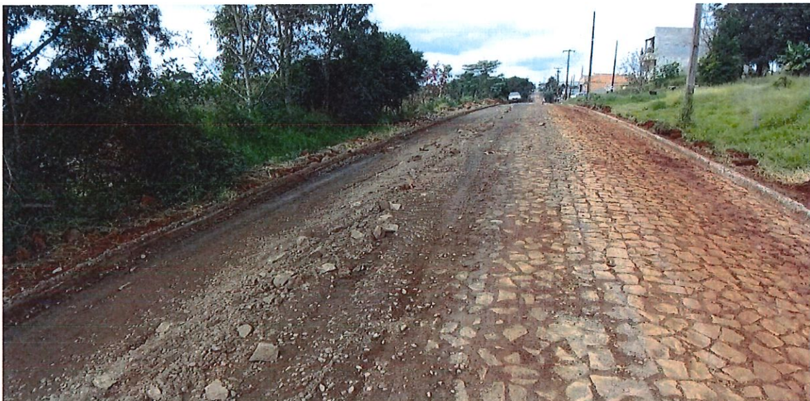
Foto 03: reforço de base Rua do Príncipe
