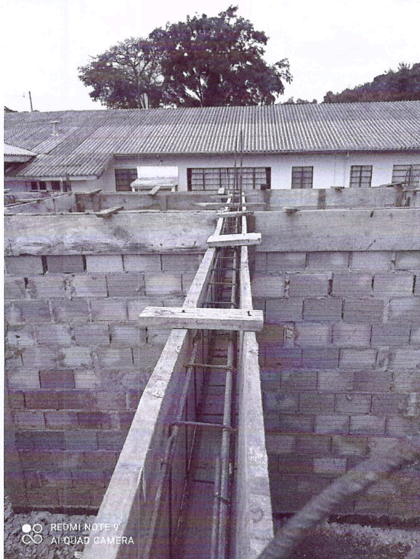
Foto 05: Ampliação Salas de Aula
