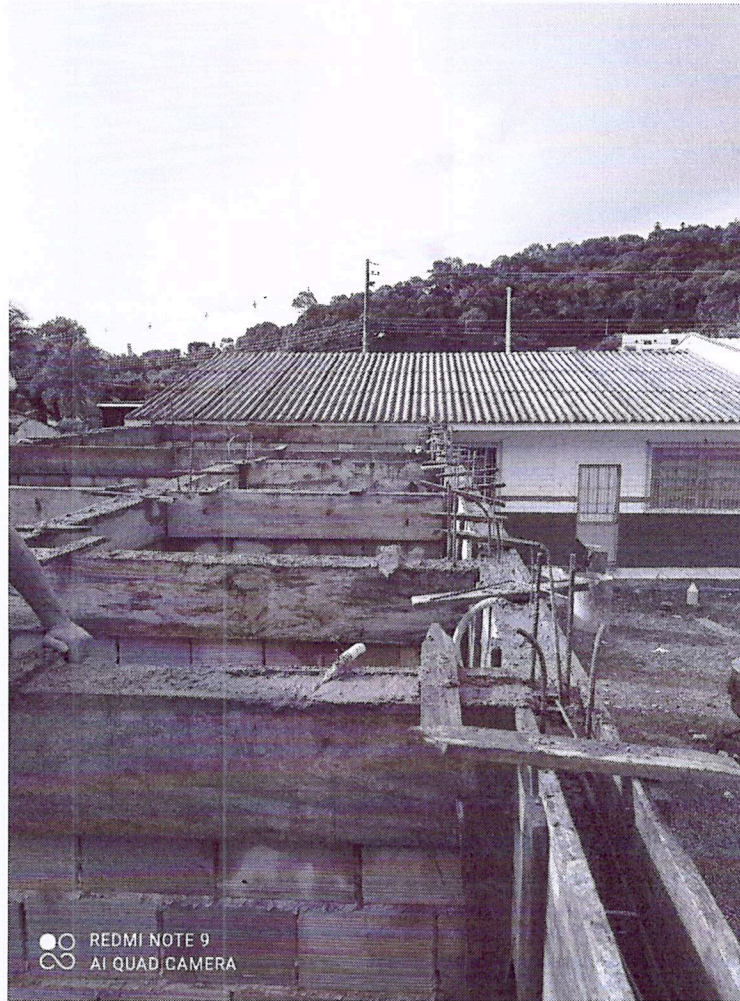
Foto 06: Concretagem Vigas de Cobertura
