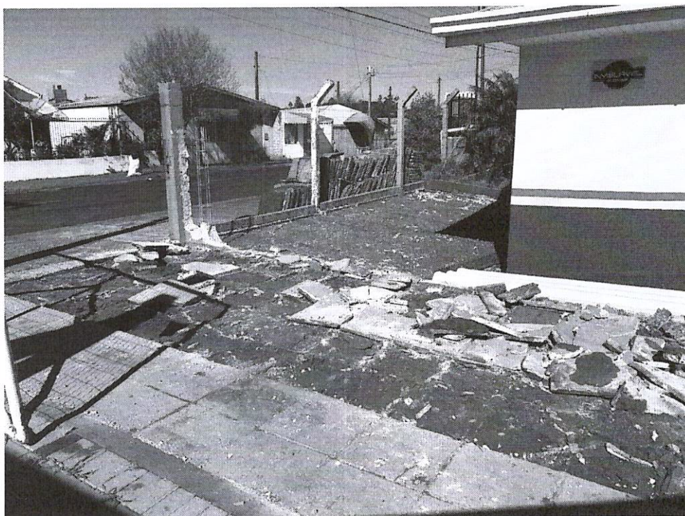
Foto 03: Demolição do piso existente.
