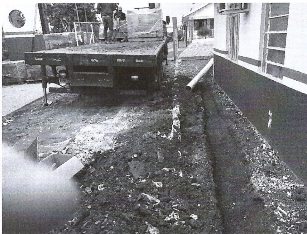
Foto 04: Valas para assentamento da tubulação.
