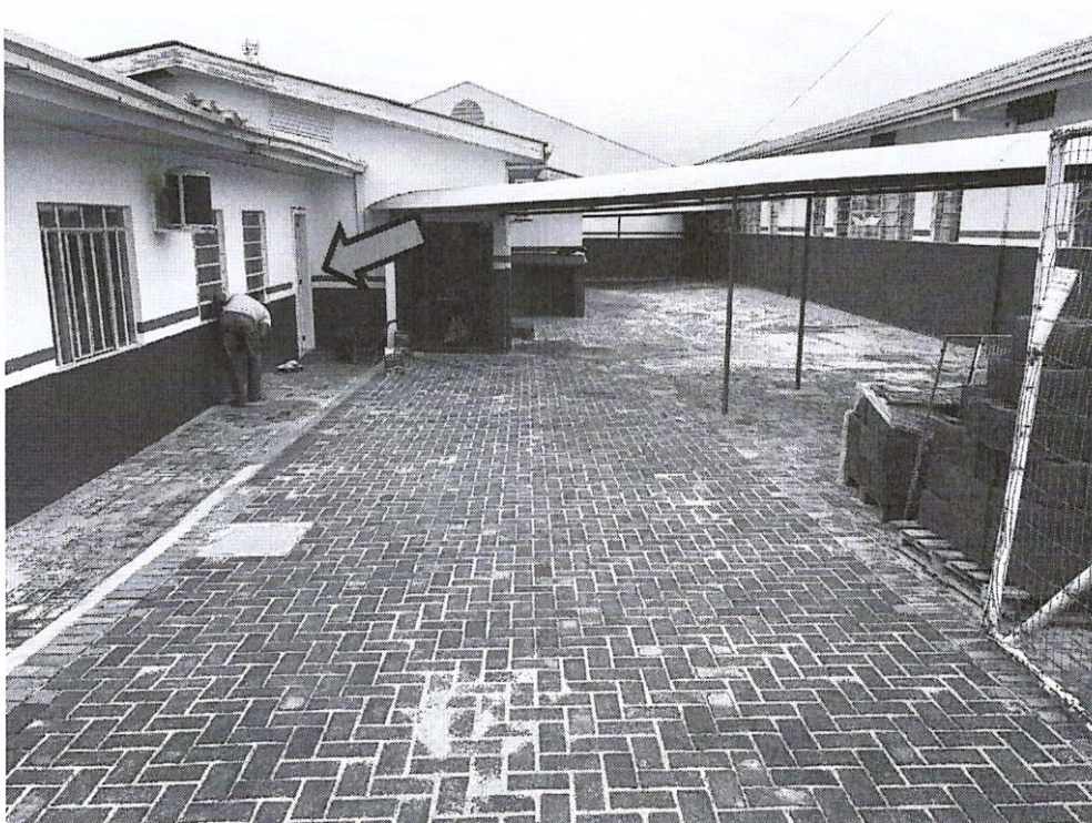
Foto 07: Serviço finalizado e porta instalada.
