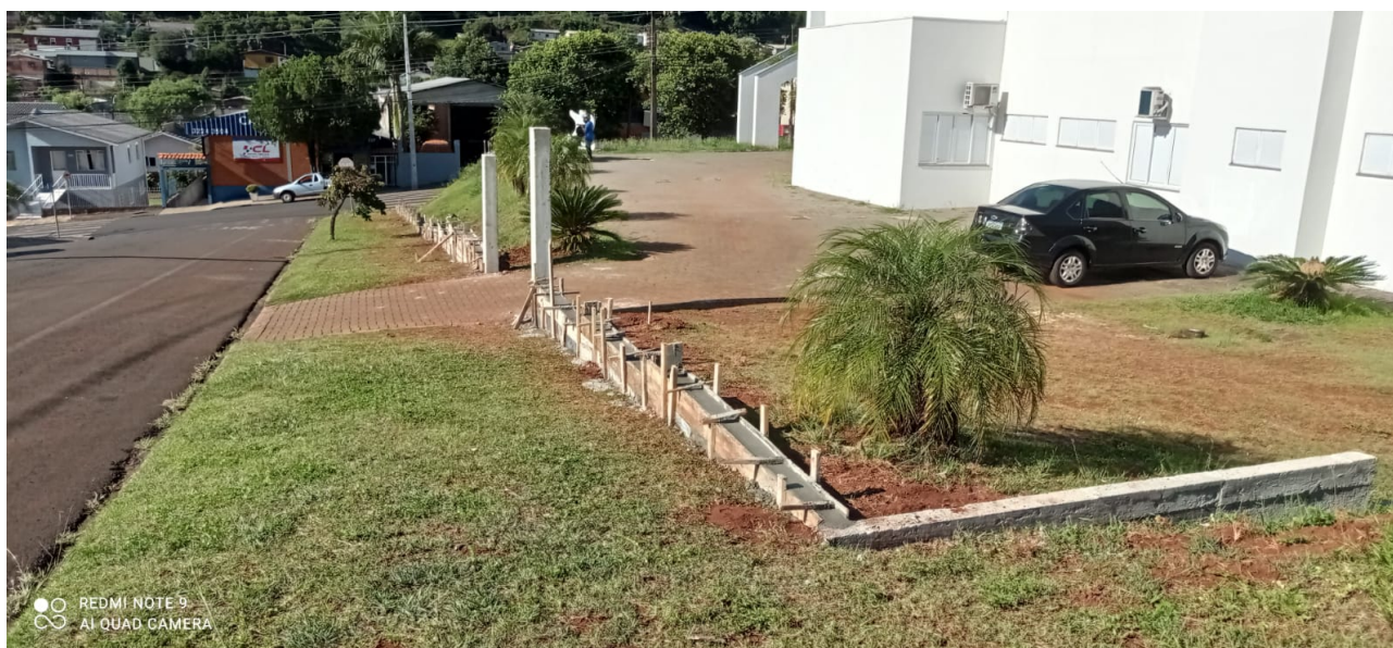
Foto 3: Pilares e vigas baldrame da Lateral da unidade, Rua Maurício Batista Menosso
