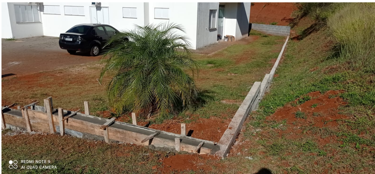
Foto 4: Concretagem das vigas..
