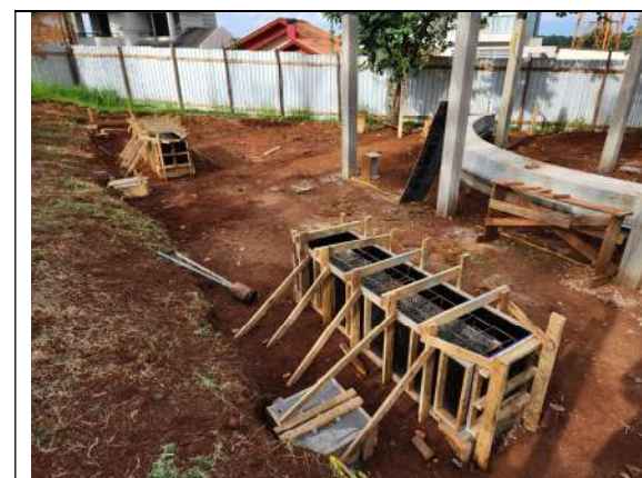
F6: MONTAGEM DOS BANCOS DE CONCRETO
