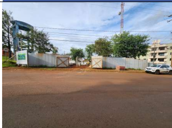
F11: PLACA DE OBRA, TAPUME
