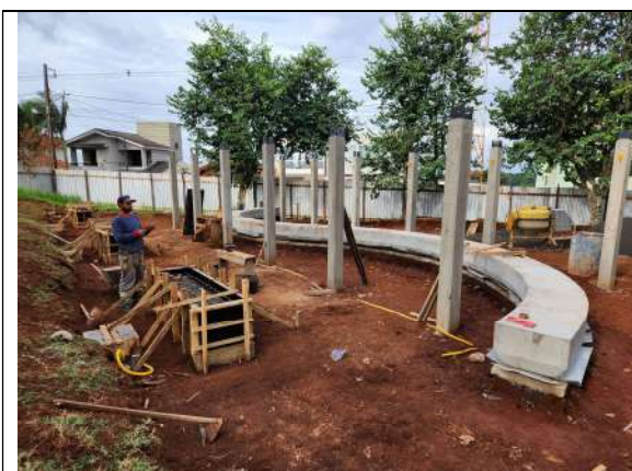
F5: BANCO EM FORMATO DE S, ESTRUTURA DO PERGOLADO
