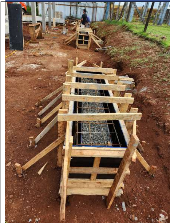
F7: MONTAGEM DOS BANCOS DE CONCRETO
