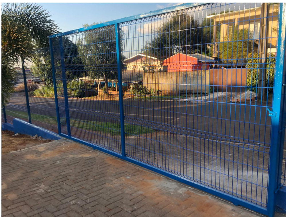
Foto 2: Cercamento – Grades e portões.
