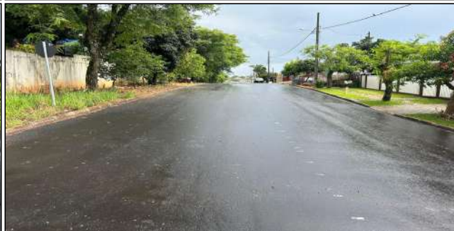
5 | SERVIÇOS EXECUTADOS: PAVIMENTAÇÃO, LIMPEZA E DESOBSTRUÇÃO DE BUEIROS - RUA ITAPUÃ
