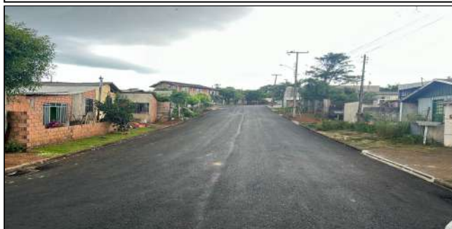
8 | SERVIÇOS EXECUTADOS: TERRAPLENAGEM, BASE E SUB-BASE, PAVIMENTAÇÃO, REDE DE DRENAGEM - RUA LAMARTINE BABO
