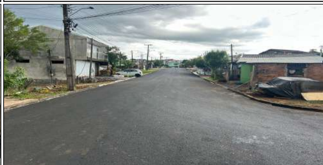
9 | SERVIÇOS EXECUTADOS: TERRAPLENAGEM, BASE E SUB-BASE, PAVIMENTAÇÃO, REDE DE DRENAGEM, LIMPEZA E DESOBSTRUÇÃO DE BUEIROS - TRAVESSA ORLANDO
