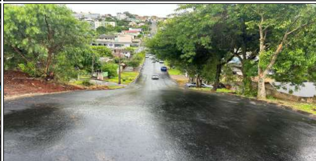
15 | SERVIÇOS EXECUTADOS: TERRAPLENAGEM, PAVIMENTAÇÃO, LIMPEZA E DESOBSTRUÇÃO DE BUEIROS - RUA EMÍLIO DE NEGRI
