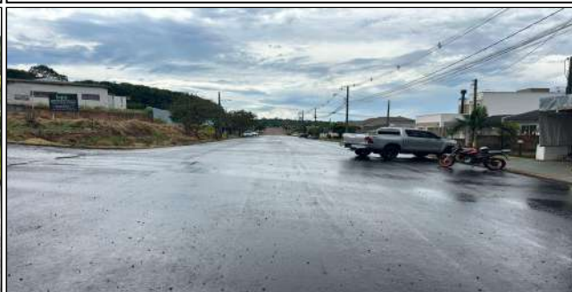
17 | SERVIÇOS EXECUTADOS: TERRAPLENAGEM, PAVIMENTAÇÃO, LIMPEZA E DESOBSTRUÇÃO DE BUEIROS - RUA JOÃO JUGLAIR JR
