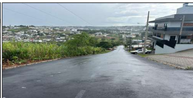
3 | SERVIÇOS EXECUTADOS: TERRAPLENAGEM, BASE E SUB-BASE, PAVIMENTAÇÃO, REDE DE DRENAGEM, LIMPEZA E DESOBSTRUÇÃO DE BUEIROS - RUA JOSÉ DA ROCHA
