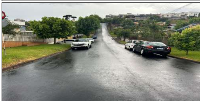
16 | SERVIÇOS EXECUTADOS: TERRAPLENAGEM, PAVIMENTAÇÃO, LIMPEZA E DESOBSTRUÇÃO DE BUEIROS - RUA EMÍLIO DE NEGRI
