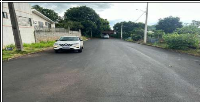
7 | SERVIÇOS EXECUTADOS: TERRAPLENAGEM, BASE E SUB-BASE, PAVIMENTAÇÃO, REDE DE DRENAGEM - RUA LAMARTINE BABO
