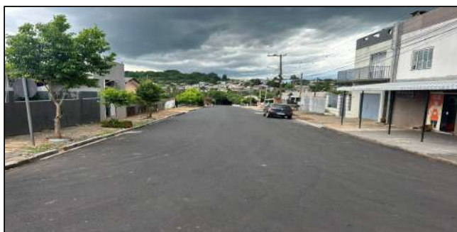
10 | SERVIÇOS EXECUTADOS: TERRAPLENAGEM, BASE E SUB-BASE, PAVIMENTAÇÃO, REDE DE DRENAGEM, LIMPEZA E DESOBSTRUÇÃO DE BUEIROS - TRAVESSA ORLANDO
