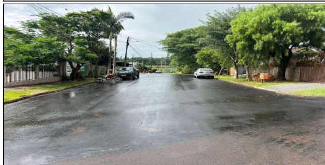
6 | SERVIÇOS EXECUTADOS: PAVIMENTAÇÃO, LIMPEZA E DESOBSTRUÇÃO DE BUEIROS - RUA ITAPUÃ
