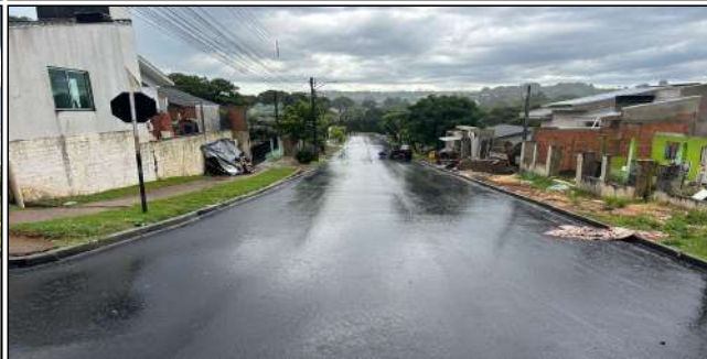
13 | SERVIÇOS EXECUTADOS: TERRAPLENAGEM, BASE E SUB-BASE, PAVIMENTAÇÃO, REDE DE DRENAGEM - RUA NORBERTO MARASCHIN
