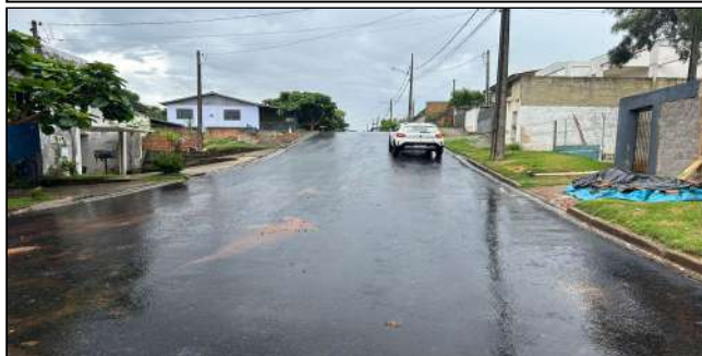
14 | SERVIÇOS EXECUTADOS: TERRAPLENAGEM, BASE E SUB-BASE, PAVIMENTAÇÃO, REDE DE DRENAGEM - RUA NORBERTO MARASCHIN
