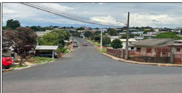
11 | SERVIÇOS EXECUTADOS: TERRAPLENAGEM, BASE E SUB-BASE, PAVIMENTAÇÃO, REDE DE DRENAGEM, LIMPEZA E DESOBSTRUÇÃO DE BUEIROS - RUA ITU
