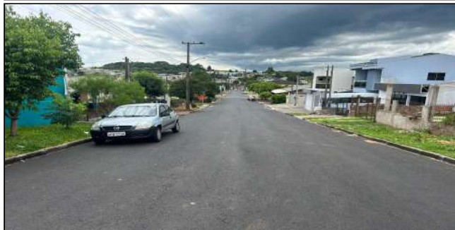
12 | SERVIÇOS EXECUTADOS: TERRAPLENAGEM, BASE E SUB-BASE, PAVIMENTAÇÃO, REDE DE DRENAGEM, LIMPEZA E DESOBSTRUÇÃO DE BUEIROS - RUA ITU
