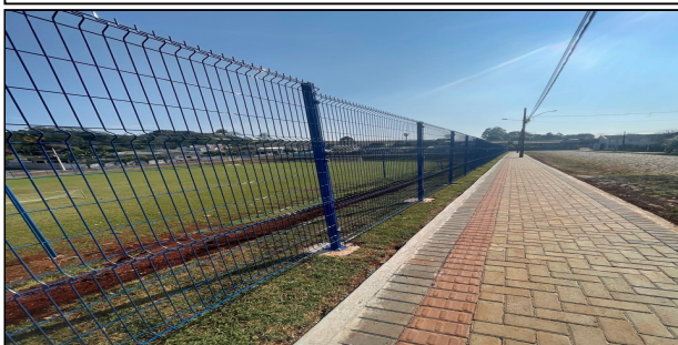
5 | ALAMBRADO E CALÇADA
