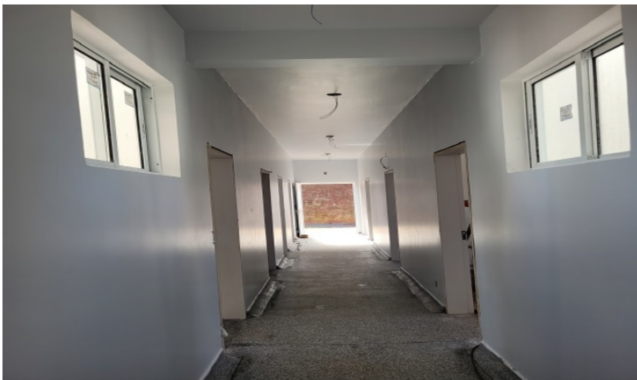
Foto 8: Circulação (revestimento interno).
