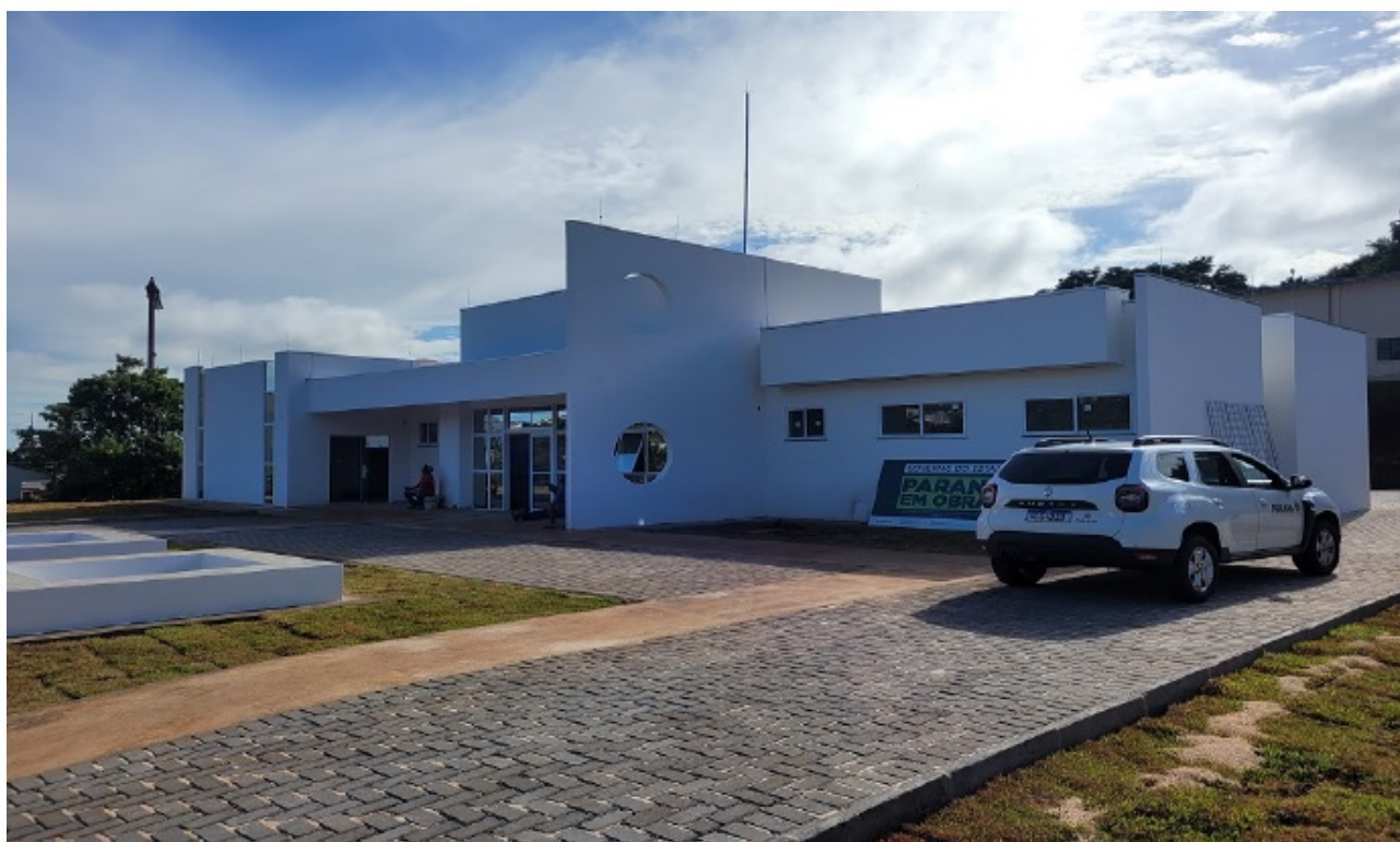
Foto 1: Fachada da Obra (execução da pintura externa, paver e calçada)
