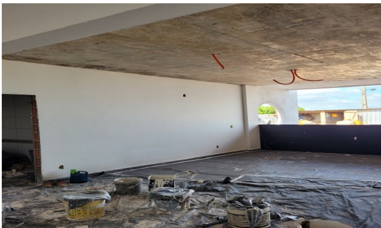
Foto 8: Área interna. Recepção.
