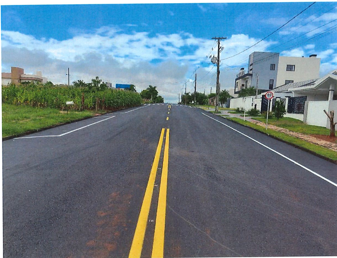
Foto 23: Rua Vitélio Parzianello – Pavimentação
