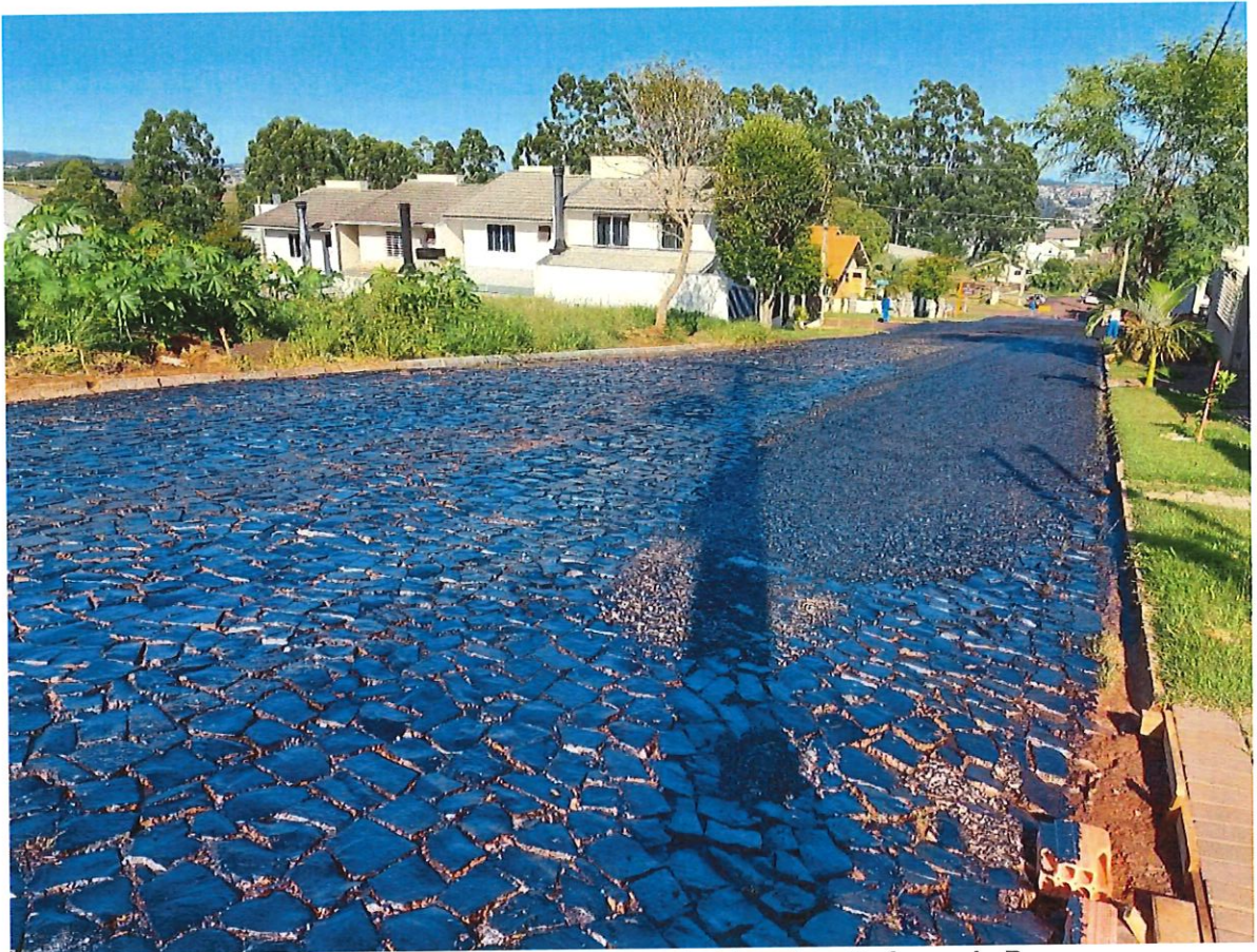
Foto 07: Rua Lídio Guerra – Pintura de Ligação e Reforço de Base
