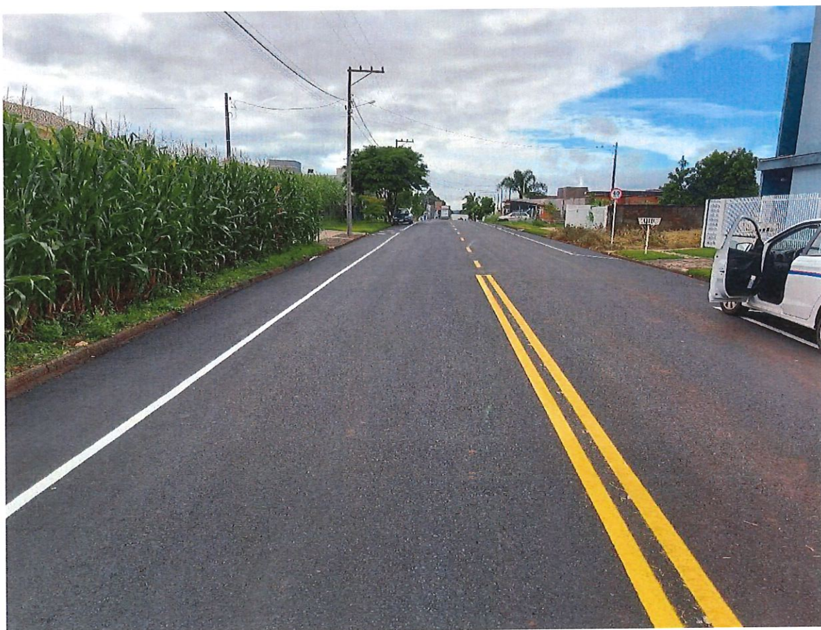
Foto 24: Rua Angela Parzianello – Pavimentação
