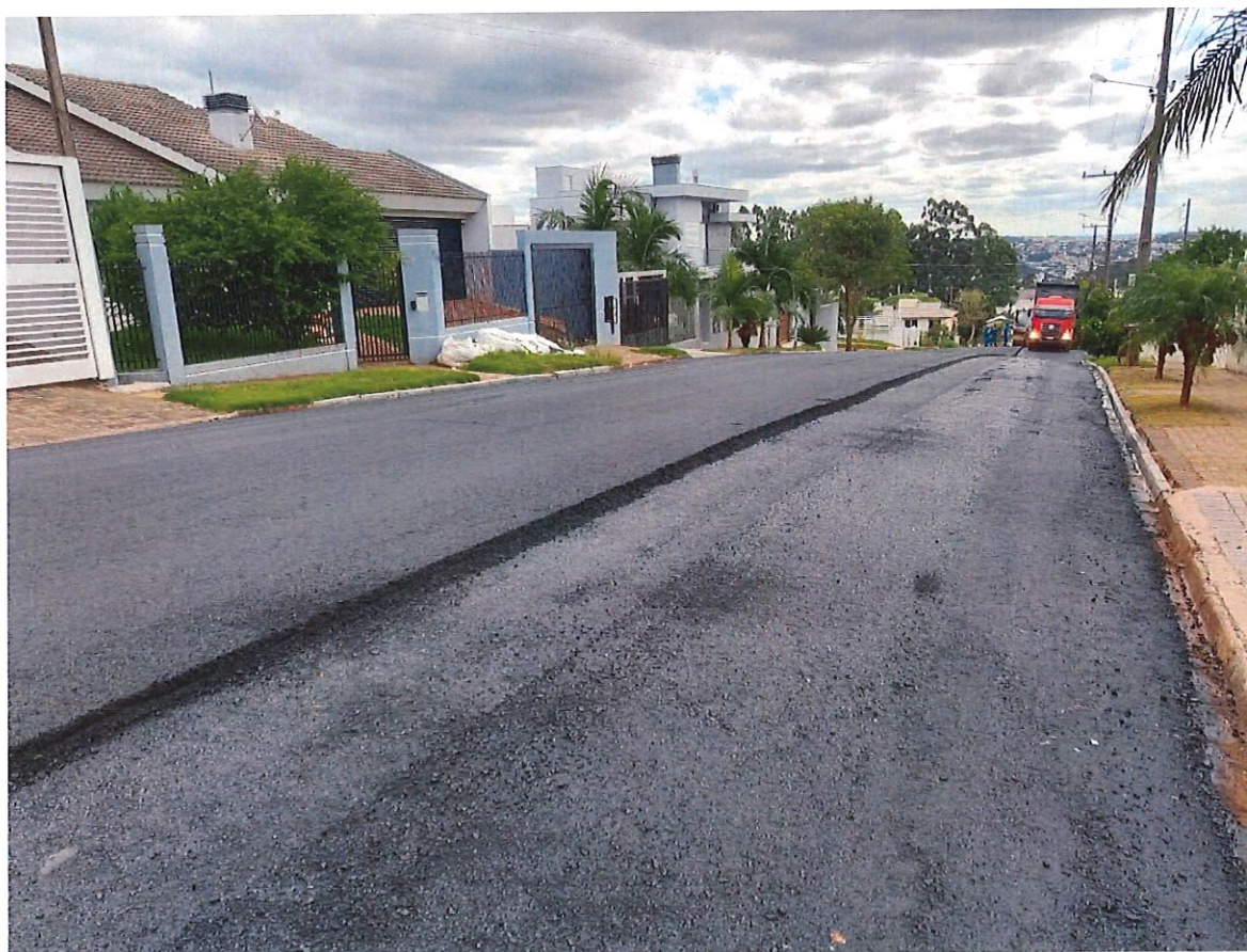
Foto 16: Rua Lídio Guerra - Pavimentação
