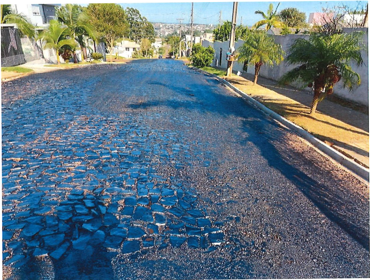
Foto 08: Rua Lídio Guerra – Pintura de Ligação e Reforço de Base e Meio-Fio
