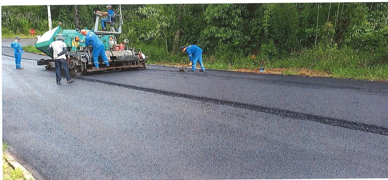
Foto 21: Rua Irineu Parzianello – Reperfilagem e Pavimentação
