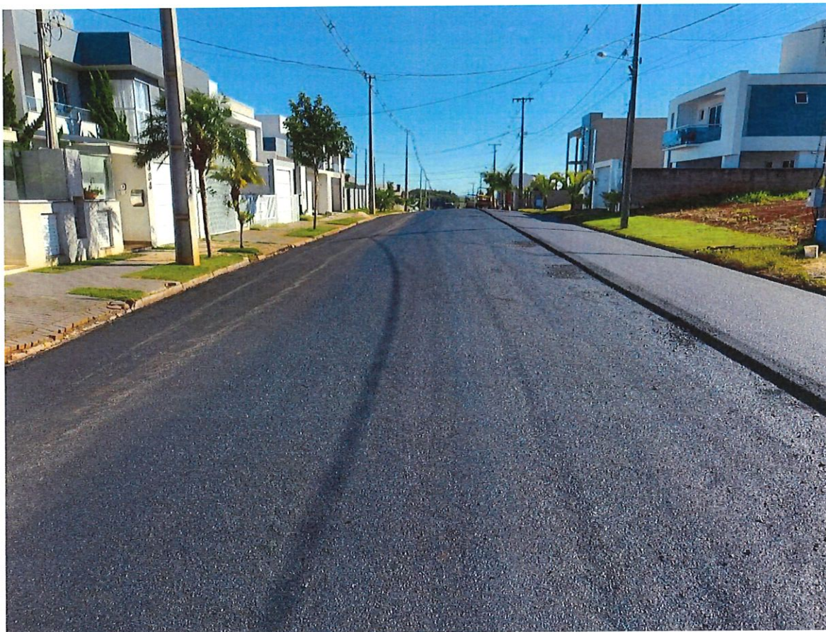
Foto 15: Rua Maria Bombarda Oldoni – Reperfilagem e Pavimentação
