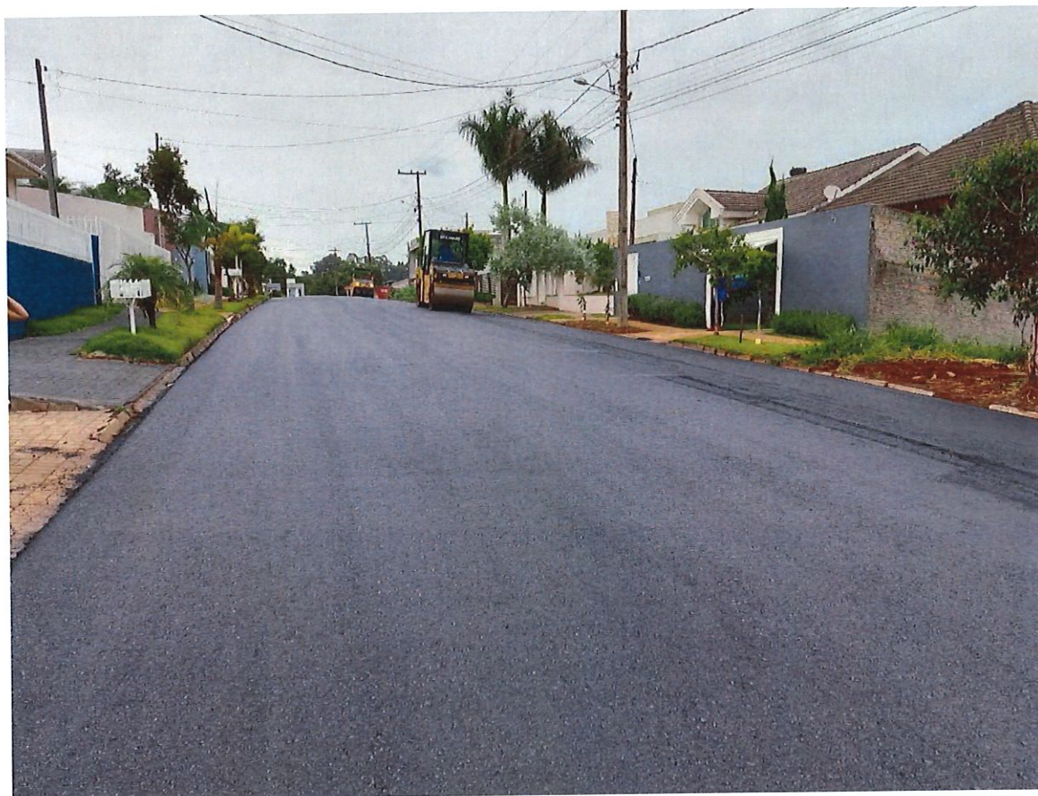
Foto 19: Rua Bolislau Fidalski - Pavimentação
