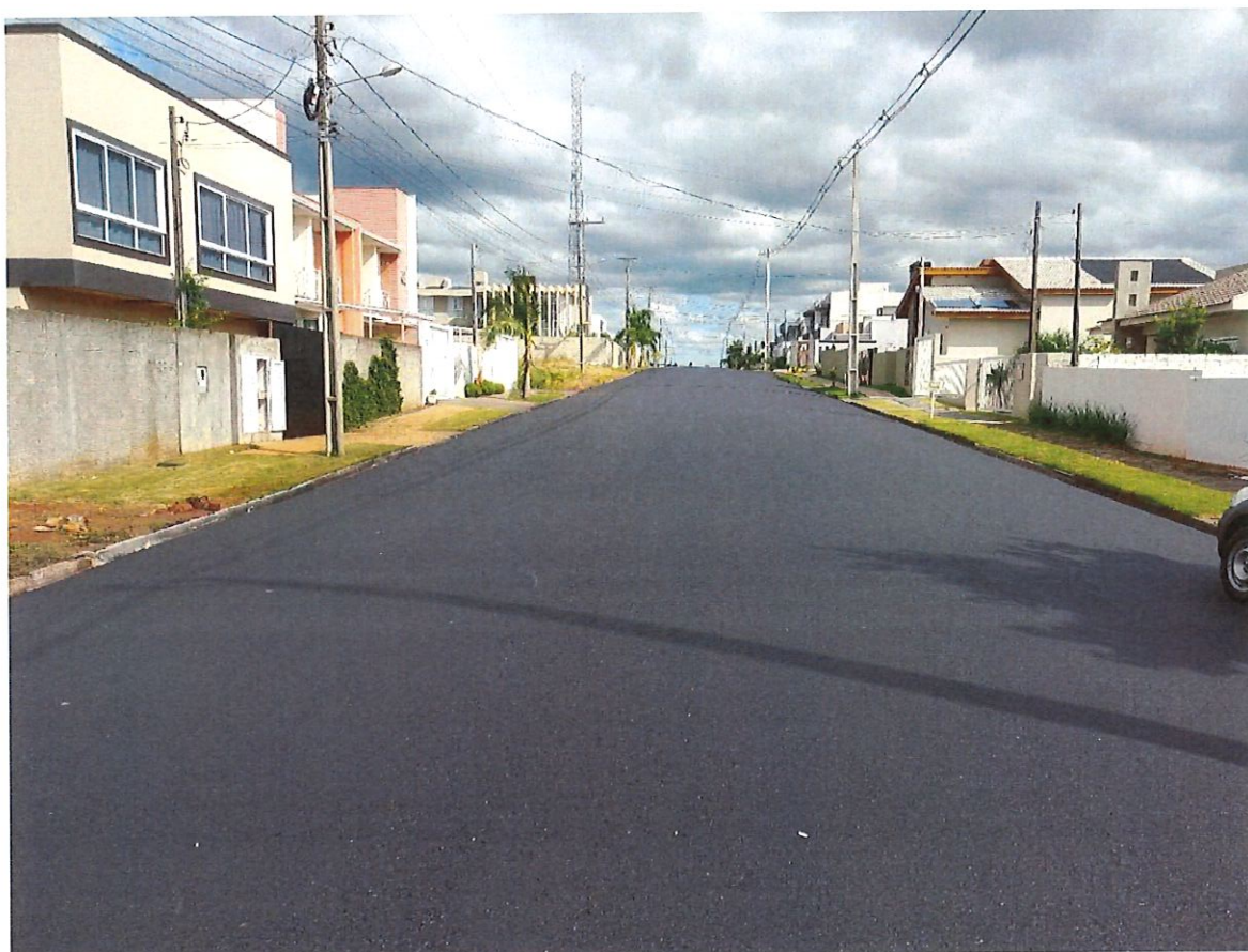
Foto 17: Rua Maria Bombarda Oldoni – Pavimentação
