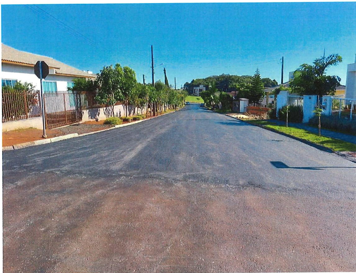
Foto 11: Rua Mário João Perim – Pavimentação
