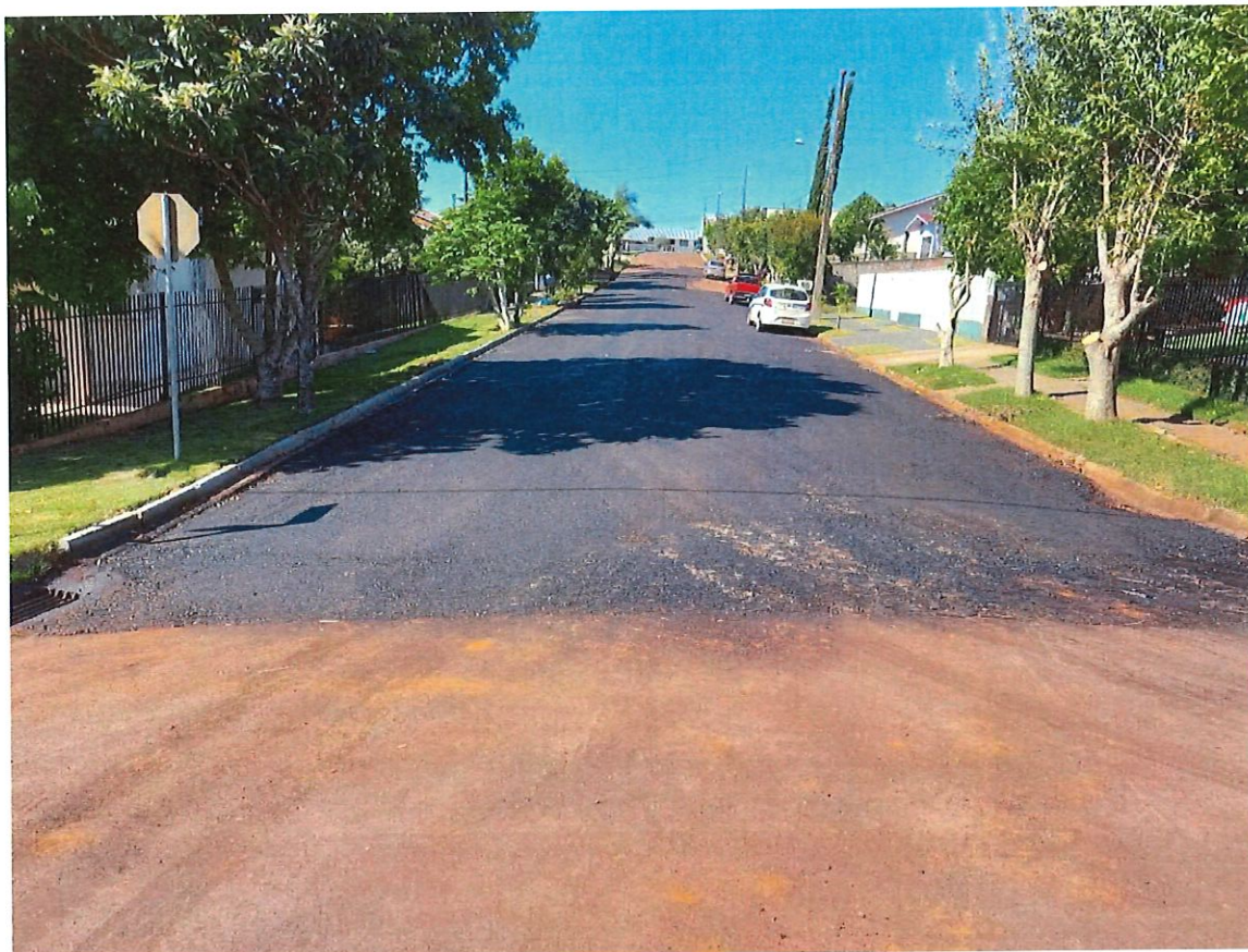
Foto 09: Rua Mário João Perim – Reforço de Base e Meio-Fio
