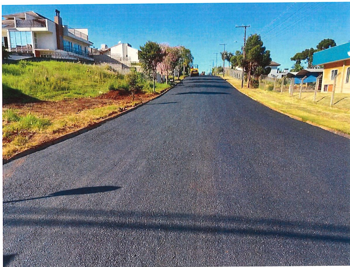
Foto 04: Rua Bolislau Fidalski - Reperfilagem
