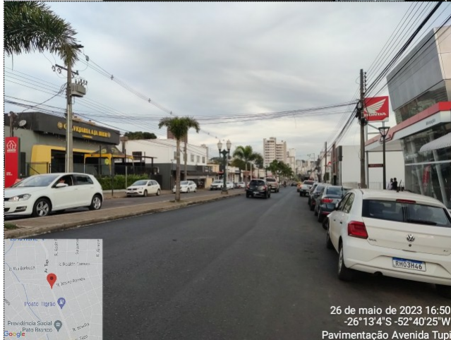
Imagem 06: Pavimentação em CBUQ, calçadas e meio-fio.
