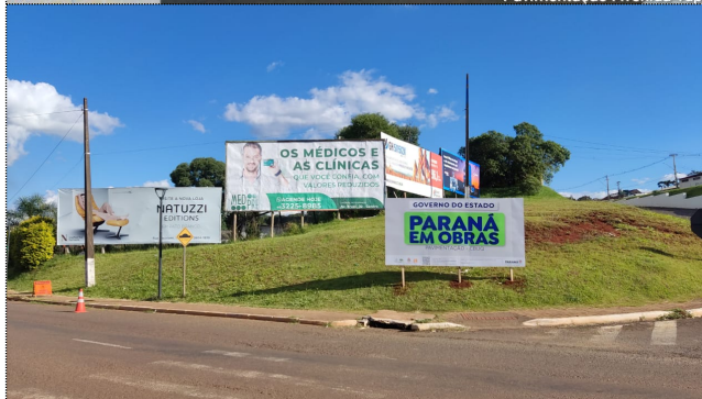
Imagem 09: Placa da Obra
