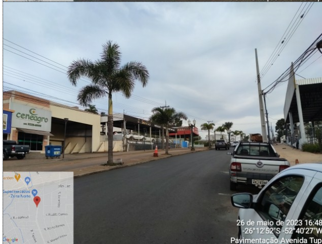
Imagem 05: Pavimentação em CBUQ, calçadas e meio-fio.
