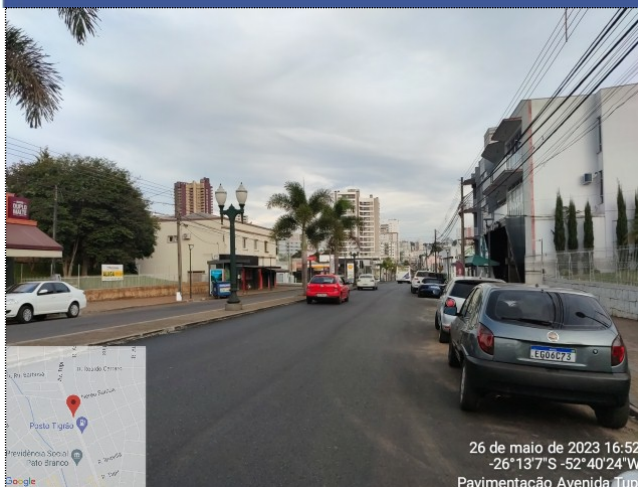
Imagem 07: Pavimentação em CBUQ, calçadas e meio-fio.
