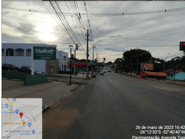
Imagem 02: Pavimentação em CBUQ, calçadas e meio-fio.
