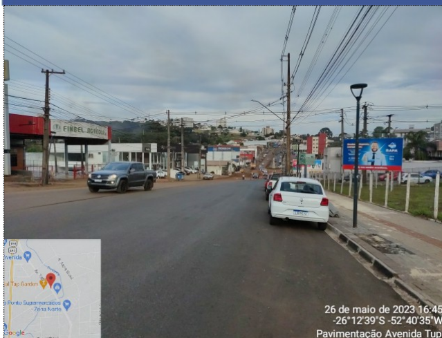
Imagem 04: Pavimentação em CBUQ, calçadas e meio-fio.
