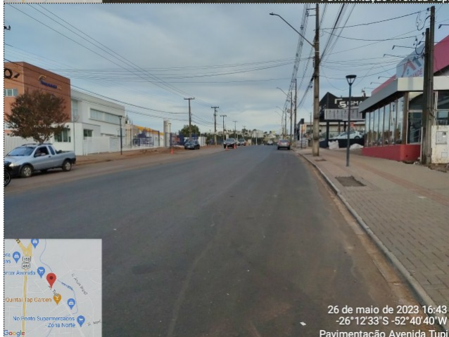
Imagem 03: Pavimentação em CBUQ, calçadas e meio-fio.
