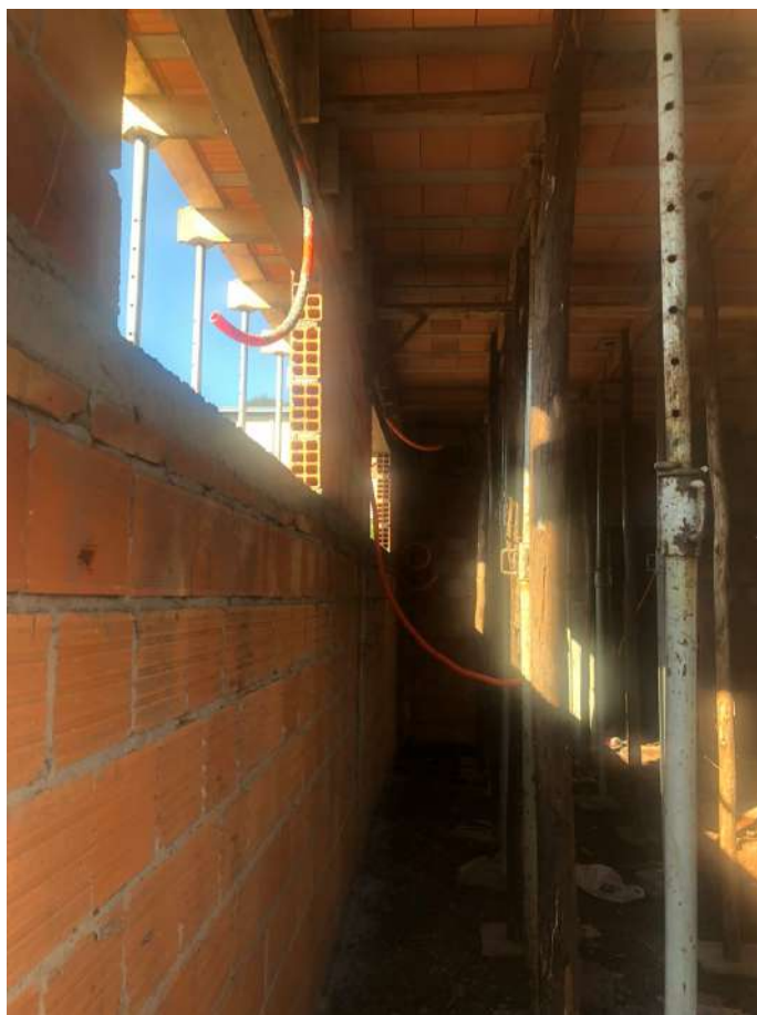
Foto 3: Escoramento de Laje e eletrodutos da rede elétrica.
