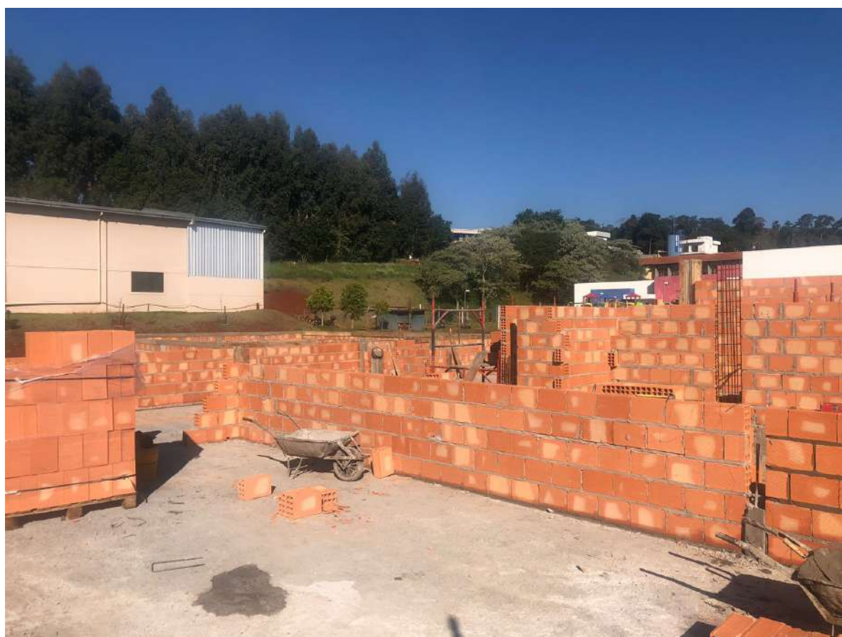
Foto 8: Levantamento de alvenaria de vedação (platibandas na cobertura).
