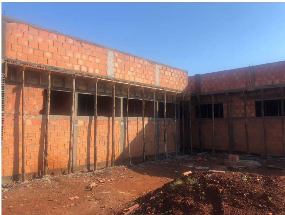
Foto 2: Levantamento de Alvenarias de vedação.
