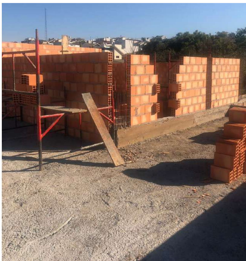
Foto 6: Levantamento de alvenaria de vedação (platibandas na cobertura).
