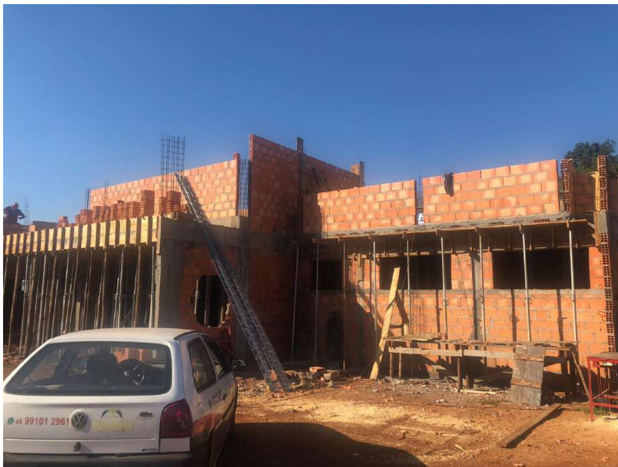
Foto 1: Estrutura de Vigas e pilares.
