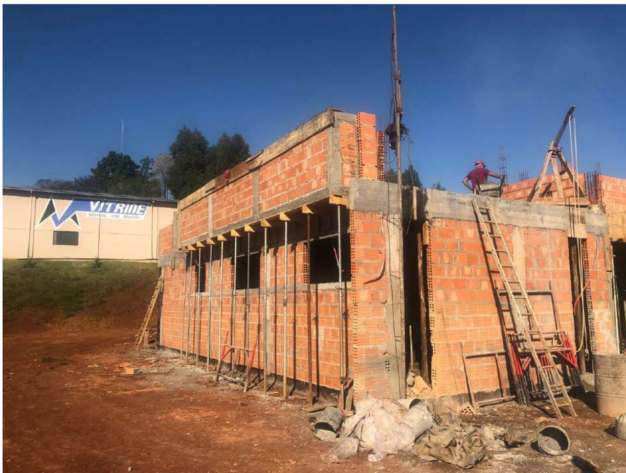
Foto 5: Levantamento de alvenaria de vedação (platibandas).
