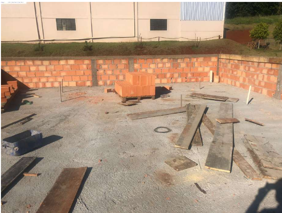
Foto 7: Levantamento de alvenaria de vedação (platibandas na laje de cobertura).
