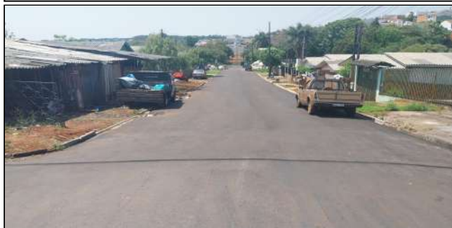
15 | SERVIÇOS EXECUTADOS: TERRAPLENAGEM, BASE E SUB-BASE, PAVIMENTAÇÃO, REDE DE DRENAGEM - RUA PEDRO LOBO
