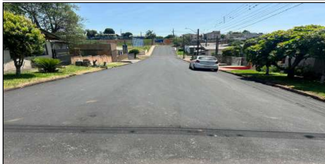
21 | SERVIÇOS EXECUTADOS: TERRAPLENAGEM, BASE E SUB-BASE, PAVIMENTAÇÃO, REDE DE DRENAGEM - RUA PRESIDENTE PRUDENTE
