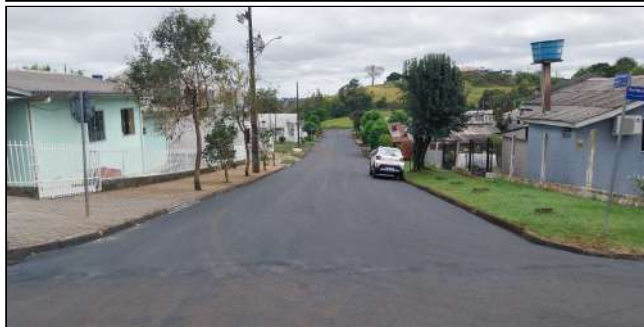
9 | SERVIÇOS EXECUTADOS: TERRAPLENAGEM, BASE E SUB-BASE, PAVIMENTAÇÃO, LIMPEZA E DESOBSTRUÇÃO DE BUEIROS, REDE DE DRENAGEM - RUA ÉRICO VERÍSSIMO
