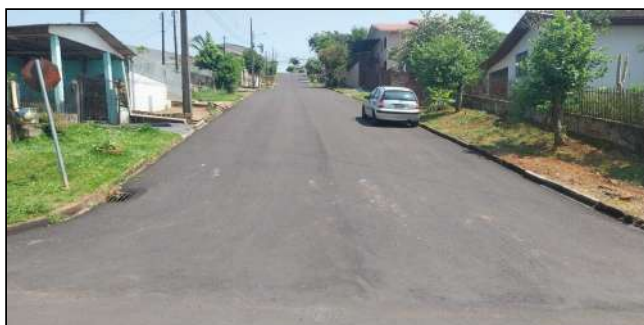
11 | SERVIÇOS EXECUTADOS: TERRAPLENAGEM, BASE E SUB-BASE, PAVIMENTAÇÃO, LIMPEZA E DESOBSTRUÇÃO DE BUEIROS, REDE DE DRENAGEM - RUA GUAPORÉ
