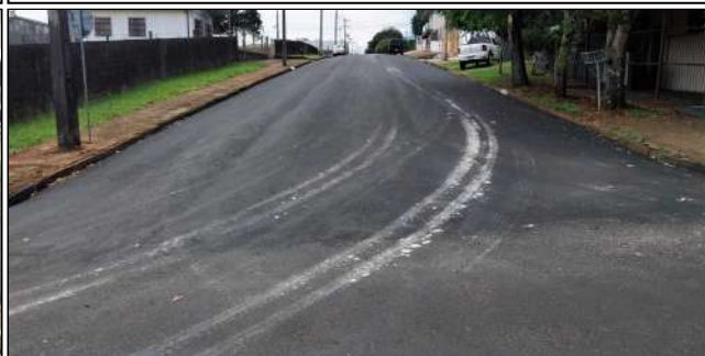
18 | SERVIÇOS EXECUTADOS: TERRAPLENAGEM, PAVIMENTAÇÃO, LIMPEZA E DESOBSTRUÇÃO DE BUEIROS - RUA SETE DE SETEMBRO
