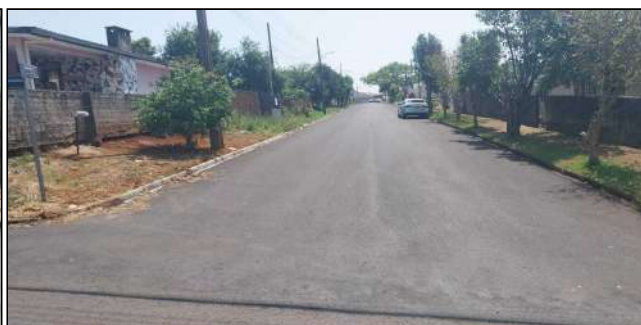
12 | SERVIÇOS EXECUTADOS: TERRAPLENAGEM, BASE E SUB-BASE, PAVIMENTAÇÃO - RUA ITÁ
