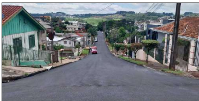
19 | SERVIÇOS EXECUTADOS: TERRAPLENAGEM, BASE E SUB-BASE, PAVIMENTAÇÃO, LIMPEZA E DESOBSTRUÇÃO DE BUEIROS, REDE DE DRENAGEM - RUA VICENTE FERREIRA
