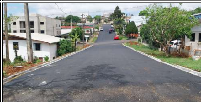
14 | SERVIÇOS EXECUTADOS: TERRAPLENAGEM, BASE E SUB-BASE, PAVIMENTAÇÃO, LIMPEZA E DESOBSTRUÇÃO DE BUEIROS, REDE DE DRENAGEM - RUA LONDRINA
