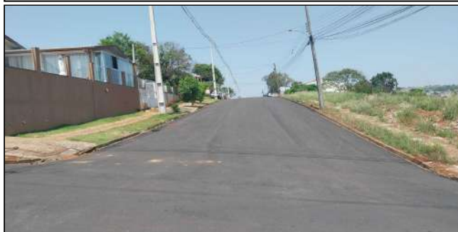
7 | SERVIÇOS EXECUTADOS: TERRAPLENAGEM, BASE E SUB-BASE, PAVIMENTAÇÃO, LIMPEZA E DESOBSTRUÇÃO DE BUEIROS, REDE DE DRENAGEM - RUA DUQUE DE CAXIAS
