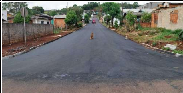
8 | SERVIÇOS EXECUTADOS: TERRAPLENAGEM, BASE E SUB-BASE, PAVIMENTAÇÃO, LIMPEZA E DESOBSTRUÇÃO DE BUEIROS, REDE DE DRENAGEM - RUA ÉRICO VERÍSSIMO
