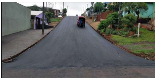
3 | SERVIÇOS EXECUTADOS: TERRAPLENAGEM, BASE E SUB-BASE, PAVIMENTAÇÃO, REDE DE DRENAGEM - RUA 21 DE ABRIL - T2
