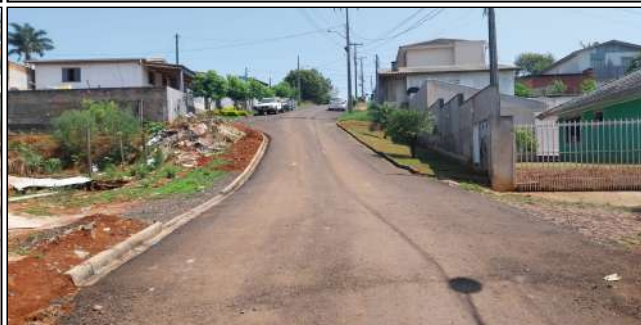
16 | SERVIÇOS EXECUTADOS: TERRAPLENAGEM, BASE E SUB-BASE, PAVIMENTAÇÃO, LIMPEZA E DESOBSTRUÇÃO DE BUEIROS, REDE DE DRENAGEM - RUA PRESIDENTE
