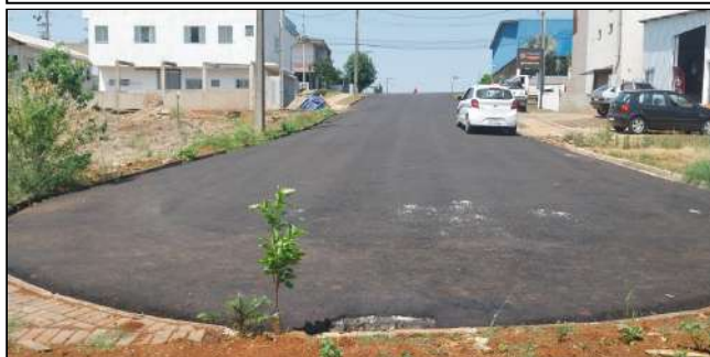
17 | SERVIÇOS EXECUTADOS: TERRAPLENAGEM, BASE E SUB-BASE, PAVIMENTAÇÃO, LIMPEZA E DESOBSTRUÇÃO DE BUEIROS, REDE DE DRENAGEM - SÃO TOMÉ
