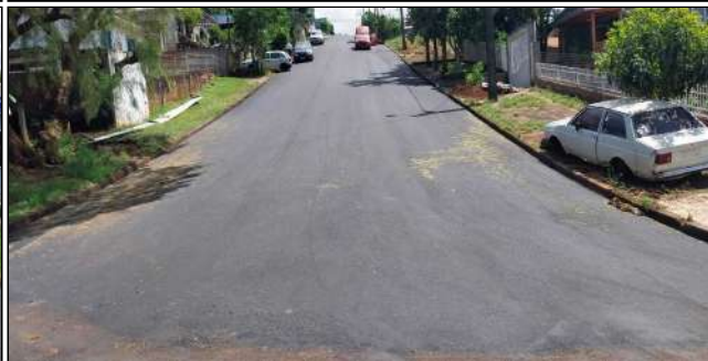
10 | SERVIÇOS EXECUTADOS: TERRAPLENAGEM, PAVIMENTAÇÃO, LIMPEZA E DESOBSTRUÇÃO DE BUEIROS - RUA FIORELO ZANDONÁ
