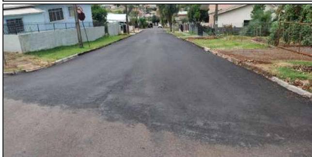
13 | SERVIÇOS EXECUTADOS: TERRAPLENAGEM, PAVIMENTAÇÃO, LIMPEZA E DESOBSTRUÇÃO DE BUEIROS - RUA LAFFAIETE
