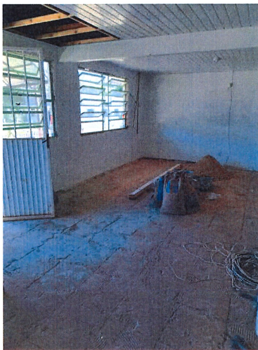
Foto 3: Remoção de forro e de revestimento cerâmico de piso.
