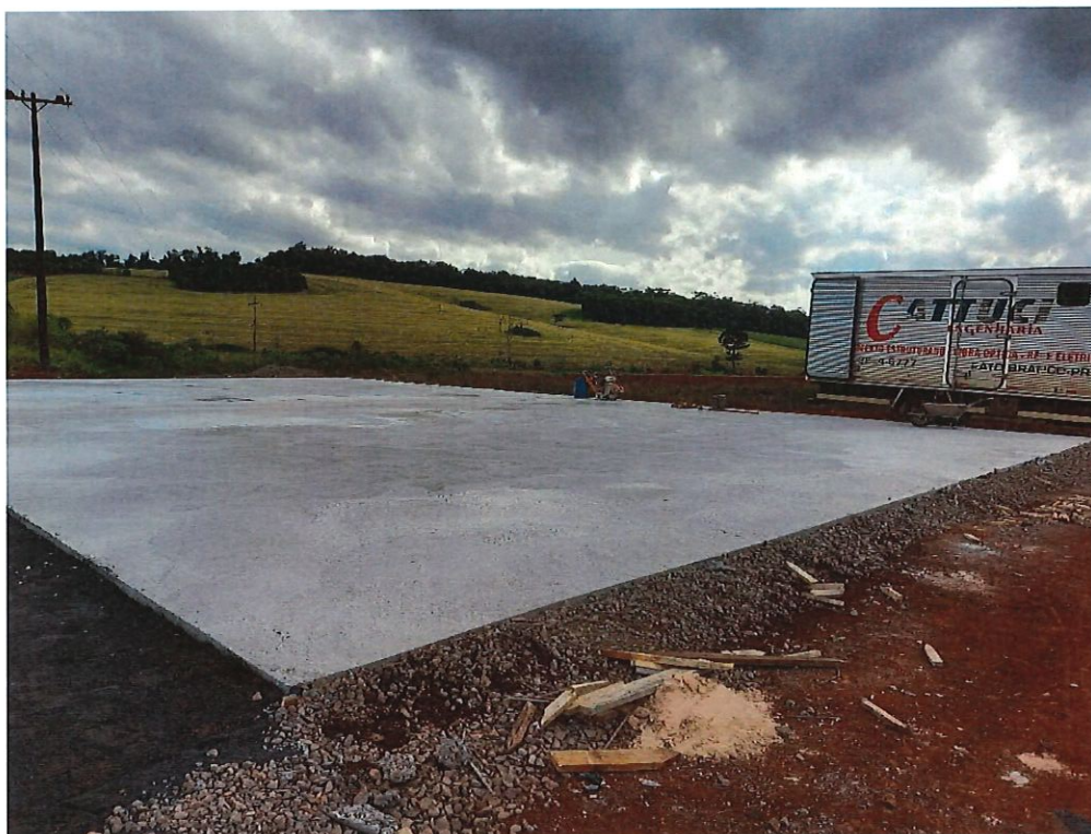
Foto 01: Piso de concreto da quadra de basquete (vista 01)
