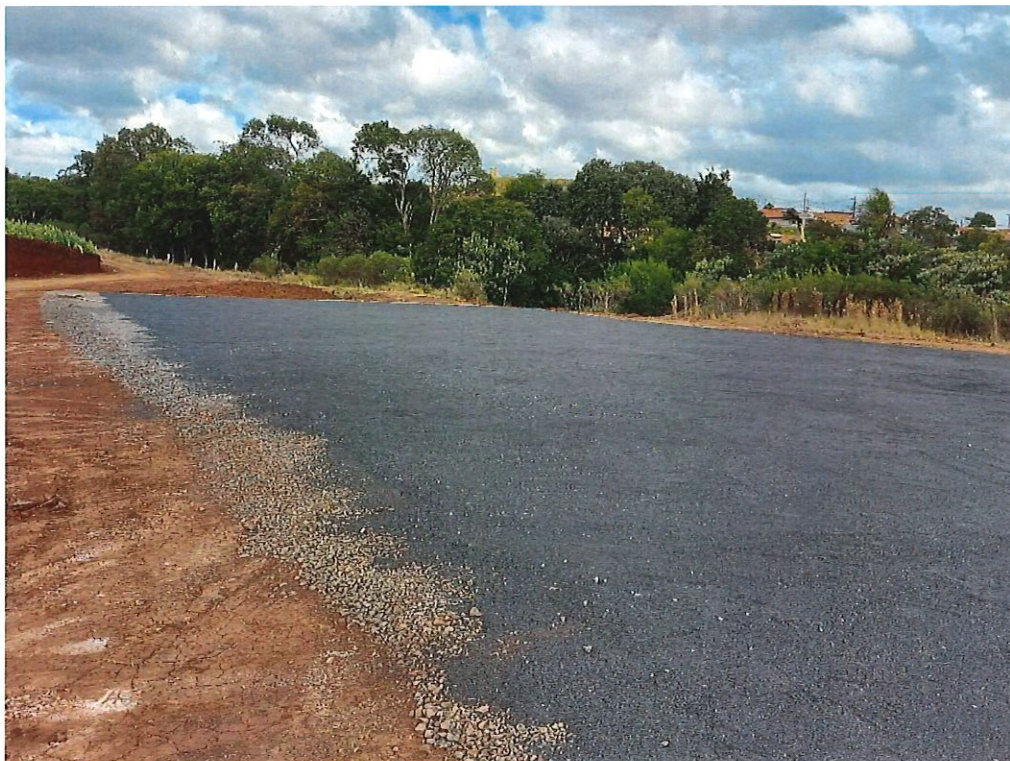
Foto 03: Embasamento de pó de pedra sobre brita graduada
