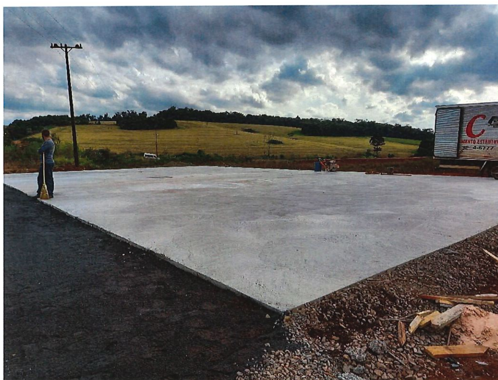
Foto 02: Piso de concreto da quadra de basquete (vista 02)
