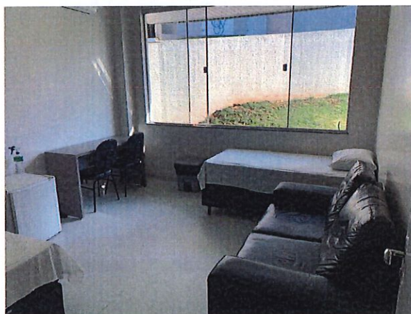
Foto 4: Manta vinílica instalada
