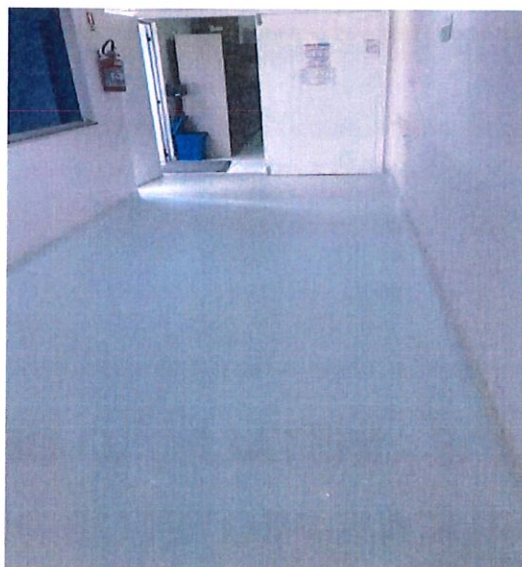
Foto 1: Manta vinílica instalada
