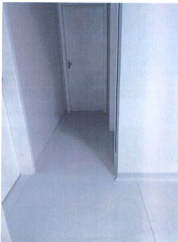
Foto 6: Manta vinílica instalada
