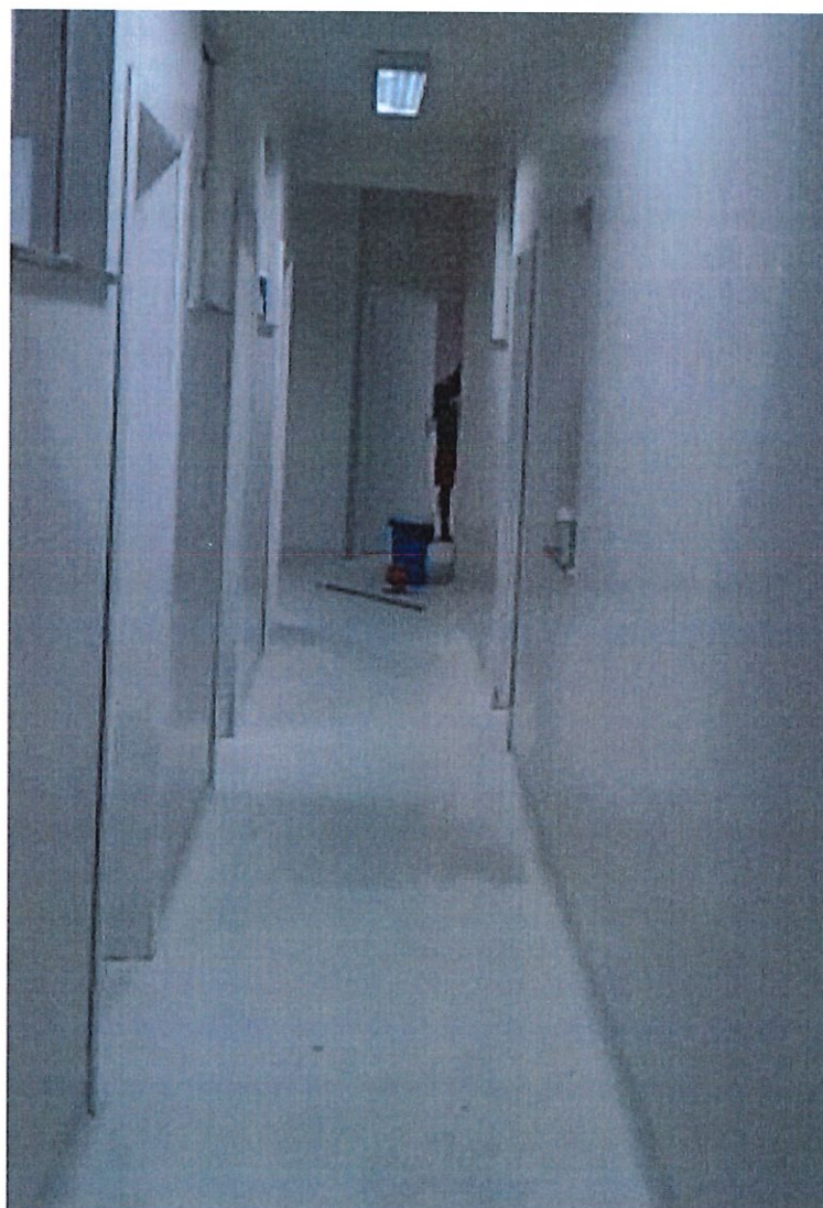
Foto 2: Manta vinílica instalada
