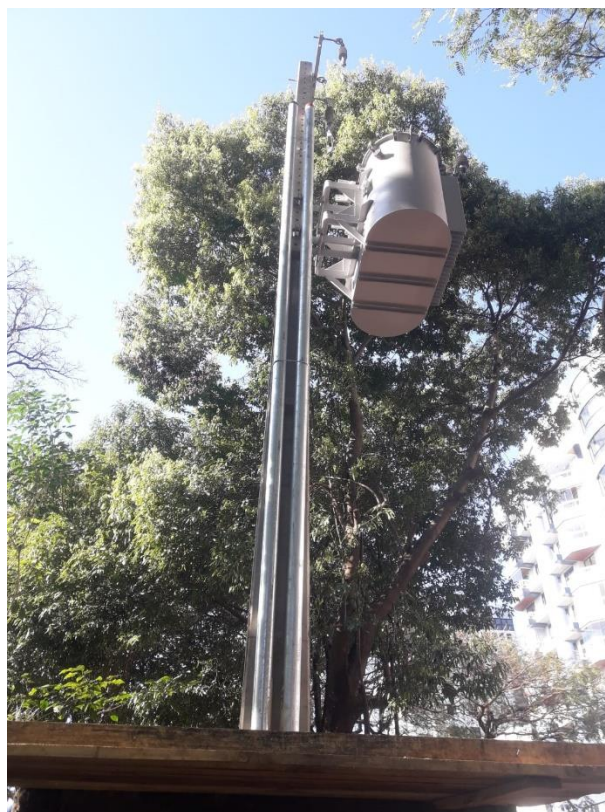
Figura 2 – Detalhe instalação poste duplo T B300 com eletrodutos galvanizados Ø3\"
