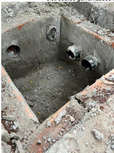
Figura 3 – Detalhe da construção da caixa de passagem.
