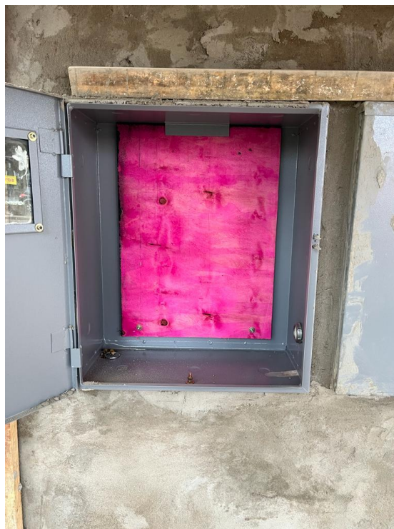
Figura 5 – Detalhe da região interna da caixa de medição, com bucha de alumínio.
