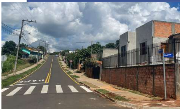
SINALIZAÇÃO VERTICAL RUA CELESTE MOCELIN (FOTO 25)
