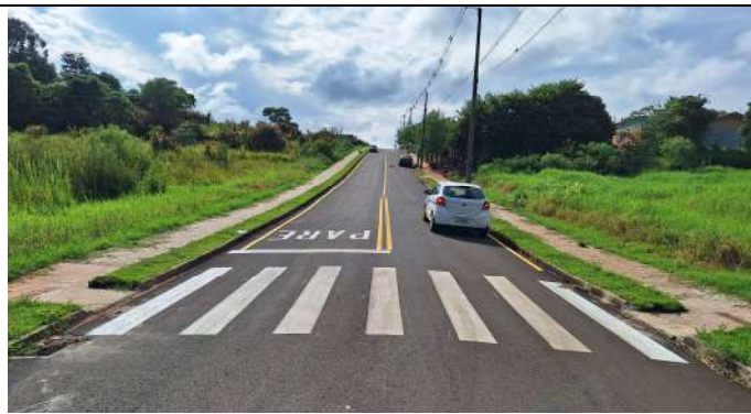
PAVIMENTAÇÃO EM CBUQ, SINALIZAÇÃO HORIZONTAL RUA ANDRÉ CAVALLI (FOTO 12)
