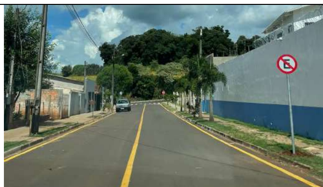
SINALIZAÇÃO VERTICAL E HORIZONTAL RUA CELESTE MOCELIN (FOTO 28)
