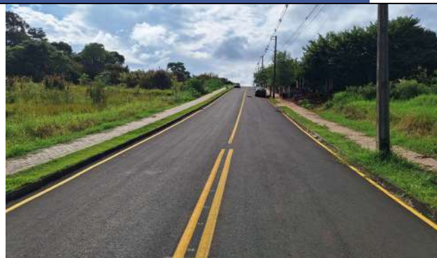
PAVIMENTAÇÃO EM CBUQ, SINALIZAÇÃO HORIZONTAL E CALÇADAS RUA ANDRÉ CAVALLI (FOTO 14)
