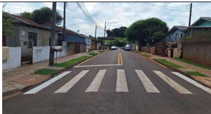
PAVIMENTAÇÃO E SINALIZAÇÃO HORIZONTAL RUA CELESTE MOCELIN (FOTO 10)
