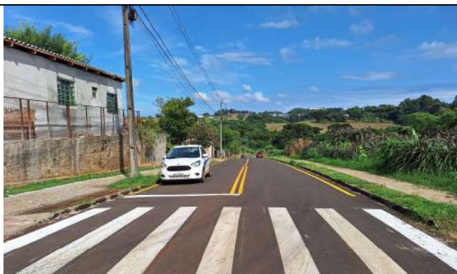
PAVIMENTAÇÃO EM CBUQ, SINALIZAÇÃO HORIZONTAL RUA ANDRÉ CAVALLI (FOTO 15)
