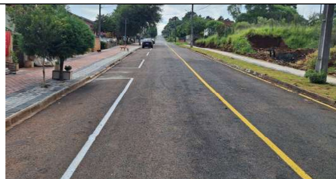
PAVIMENTAÇÃO, SINALIZAÇÃO HORIZONTAL E CALÇADAS RUA MARÍLIA (FOTO 6)
