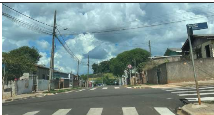
SINALIZAÇÃO VERTICAL RUA CELESTE MOCELIN (FOTO 27)
