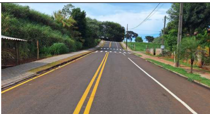
PAVIMENTAÇÃO EM CBUQ, SINALIZAÇÃO HORIZONTAL RUA JOÃO LORA (FOTO 17)
