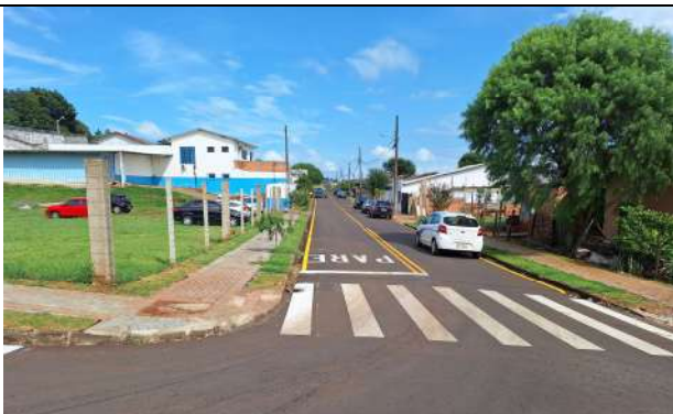
CALÇADA RUA CELESTE MOCELIN (FOTO 11)
