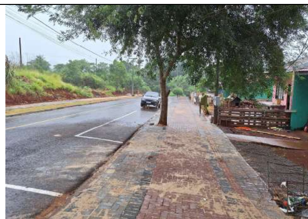
CALÇADA E SINALIZAÇÃO HORIZONTAL RUA MARÍLIA (FOTO 4)
