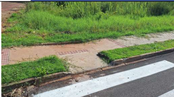
CALÇADA RUA ANDRÉ CAVALLI (FOTO 13)
