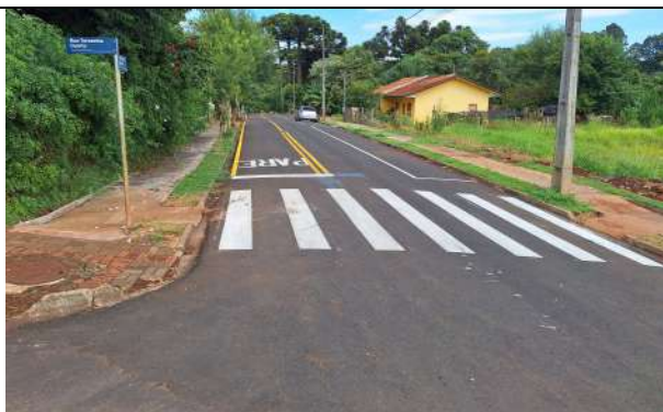
PAVIMENTAÇÃO EM CBUQ E SINALIZAÇÃO HORIZONTAL RUA CELESTE MOCELIN (FOTO 7)
