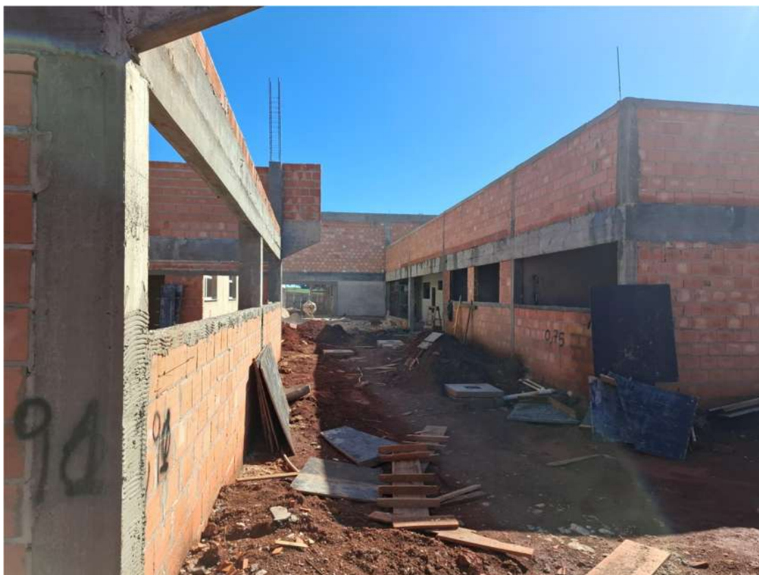
Foto 6: Bloco Administrativo – Vista Externa
