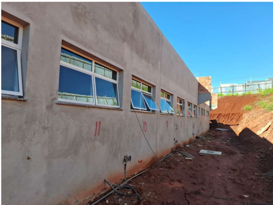
Foto 11: Bloco Consultórios Especializados – Vista Externa
