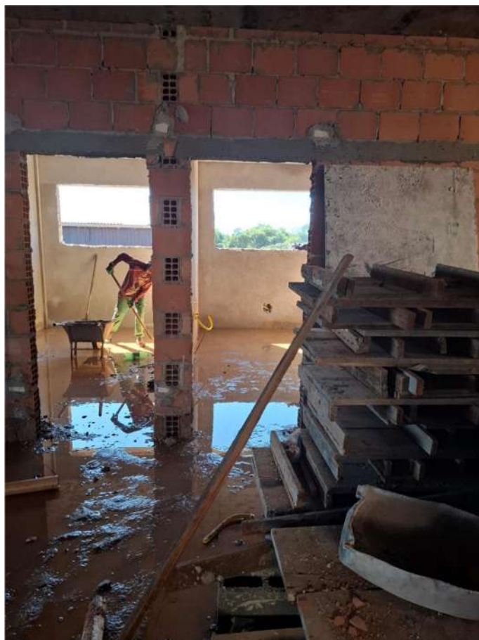
Foto 3: Bloco Salas CST. Clínico
