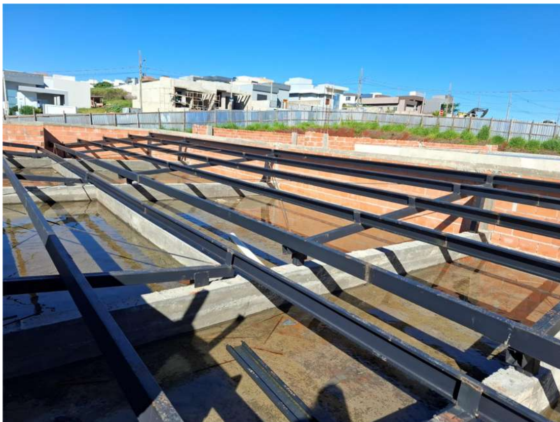
Foto 9: Estrutura Metálica Bloco Administrativo
