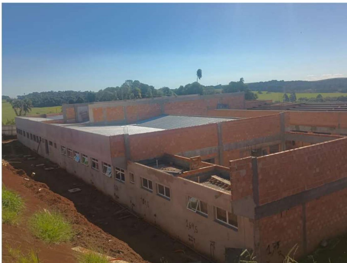
Foto 14: Blocos Ginásio/ Box Terapia, Consultórios Especializados e Salas de Terapia – Vista Externa
