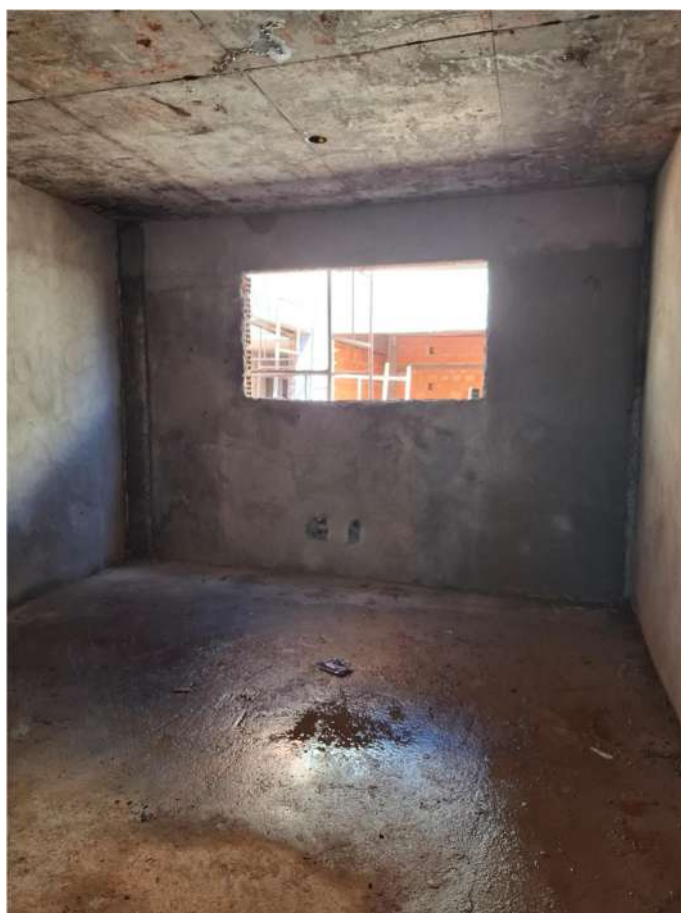
Foto 2: Bloco Salas CST. Clínico
