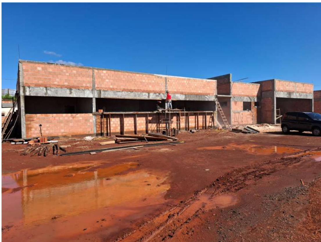
Foto 5: Bloco Administrativo – Vista Externa
