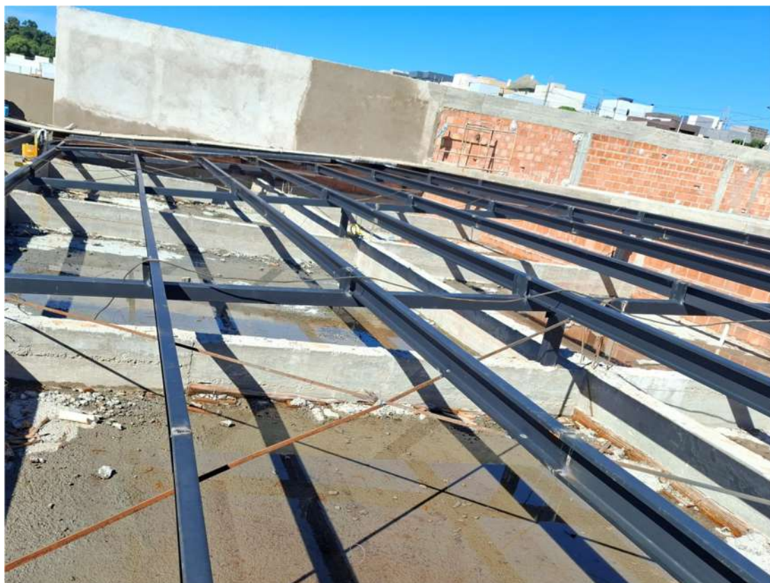
Foto 4: Estrutura Metálica Bloco Salas CST. Clínico
