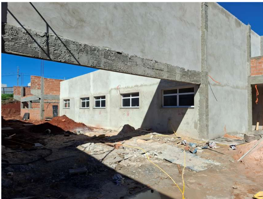
Foto 10: Bloco Consultórios Especializados – Vista Externa
