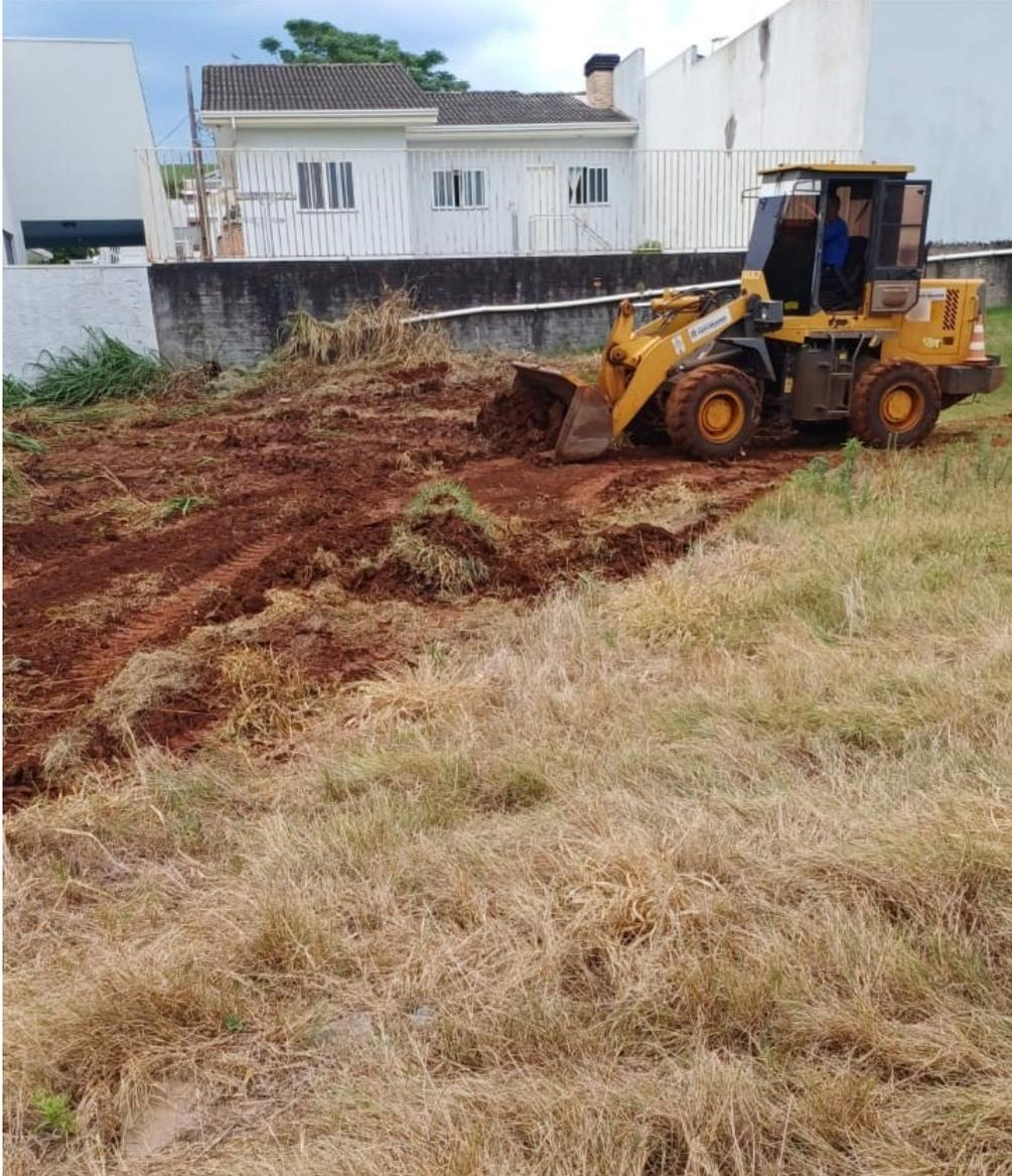
**Foto 1: Limpeza mecanizada do local.**
