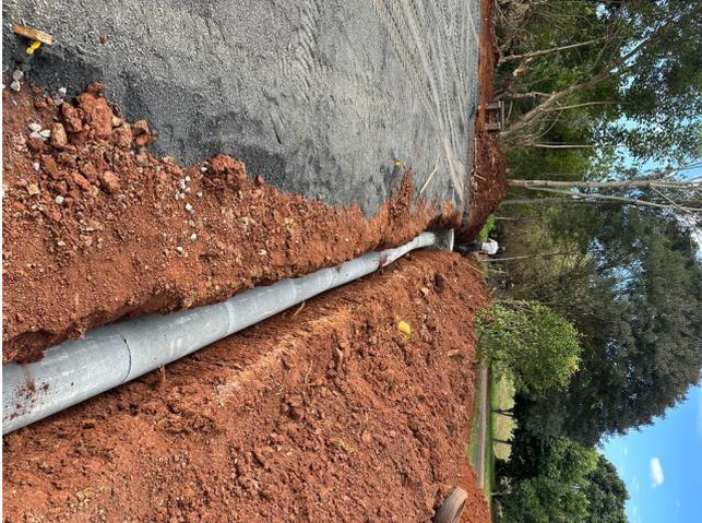
04-Tubos de concreto (simples) para redes coletoras de água pluvial
