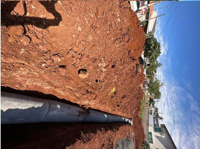
05-Tubos de concreto (simples) para redes coletoras de água pluvial
