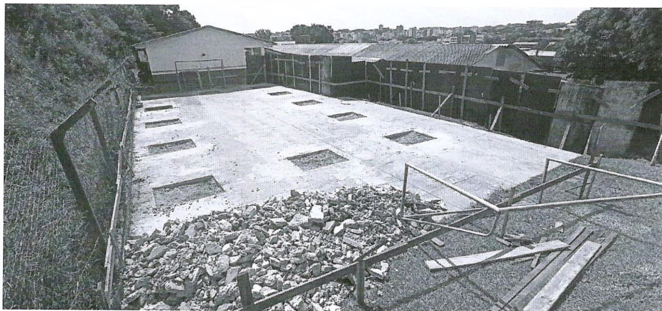
Foto 01: Marcação Fundações (locação)
