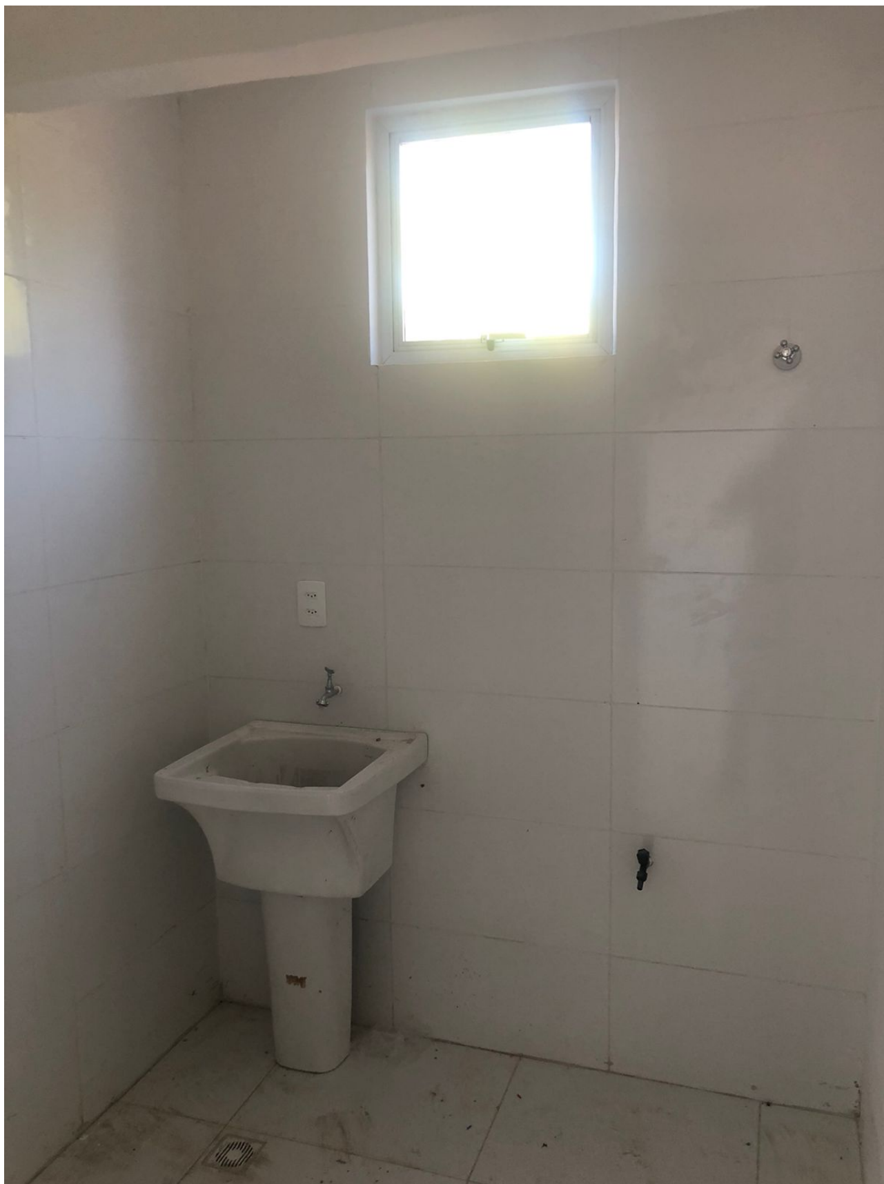
Foto 4: DML (tanque, paredes com revestimento cerâmico; pontos de água e esgoto.
