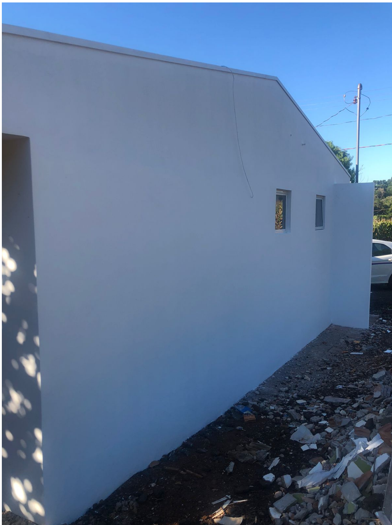
Foto 2: lateral da Unidade. Pintura externa e aberturas.
