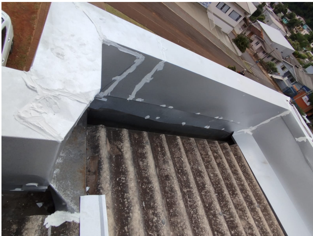
Foto 6: Reparo em rufos e calhas.
