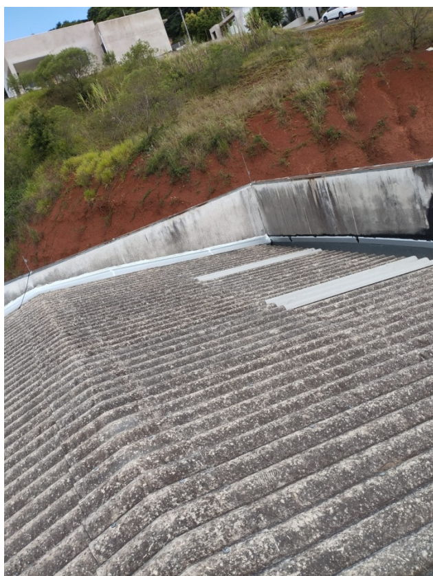
Foto 3: Troca de telhas em fibrocimento e reparo em rufos e calhas.
