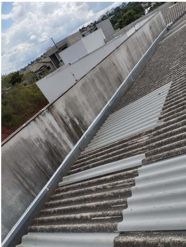
Foto 4: Troca de telhas em fibrocimento e reparo em rufos e calhas.
