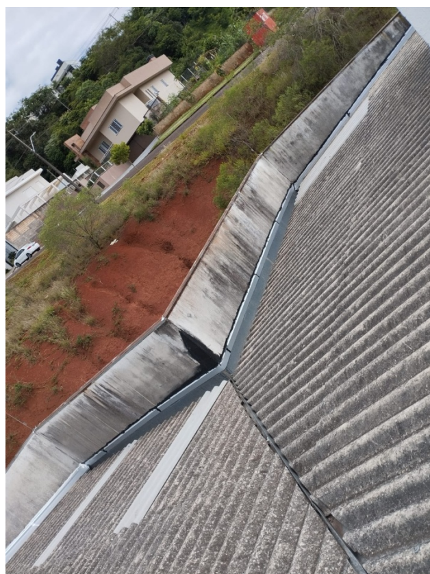
Foto 3: Troca de telhas em fibrocimento e reparo em rufos e calhas.
