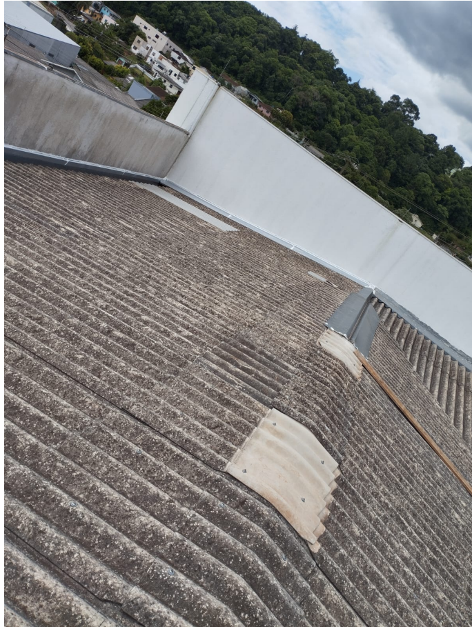
Foto 1: Troca de Cumeeira.
