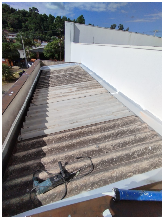
Foto 2: Troca de telhamento em fibrocimento.
