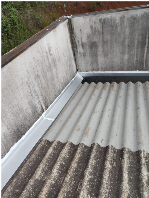
Foto 4: Troca de telhas em fibrocimento e reparo em rufos e calhas.
