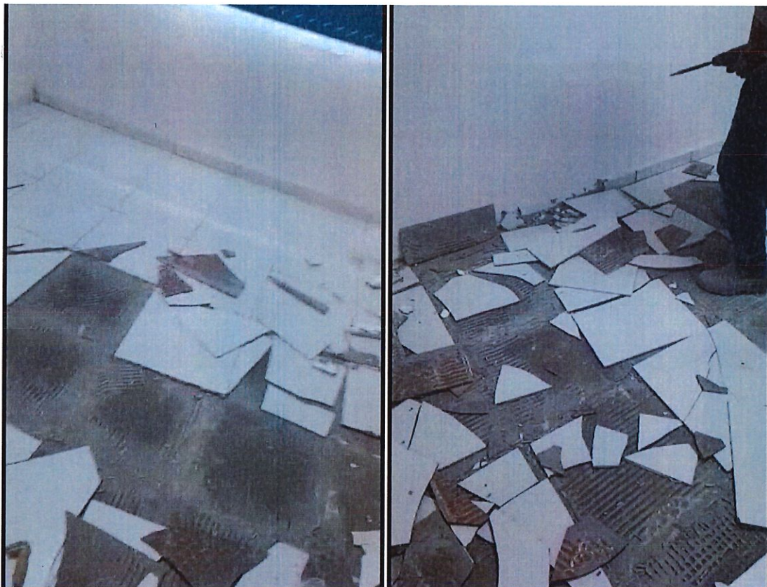
Foto 1: Demolição de Revestimento Cerâmico
