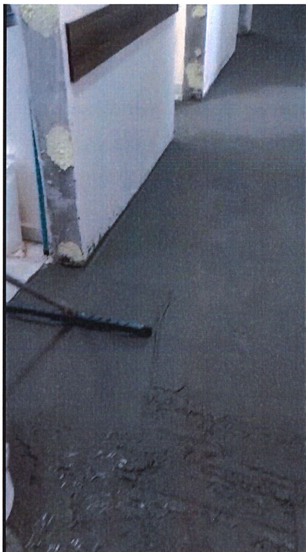
Foto 4: Contrapiso com argamassa
