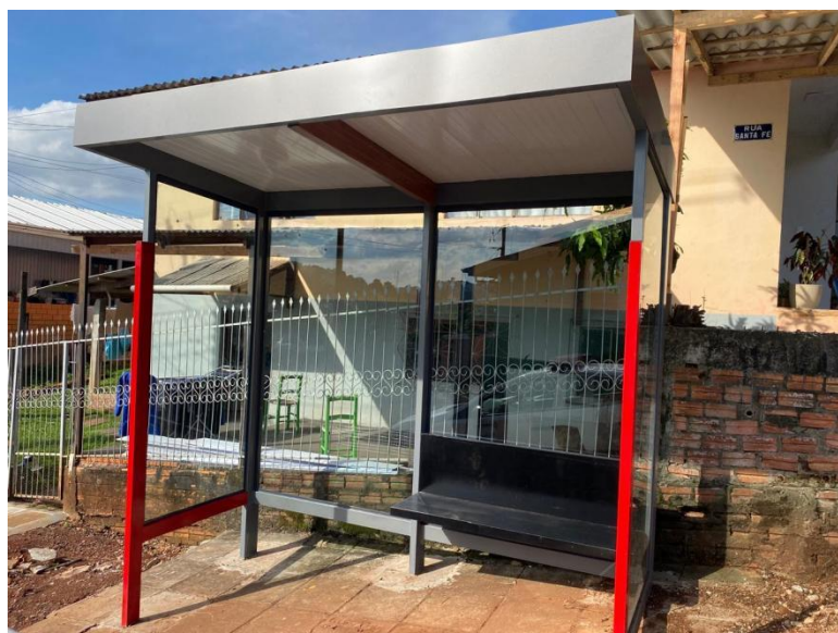
Rua Santa Fé, nº 149 - Bairro Industrial.
