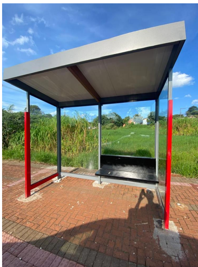
Rua Terezinha Duarte, nº S/N - Bairro São Roque.
